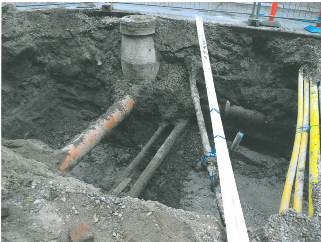
Kuva 27. Kirkkokatu, itäinen osa. Lähikuva edellisestä kohdasta. Pohjoisprofiilissa näkyy vanha viemäriputki, jonka täyttömaat näkyivät koko pohjoisprofiilin matkalla. Puhdas luonnollinen savi ulottuu puoleenväliin profiilia. Kuvaussuunta NNW. 3.9.2009.
