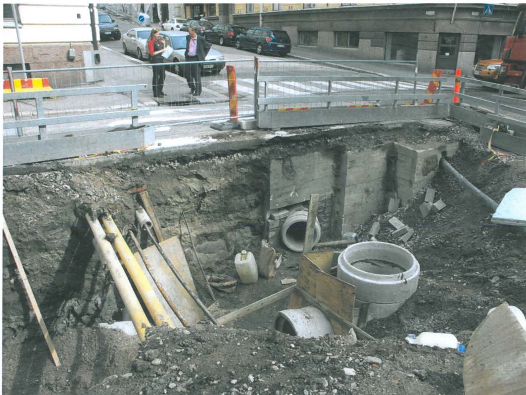
Kuva 16. Kirkkokatu, itäinen osa. Tämän kaivanto-osuuden pohjoisprofiilin itäpää Kirkkokadun ja Meritullinkadun risteyksen länsipuolella. Kuvassa näkyy betoninen kaivorakennelma, jonka vasemmalla puolella alhaalla näkyy keraaminen viemäriputki. Edessä on uusi kaivo ja putki. Kuvaussuunta NE. 13.8.2009.
