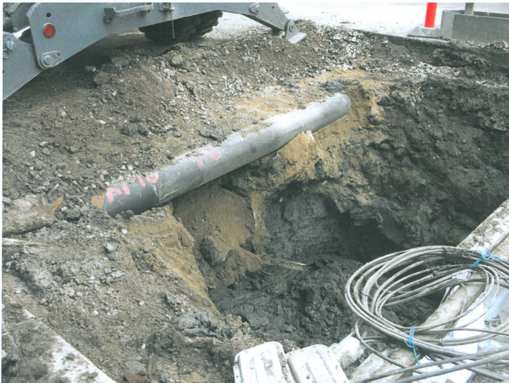
Kuva 12. Kirkkokatu, itäinen osa. Tämän kaivanto-osuuden länsipää. Kaukojäähdytysputken alla näkyy vanhan kiviviemärin puita ja seinäkiviä. Oikealla näkyy vanhan viemärin suuntainen uudempi viemäriputkilinjan täyttömaita. Kuvaussuunta NW. 13.8.2009.
