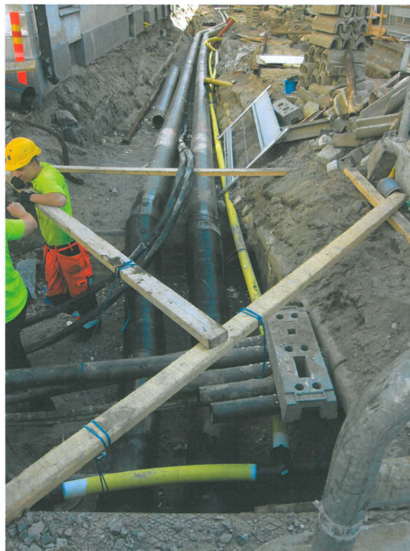
Kuva 504. Katariinankatu. Edelliseen kohtaan on asennettu kaukojäähdytysputket. Kuvaussuunta S. 5.7.2011.
