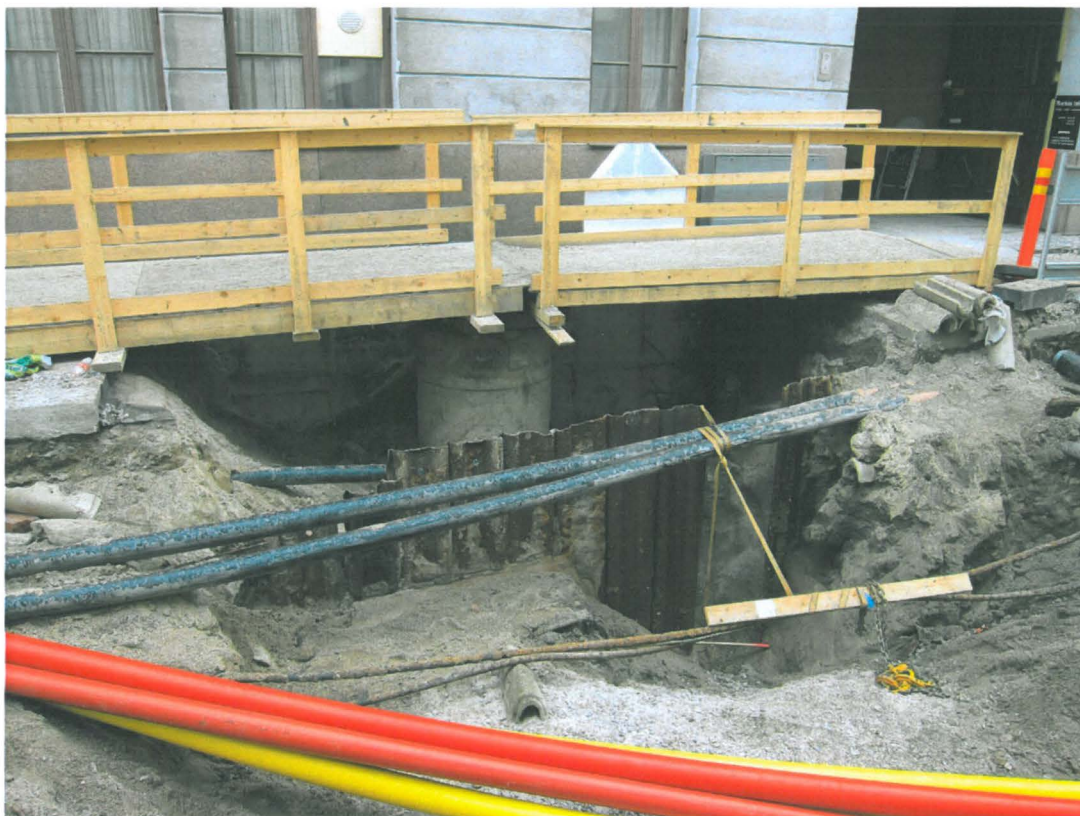
Kuva 459. Katariinankatu. Kaupungintalon sisäpihalle johtavan ajokäytävän eteläpuolella oli vanha metalliponttiseinä. Kuvaussuunta NWW. 23.6.2011.
