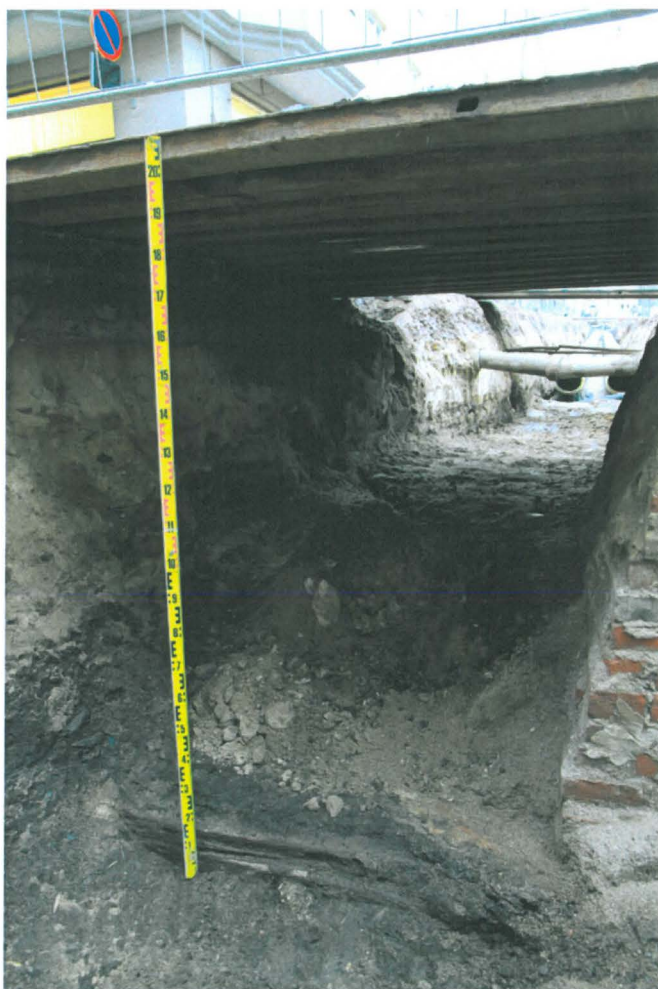
Kuva 214. Rauhankatu. Ritarikadun kaivanto yhtyy Rauhankadun kaivantoon Rauhankadun ajosillan kohdalla. Oikealla on tiilirakenteinen viemärikaivo. Kuvaussuunta SSE. 11.12.2009.
