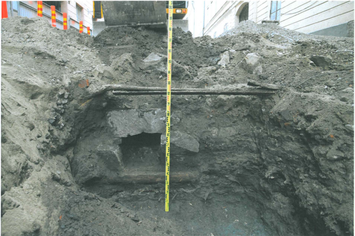
Kuva 441. Katariinankatu. Kiviviemäristä (profiili K 1) on näkyvissä koko rakenne ja ympäristö melkein puhtaaseen saveen saakka. Kuvaussuunta N. 13.6.2011.
