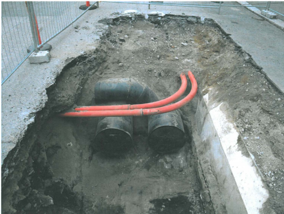
Kuva 107. Kirkkokatu, läntinen osa. Vuoden 2006 putkien päät ja oikealla vanhemmat kaukolämpöputkien betonisuojat. Kuvaussuunta S. 9.11.2009.
