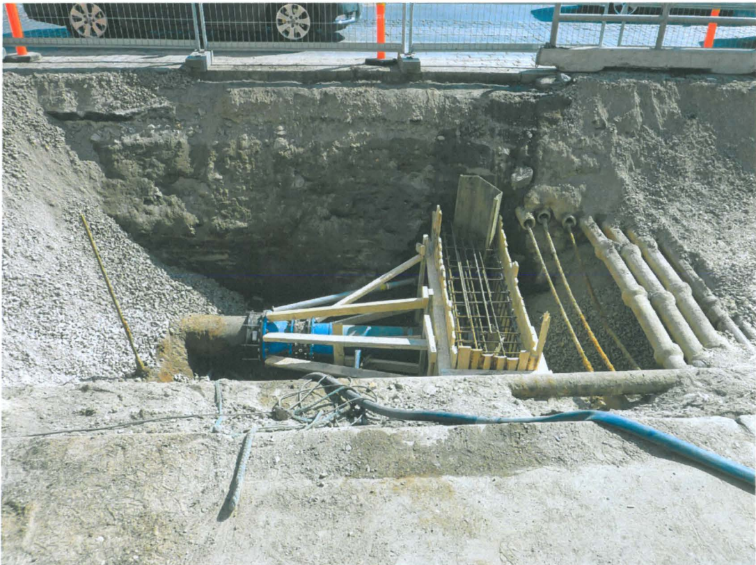
Kuva 418. Pohjoisesplanadi. Uuden ja vanhan putken liitoskohta. Kuvaussuunta S. 11.5.2011.
