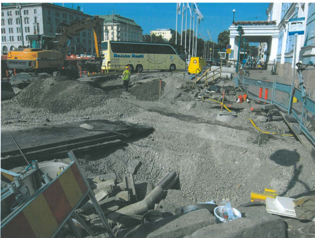
Kuva 412. Pohjoisesplanadi. Raitiotiekiskojen perustusta valmistellaan. Kuvasuunta SWW. 11.7.2011.
