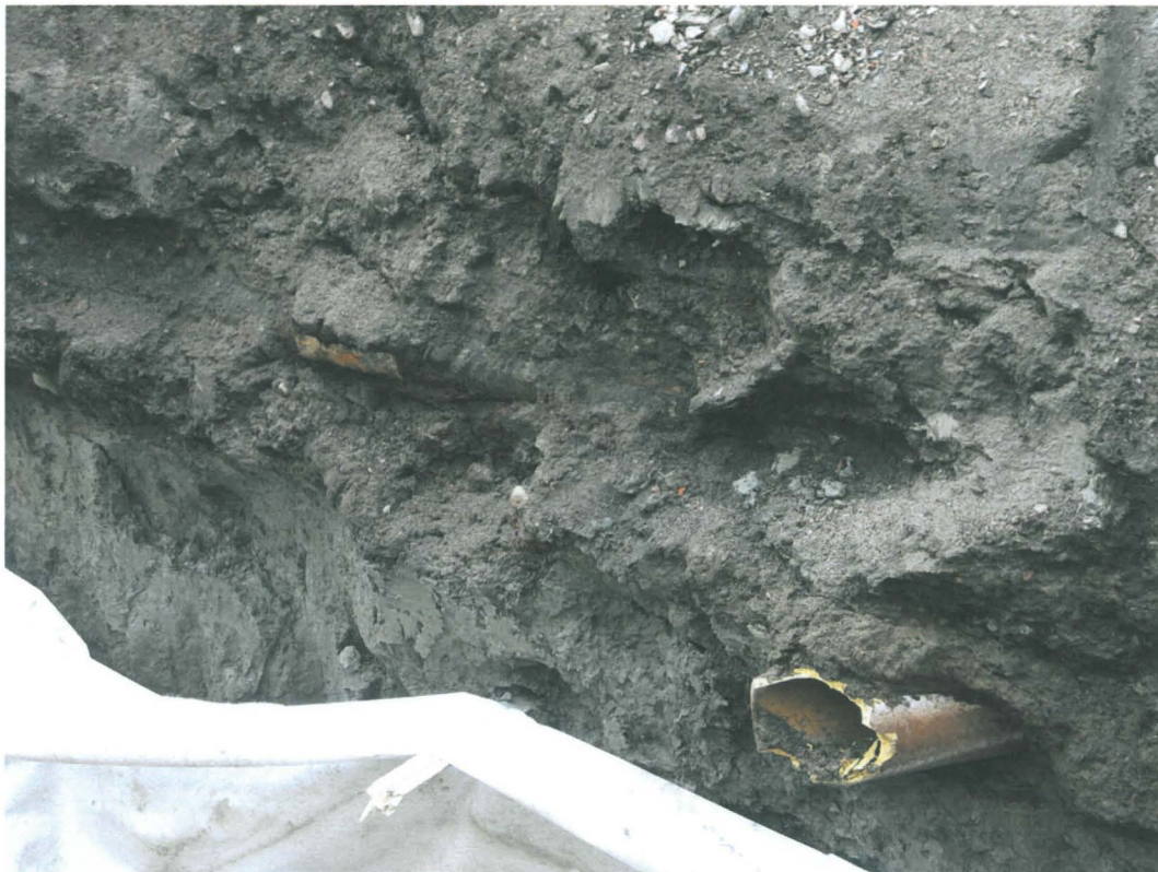
Kuva 13. Kirkkokatu, itäinen osa. Tämän kaivanto-osuuden eteläprofiilia keskiosasta. Luonnollisen saven ja uudehkon täyttömaan rajalla näkyy poikittainen keraaminen putki ja ylempänä metallinen kaasuputki. Kuvaussuunta SE. 13.8.2009.
