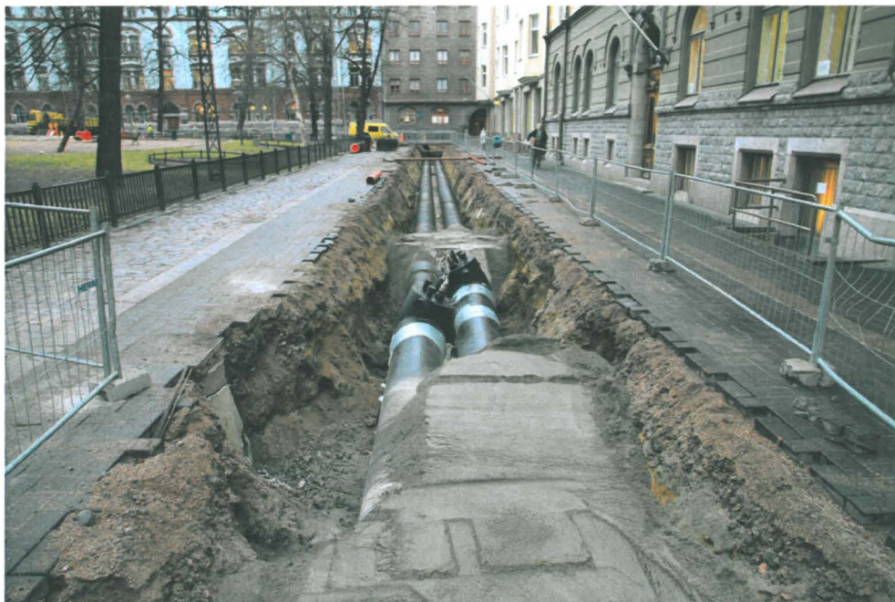
Kuva 213. Ritarikatu. Kaivantoon on asennettu kaukojäähdytysputket. Kuvaussuunta N. 1.12.2009.
