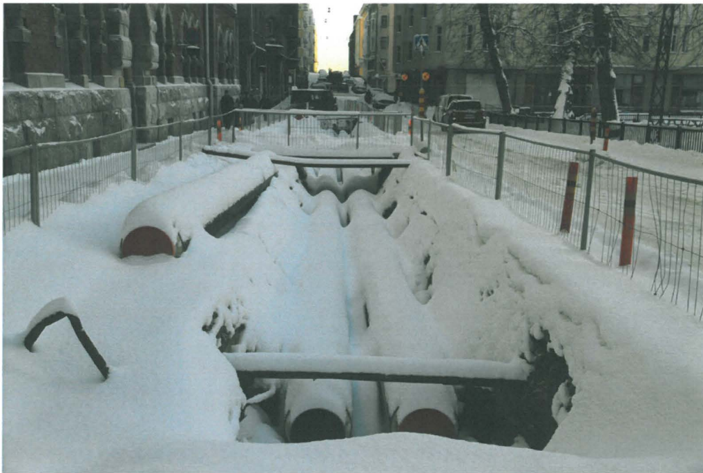
Kuva 254. Rauhankatu. Kaivantoon on asennettu Rauhankatu 13:n kohdalla lumen peittämät kaukojäähdytysputket. Kuvaussuunta E. 4.1.2010.
