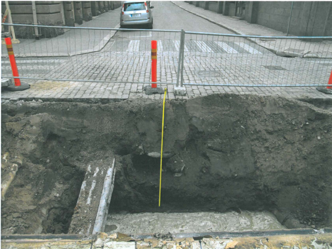
Kuva 185. Kirkkokatu, läntinen osa. Edellinen kohta. Eteläprofiilissa näkyy kiviviemärin jäännökset (havaintopiste KL 6). Kuvaussuunta S. 13.11.2009.
