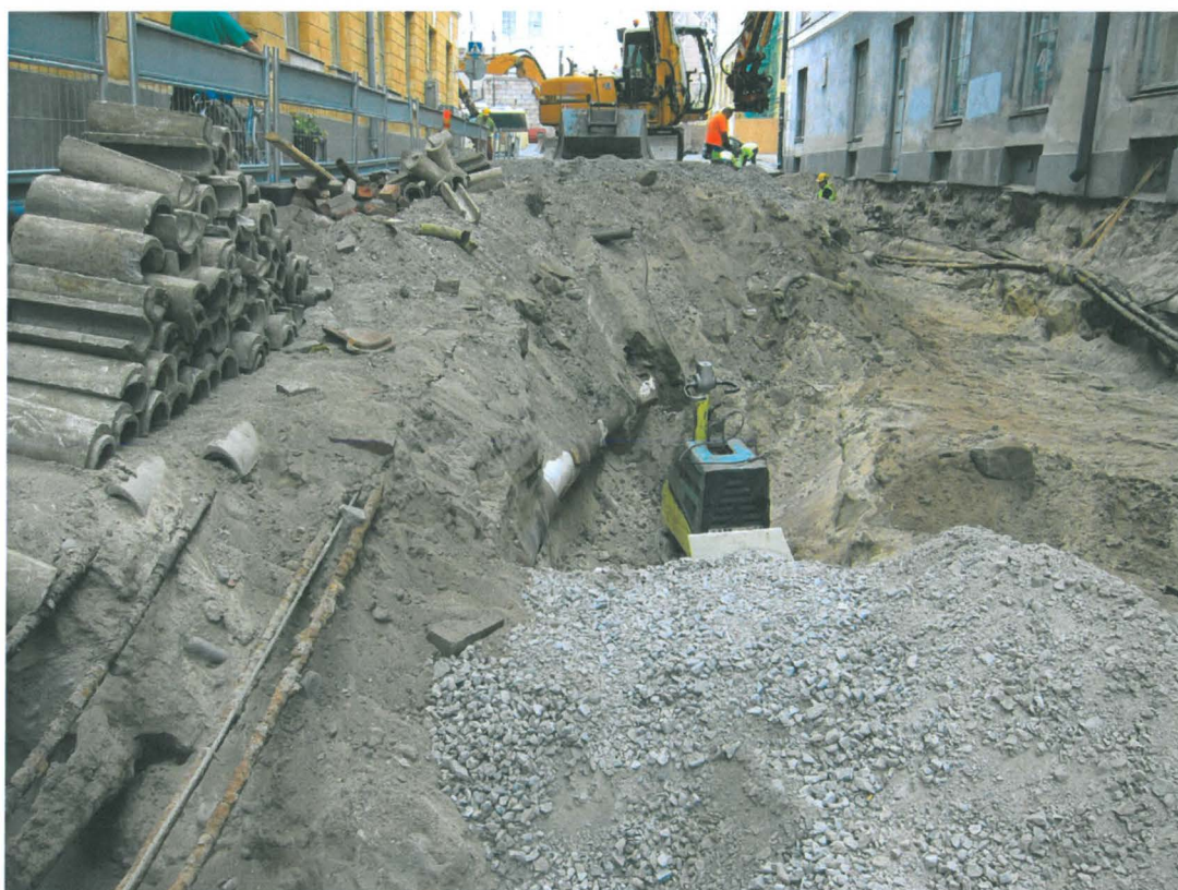
Kuva 486. Katariinankatu. Profiili K 3:n kiviviemäri tärästyskoneen kohdalta on poistettu. Kuvaussuunta N. 4.7.2011.
