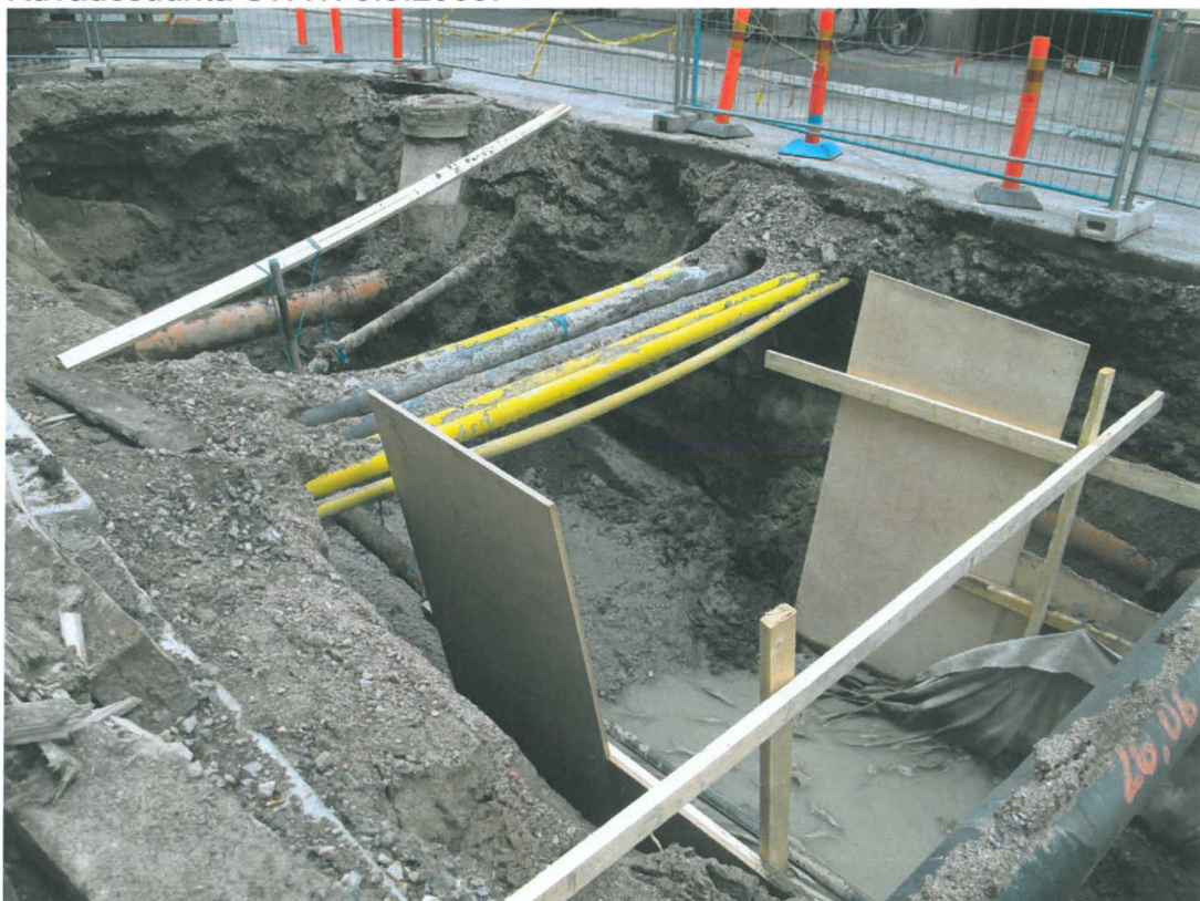
Kuva 24. Kirkkokatu, itäinen osa. Edellisen kaivanto-osuuden länsipää putkineen ja johtoineen. Kuvan oikeassa reunassa on poikittainen kaukojäähdytysputki. Kuvaussuunta NW. 3.9.2009.
