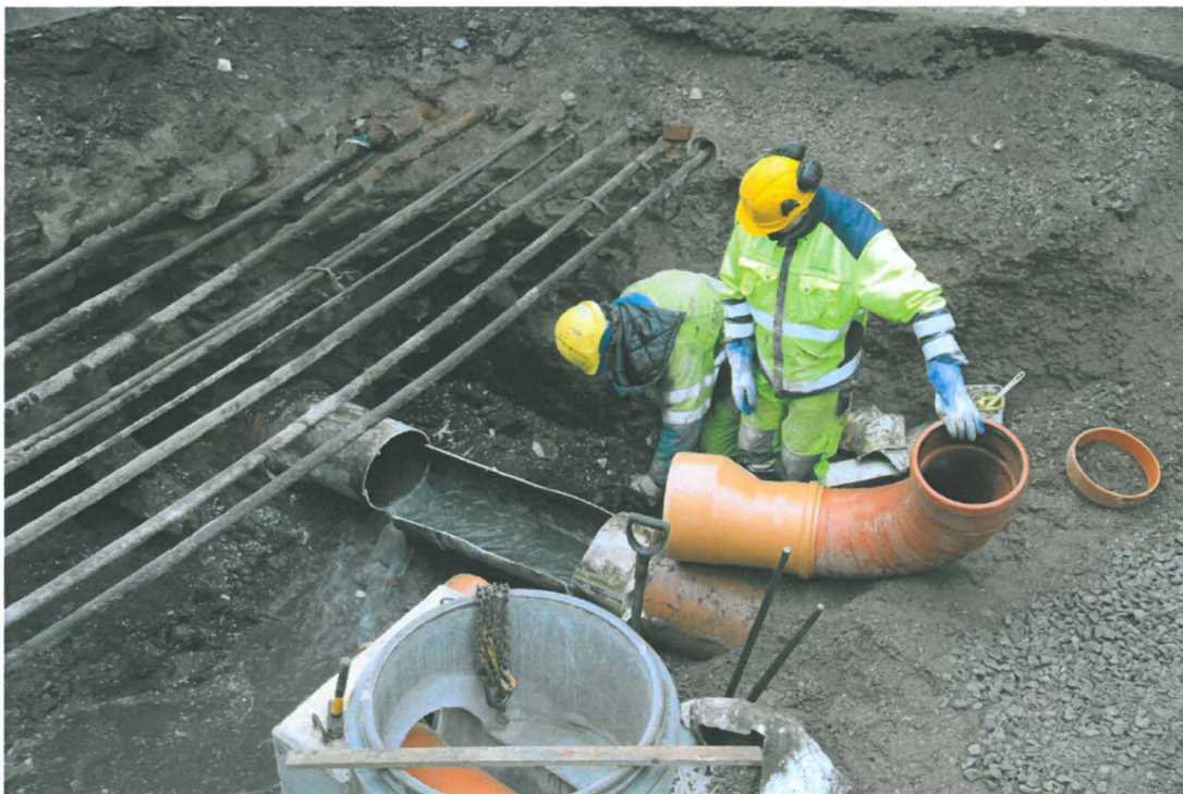
Kuva 91. Kirkkokatu, itäinen osa. Vanhan ja uuden sadevesiviemäriputken liitoskohdan kulmaputkitusta valmistaudutaan asentamaan. Kuvaussuunta NW. 1.12.2009.
