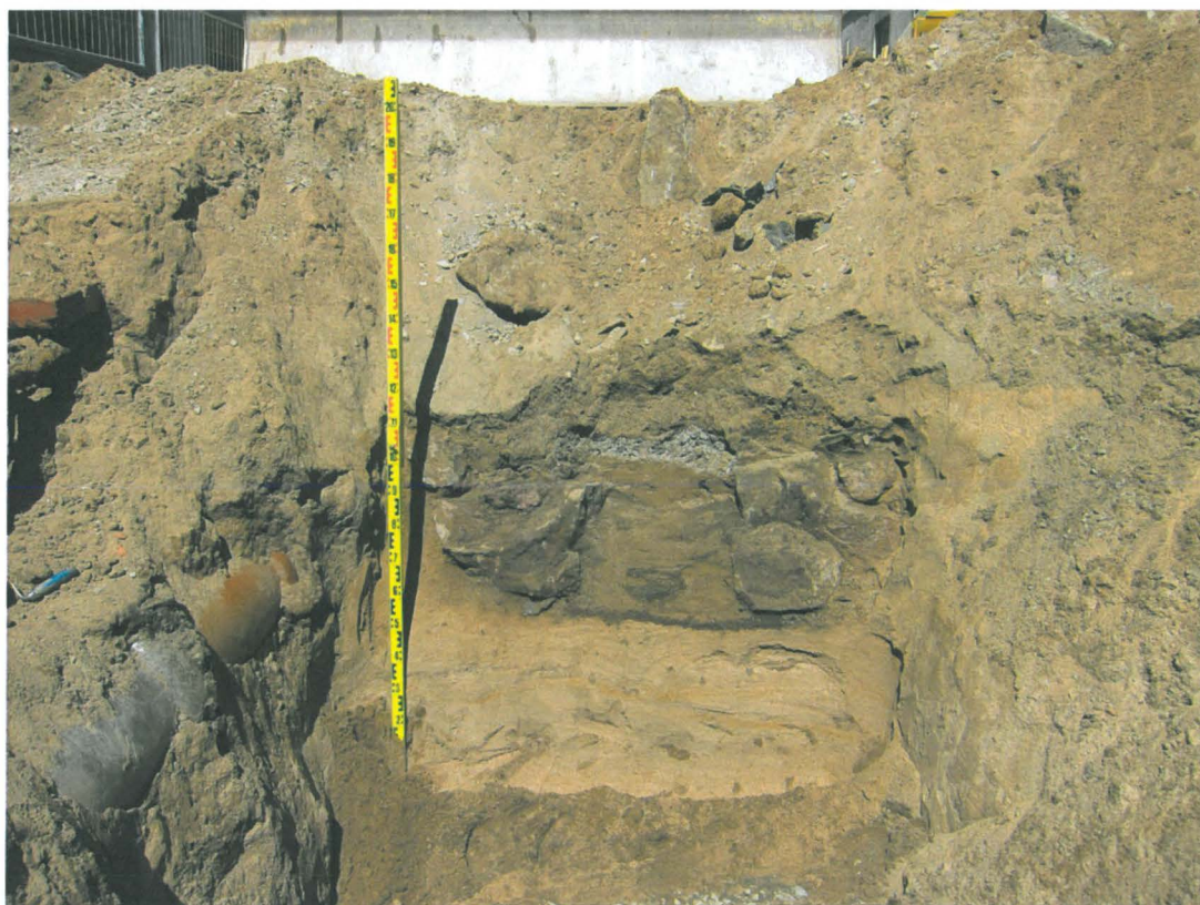
Kuva 472. Katariinankatu. Kiviviemäri ( profiili K 2 ). Viemärin alta hiekkamaassa puuttuu isot hirret. Kattokivi on irronnut kaivettaessa. Vasemmalla näkyy lähemmäksi tuleva keraaminen viemäriputki. Kuvaussuunta N. 29.6.2011.
