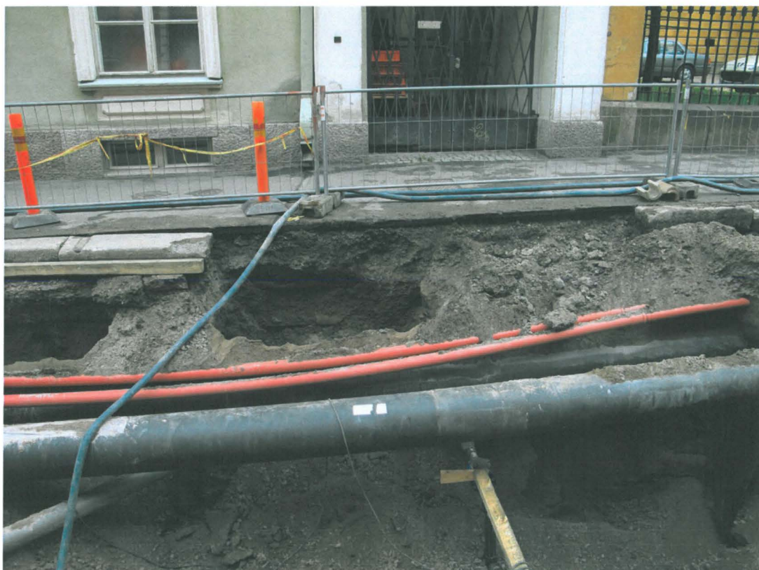
Kuva 52. Kirkkokatu, itäinen osa. Tämän kaivanto-osan eteläprofiilia Kirkkokatu 6:n länsiosassa. Vuoden 2006 kaukojäähdytysputkikaivannon hiekat ovat valuneet putkien alta ja takaa pois. Kuvaussuunta S. 20.10.2009.
