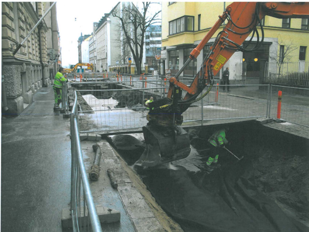
Kuva 182. Kirkkokatu, läntinen osa. Kirkkokatu 9:n ajokäytävän kohdalla laitetaan kankaita ja hiekkoja. Kuvaussuunta SEE. 18.11.2009.
