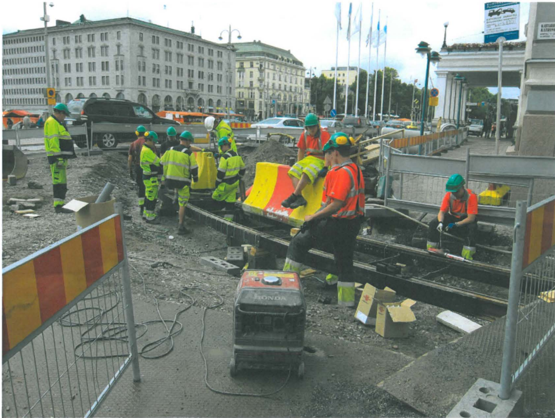
Kuva 413. Pohjoisesplanadi. Raitiotiekiskoja asennetaan. Kuvaussuunta SW. 12.7.2011.
