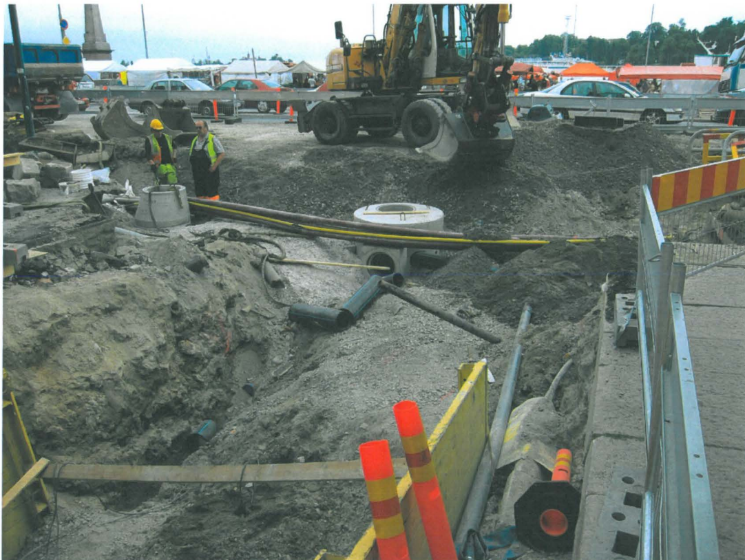
Kuva 410. Pohjoisesplanadi. Edellisen kohdan pohjoispuolella jalkakäytävälínjalle on asennettu uudet kaivot. Kuvaussuunta SSE. 5.7.2011.
