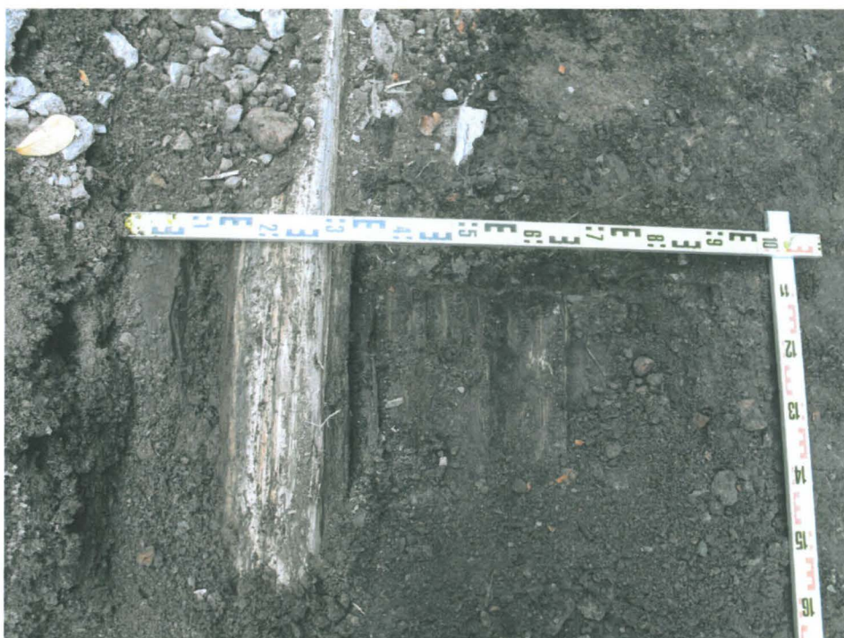
Kuva 137. Kirkkokatu, läntinen osa. Aivan edellisen havaintopisteen kaakkoispuolella kaivettiin kaivannon tavoitetasen alapuolelta esiin kiviviemärin puuarinan neljä pitkittäistä hirttä ( alue KL 1 ). Kuvaussuunta W. 12.11.2009.
