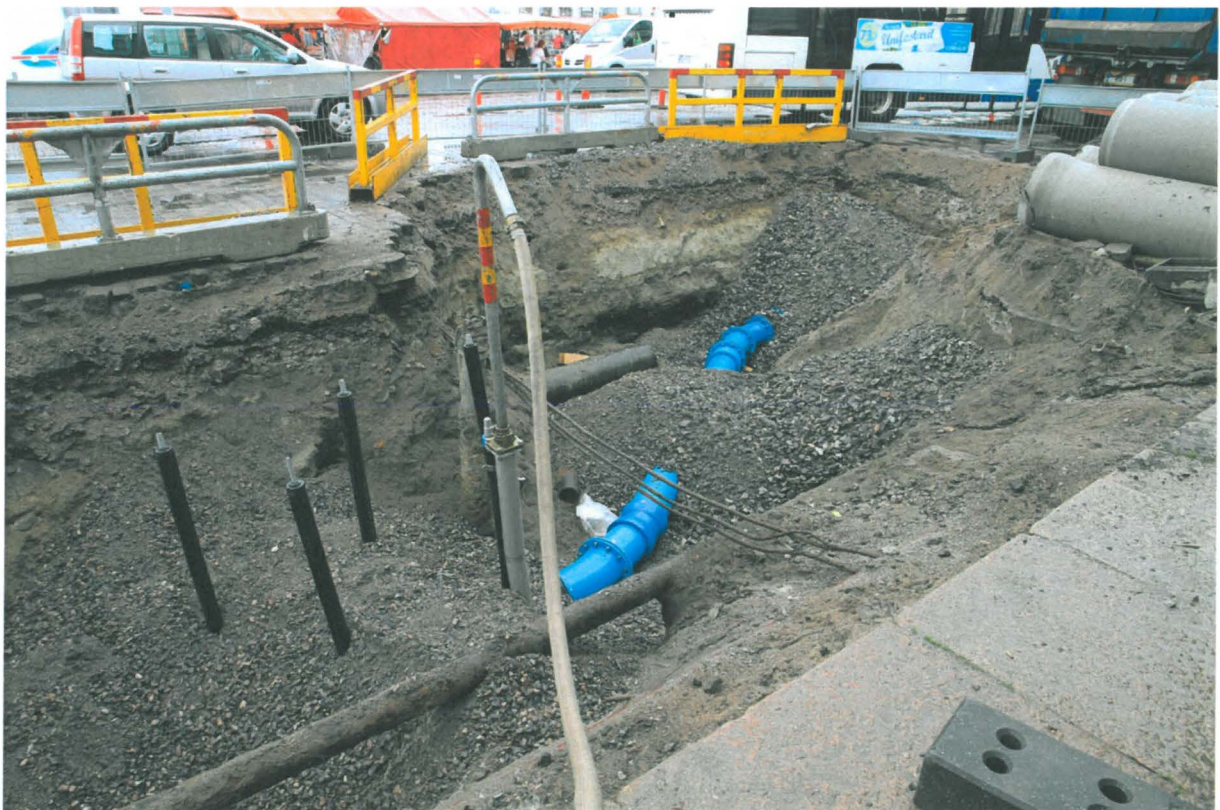
Kuva 398. Pohjoisesplanadi. Havaintopiste P 1:n ympäristön uudet putkiliitokset ovat valmiina ja kaivanto on osittain täytetty. Kuvaussuunta SW. 16.6.2011.
