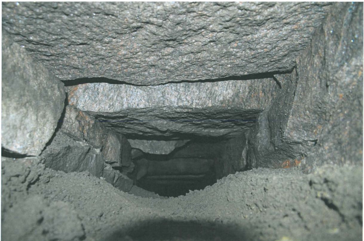
Kuva 446. Katariinankatu. Kiviviemärin sisäosat. Viemäri oli osittain täyttynyt hiekalla. Kuvaussuunta N. 13.6.2011.
