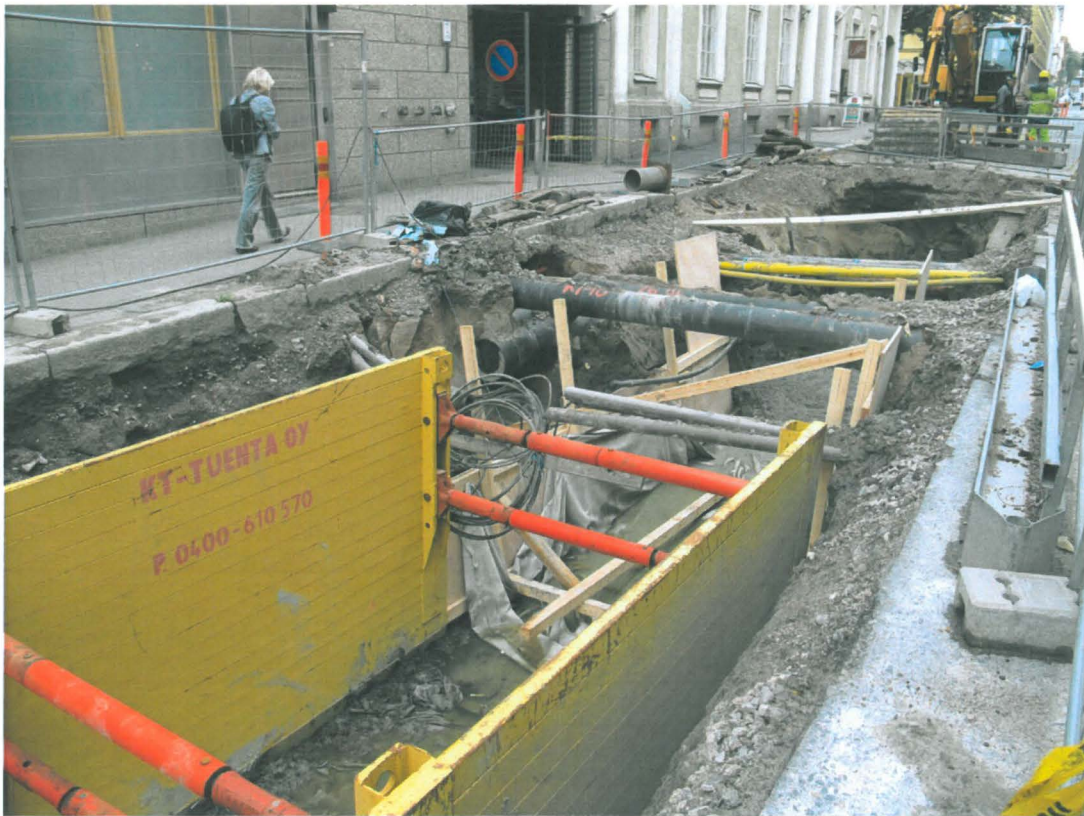
Kuva 23. Kirkkokatu, itäinen osa. Kaivanto Kirkkokatu 4:n länsiosan kohdalla. Kuvan keskellä näkyy jalkakäytävän vieressä ajoradalle vuonna 2006 laitettut kaukojäähdytysputket ja poikittainen putki kadun poikki. Kuvaussuunta SWW. 3.9.2009.
