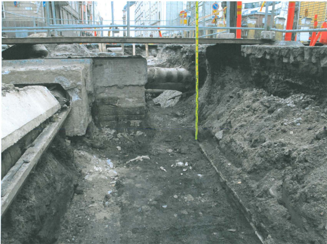
Kuva 132. Kirkkokatu, läntinen osa. Edellinen kaivanto-osa itäpään betonirakenteiden kohdalla. Kaivannon pohjan oikeassa reunassa näkyy kiviviemärin puuarinan yksi puu. Kuvaussuunta E. 12.11.2009.
