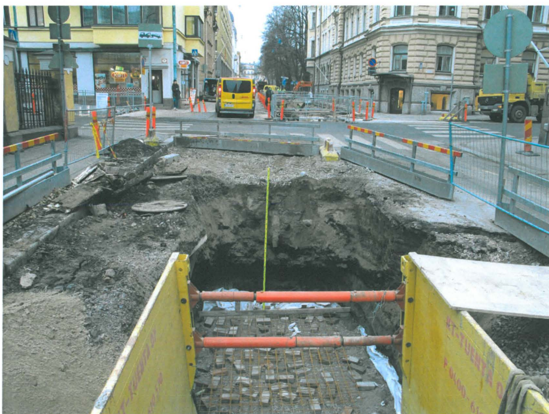
Kuva 80. Kirkkokatu, itäinen osa. Kaivanto Kirkkokatu 8:n länsiosan kohdalla. Kiviemäri näkyy kaivannon länsipäässä edelleen melko lähellä nykyistä katupintaa. Kuvaussuunta W. 17.11.2009.
