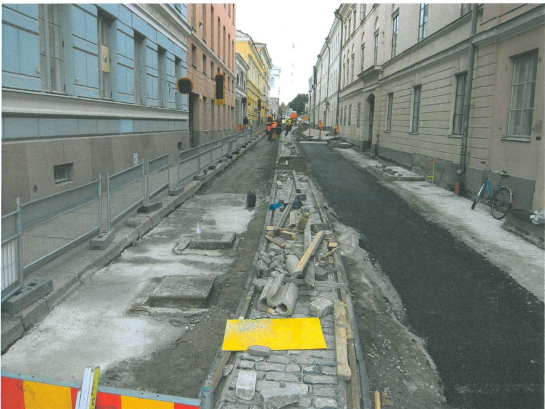
Kuva 518. Katariinankatu. Kadun pinnoitteiden perustuksiin on lisätty asfalttia. Kuvaussuunta N. 8.8.2011.
