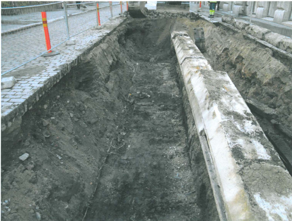
Kuva 125. Kirkkokatu, läntinen osa. Kaivantoa Kirkkokatu 9:n itäosan kohdalla. Kaivannon eteläosan kohdalla on sijainnut kiviviemäri, josta oli jäljellä puuarinan pitkittäiset hirret. Yksi hirsirivi näkyy pohjan vasemmassa reunassa. Eteläprofiilin takana on heti kadunsuuntainen viemäri linja. Pohjoisosassa oli kaukolämmitysputkien betoniset suojarakenteet. Niiden pohjat sijaitsivat korkeammalla kuin kaukojäähdytyskaivannon pohja. Uudet kaukolämmitysputket asennettiin entiselle korkeudelle. Kuvaussuunta W. 11.11.2009.
