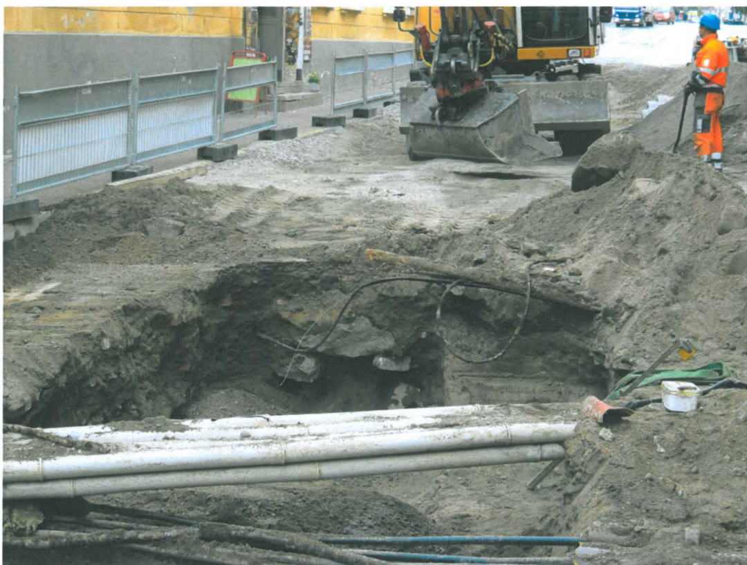
Kuva 461. Katariinankatu. Kiviviemäri kuvattuna lähempää. Kuvaussuunta NW. 23.6.2011.
