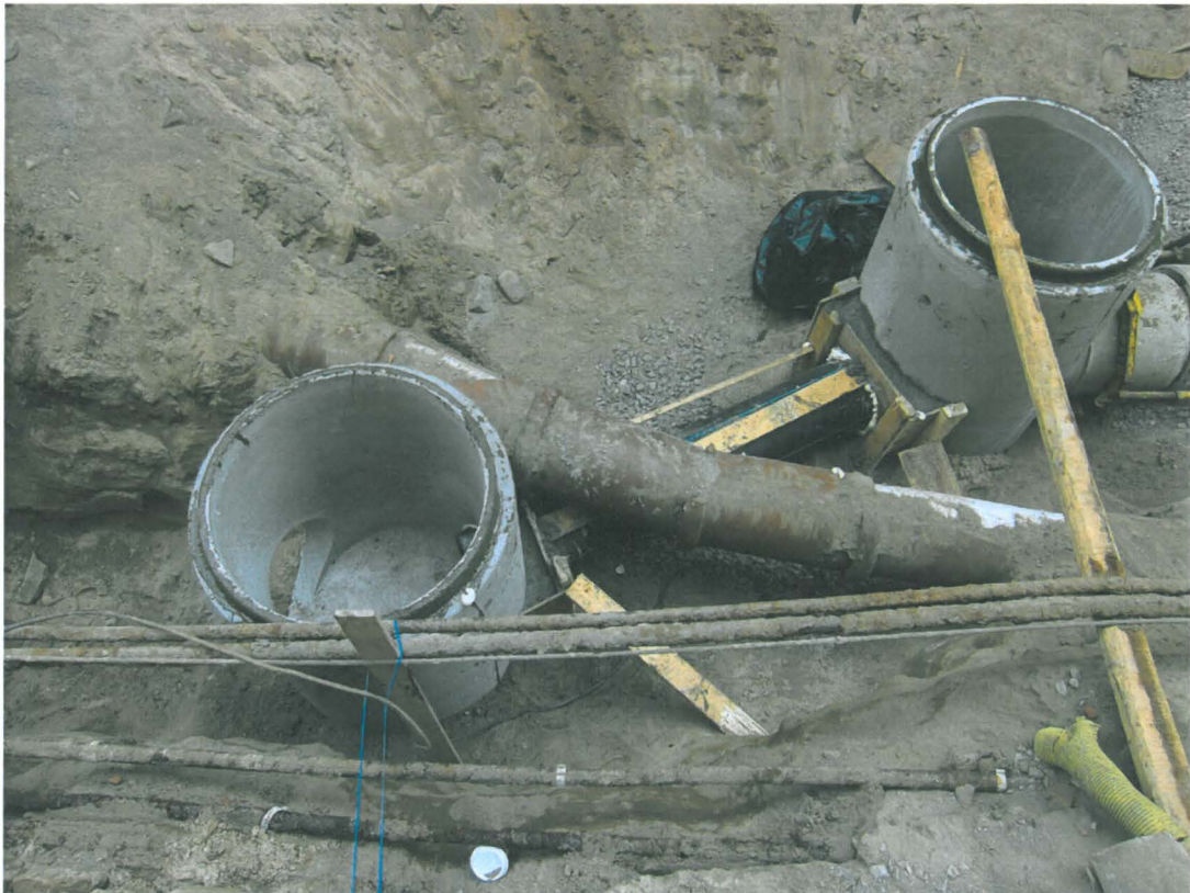
Kuva 493. Katariinankatu. Vanha keraaminen putki jäi edellisen kohdan lounaispuolella uusien kaivojen ja putkien väliin. Kohdalla oli sijainnut kiviviemärin profili K 3 . Kuvaussuunta E. 7.7.2011.
