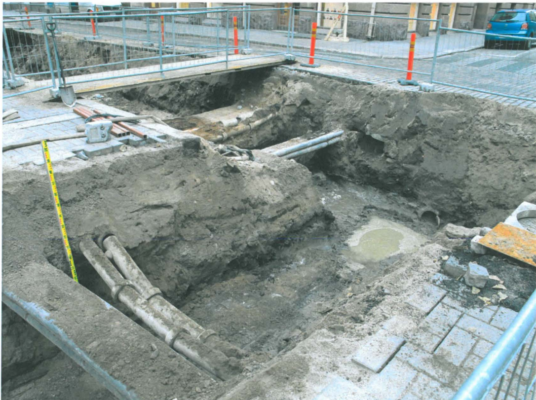
Kuva 194. Ritarikatu. Kaukojäähdytysputkikaivanto eteläpäässään Ritarikadun ja Kirkkokadun risteyksessä. Kaivannon linjalla on sijainnut käytöstä poistettu viemäri linja, jonka putki näkyy kaivannon pohjalla oikealla. Kuvaussuunta SE. 17.11.2009.
