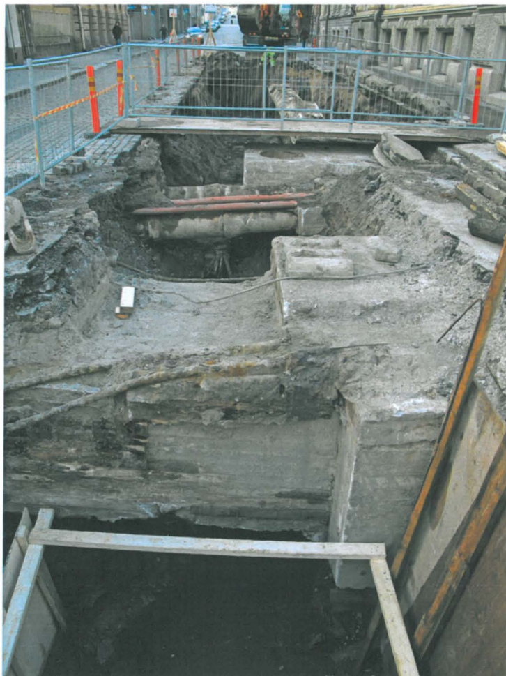
Kuva 120. Kirkkokatu, läntinen osa. Kaukojäähdytysputkikaivanto kaivettiin pohjoisen ajoradan kohdalle. Kuvaussuunta W. 11.11.2009.
