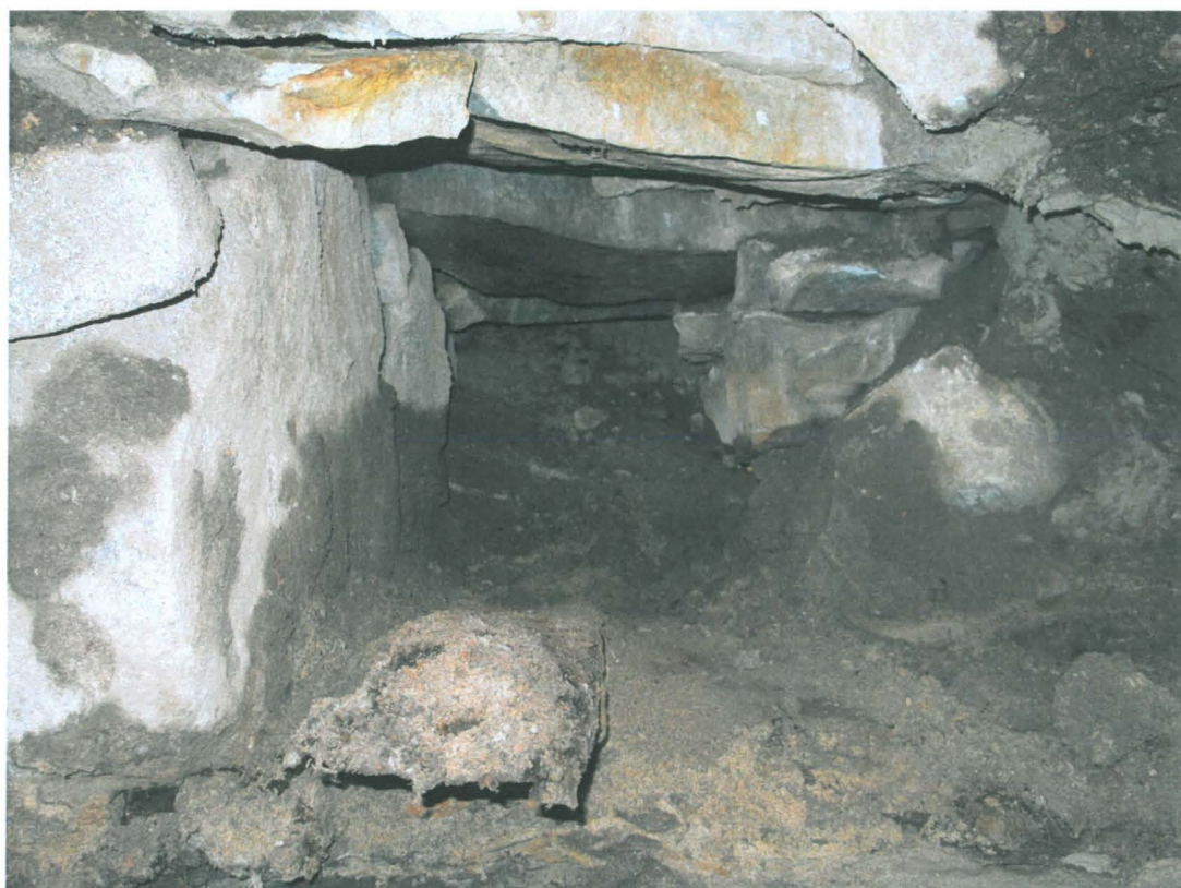
Kuva 50. Kirkkokatu, itäinen osa. Lähikuva kiviviemärin sisäosista. Kuvaussuunta W. 20.10.2009.
