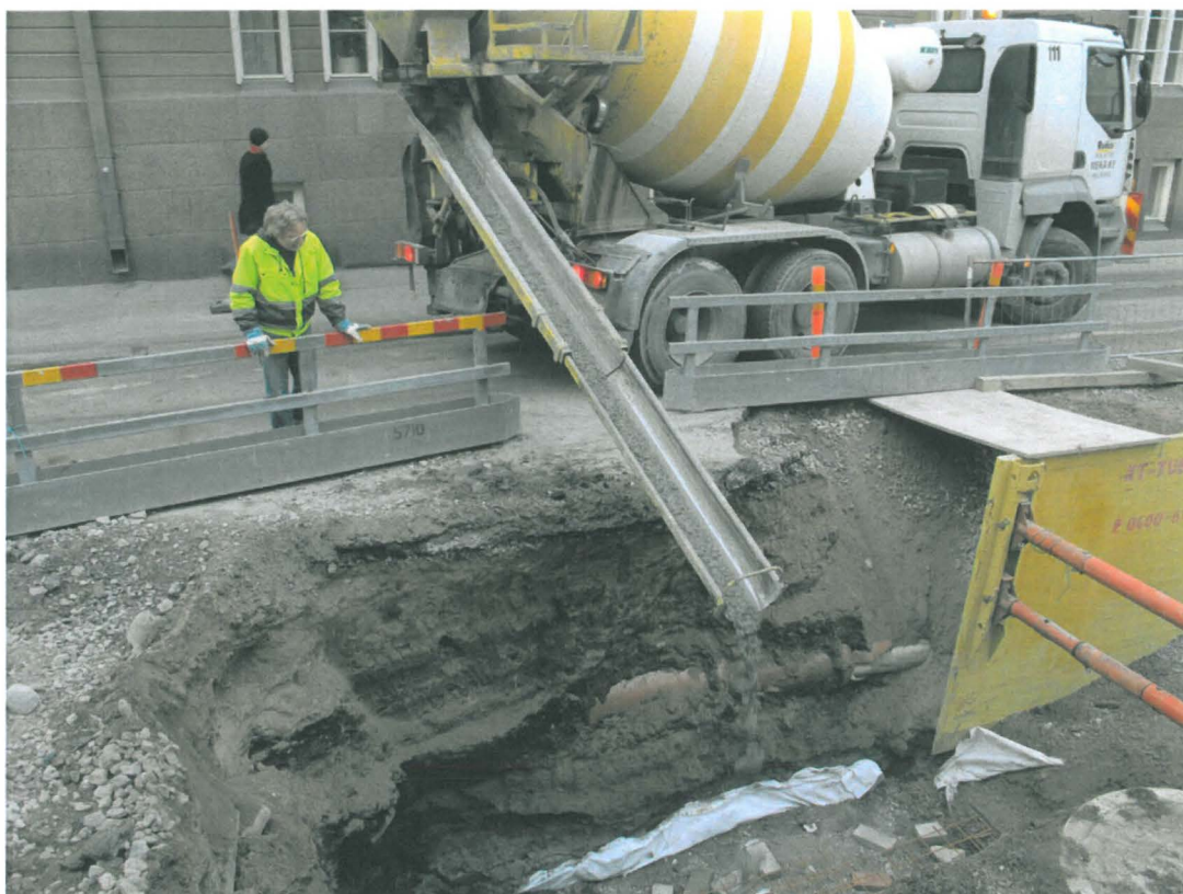
Kuva 87. Kirkkokatu, itäinen osa. Kaivannon pohjalaattaa tehdään. Kuvaussuunta W. 17.11.2009.
