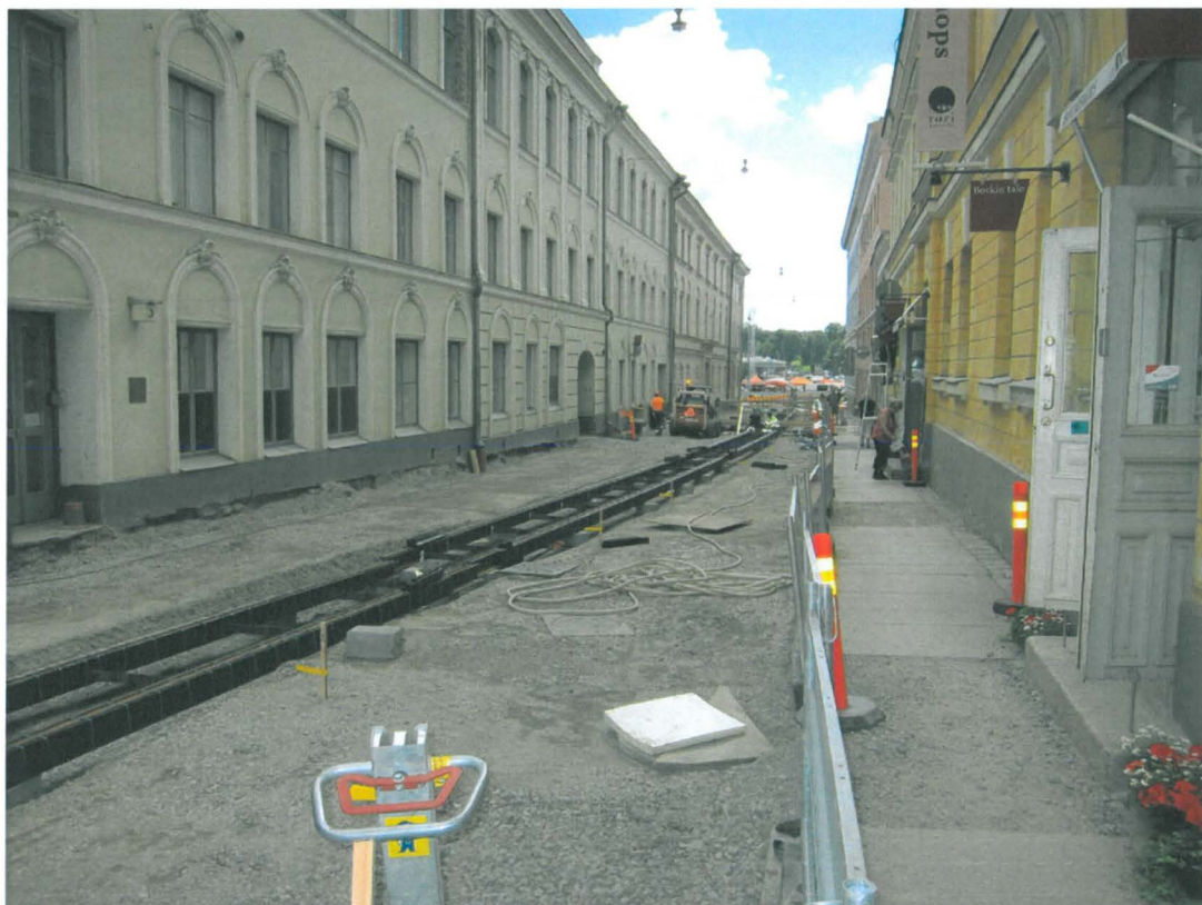
Kuva 514. Katariinankatu. Raitiotiekiskoja asennetaan uuteen kohtaan. Kuvaussuunta S. 1.8.2011.
