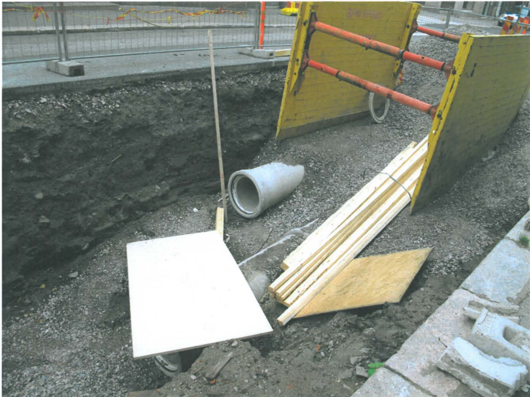
Kuva 21. Kirkkokatu, itäinen osa. Uudet putket on laitettu kaivantoon. Kuvasuunta NE. 3.9.2009.
