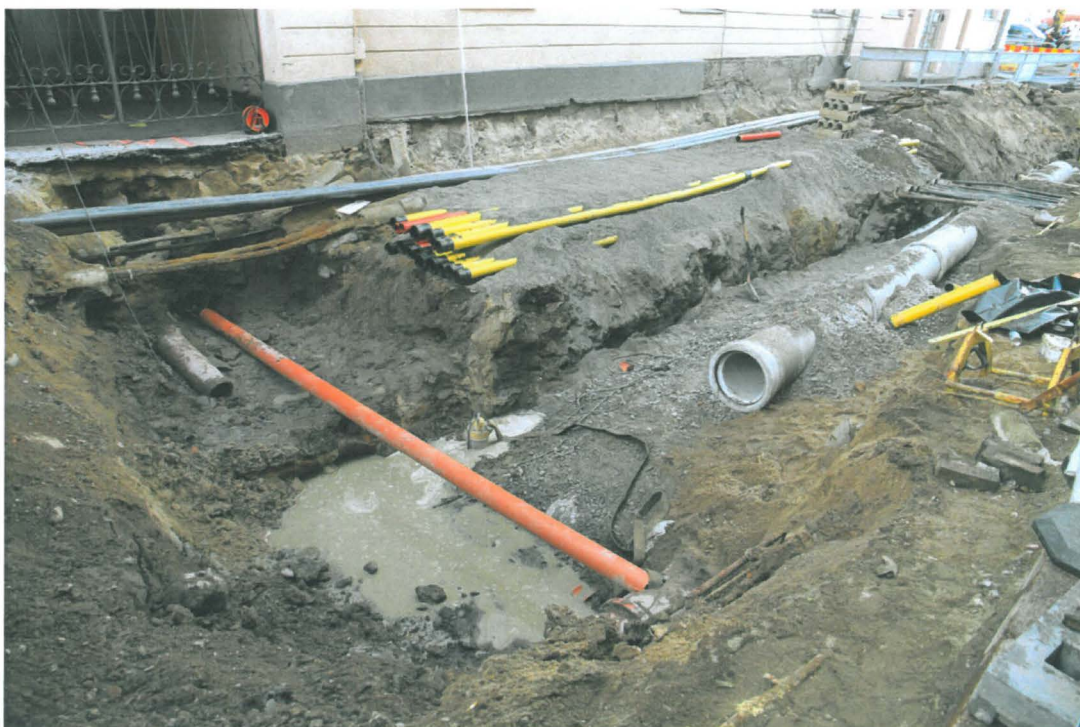
Kuva 453. Katariinankatu. Kaivanto itäpuolella sijaitsevan Goviniuksen taloon vievän ajokäytävän kohdalla. Pääkaivannon itäprofiilin linjalla vesilammikon reunalla näkyy vanha kartoissa näkymätön putki. Havaintopiste K 2 sijaitsi vastaavassa kohdassa kaivannon länsiprofiilissa. Kuvaussuunta SE. 16.6.2011.
