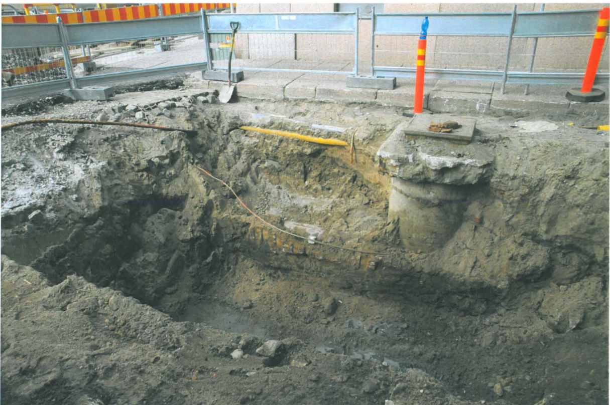
Kuva 430. Katariinankatu. Edellinen tilanne. Keraaminen viemäriputki näkyy kaivannon itäprofiilin alaosassa. Kuvaussuunta SW. 10.6.2011.
