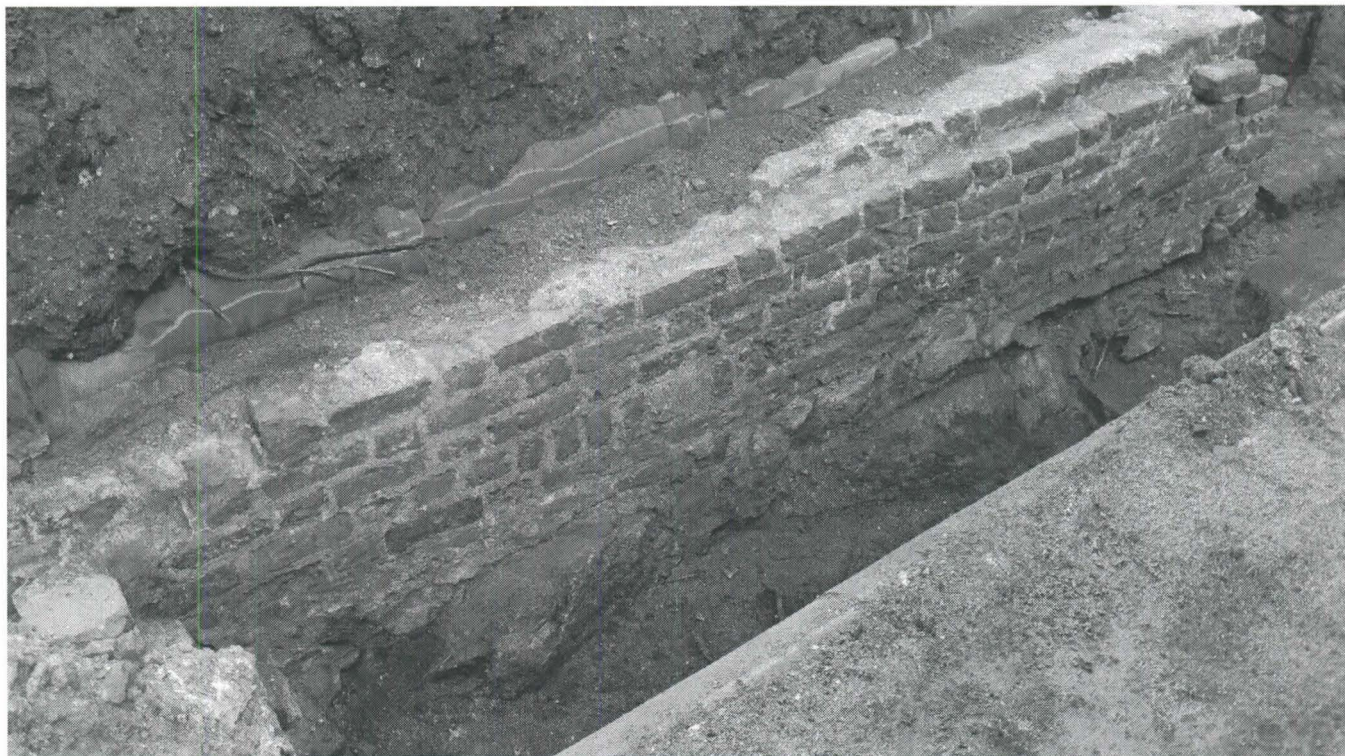
Kuva DT2009:17:1:100_095. Perustus R114E kuvattuna NNW-suunnasta. Kuvaaja Elina Saloranta.
