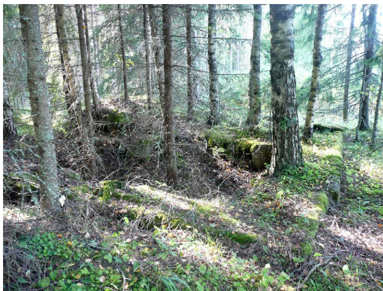
Kuva 9. Rakennuksen perustus tielinjauksen varrella.
