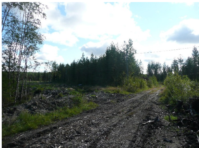
Kuva 4. Voimalapaikalle 6 johtavaa tielinjausta.
