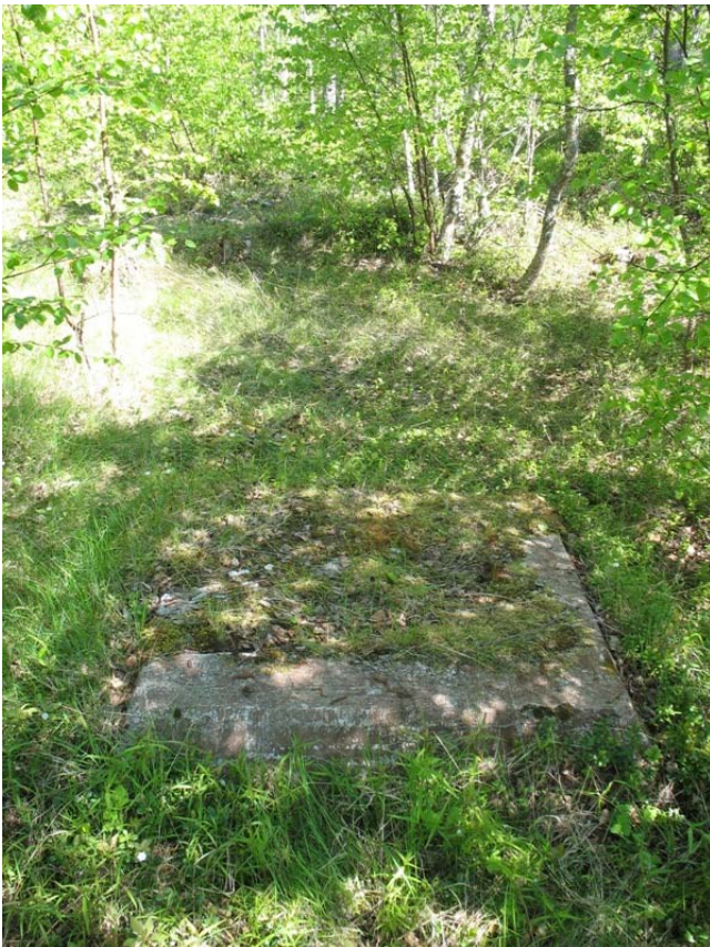
Kuva 47. Hiidenniemi 1, merimerkin betonilaatta.
