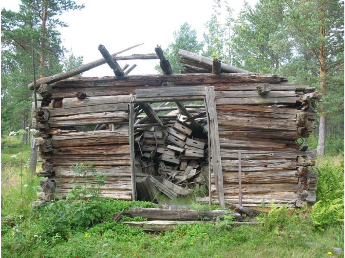
Kuva 63. Pajuperä 4, puoji pohjois-luoteeseen.
