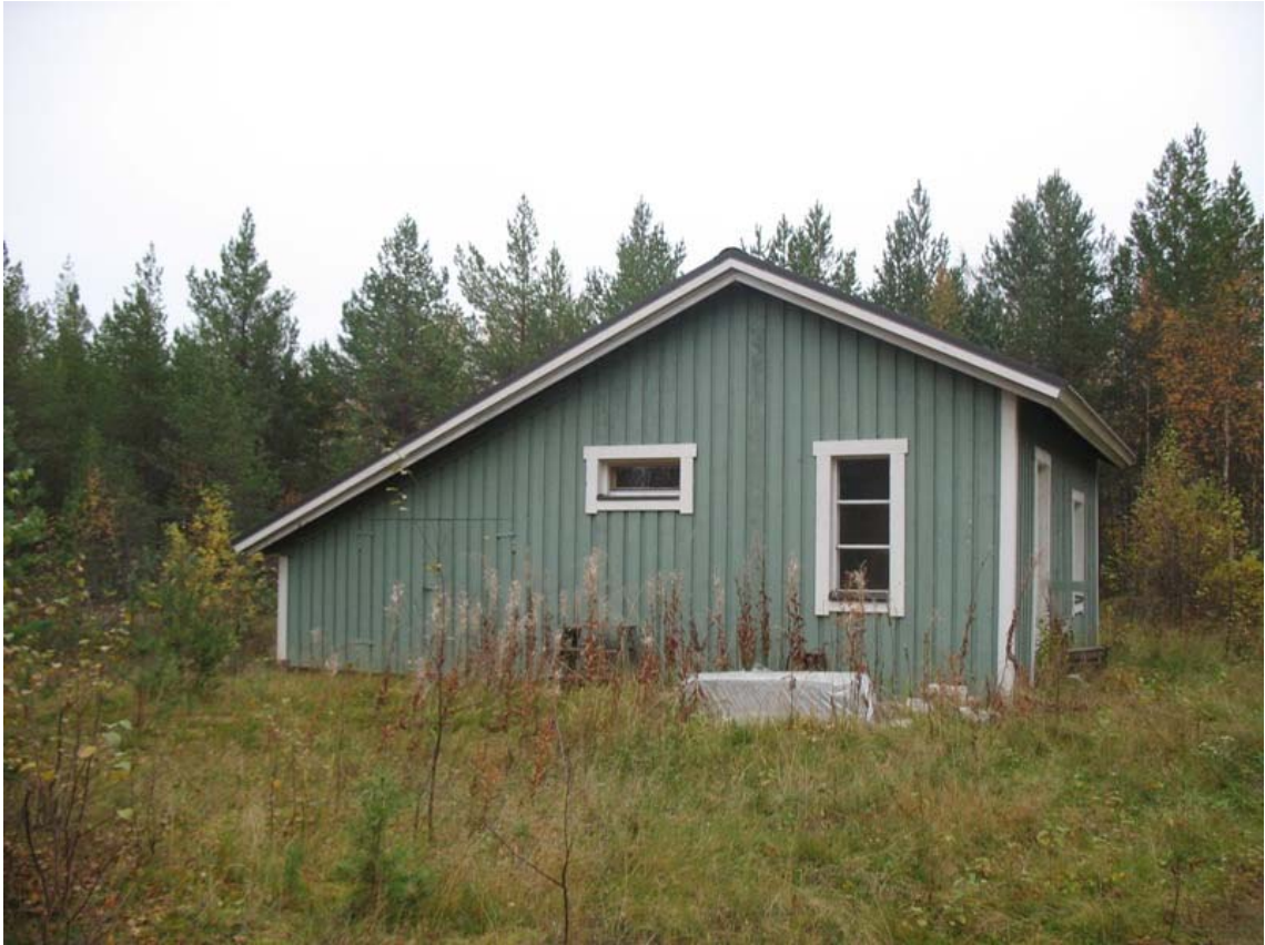
Kuva 75. Annusen kalamökki etelään. Kuvassa olevat ikkunat uusia.
