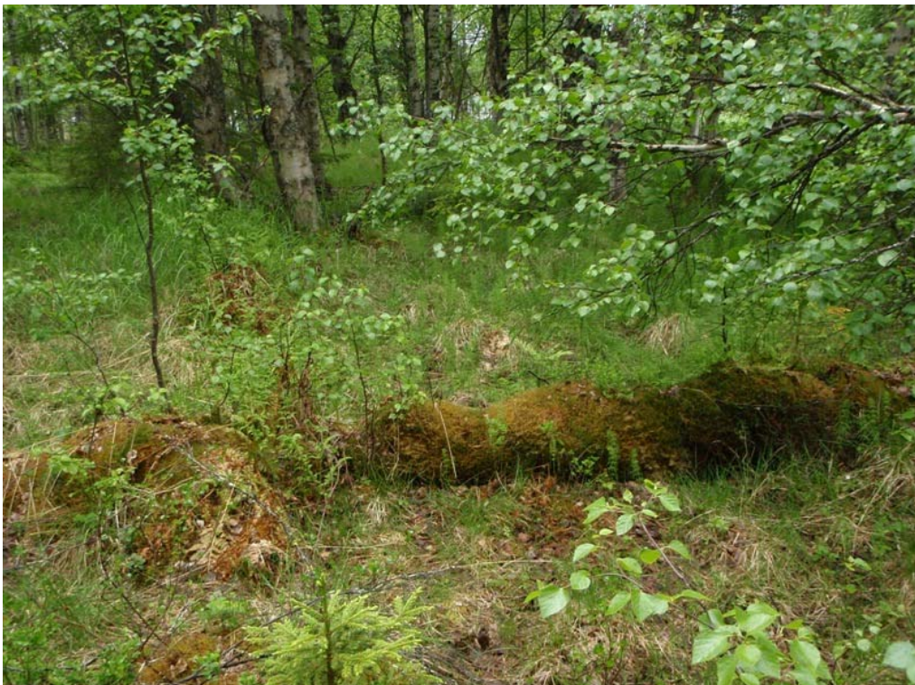
Kuva 9. Syvälampi 1. Asuinrakennuksen lahonnut alahirsi.
