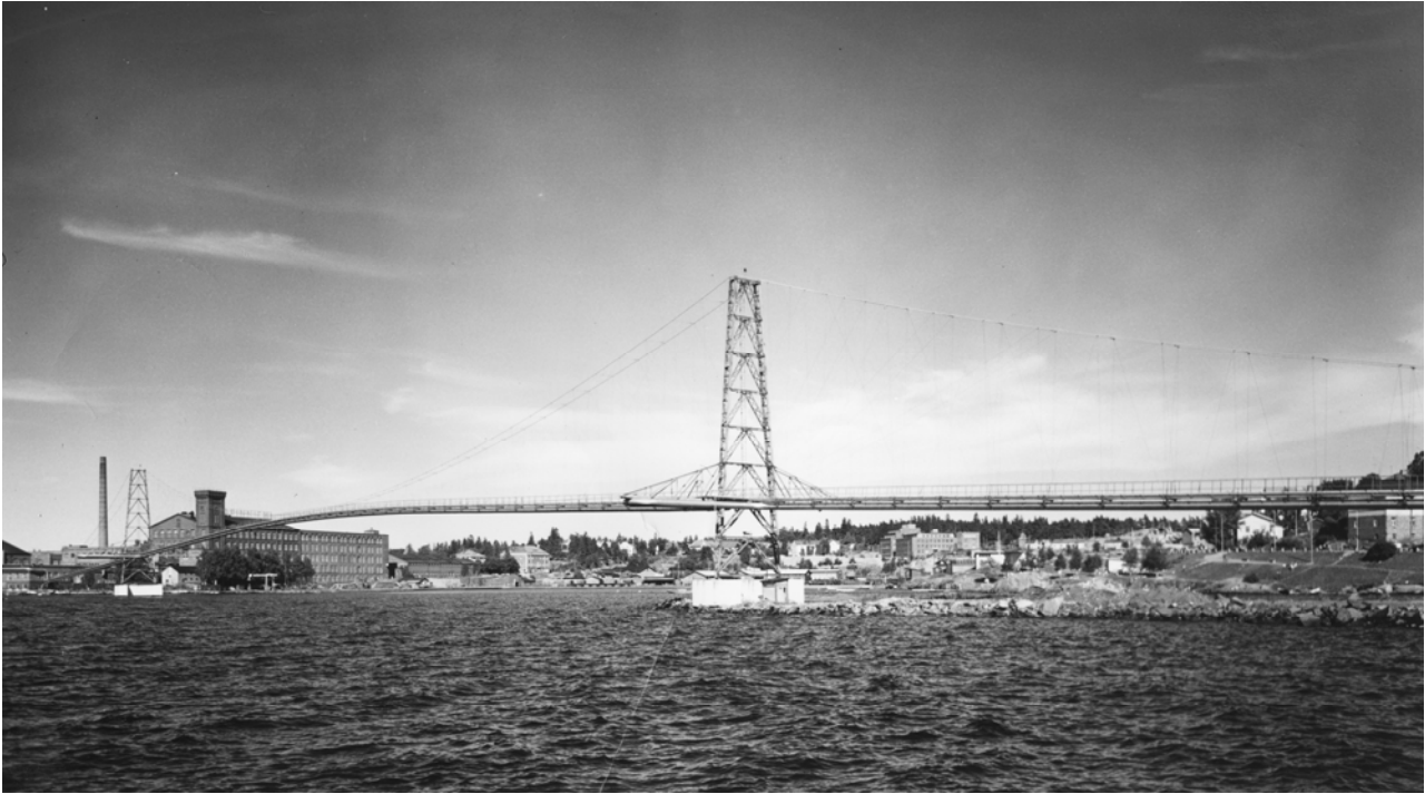
Kuva 12. Höyryputki Tampellasta Lapinniemen tehtaalle vuonna 1959. Kuva: Vapriikin kuva-arkisto.
