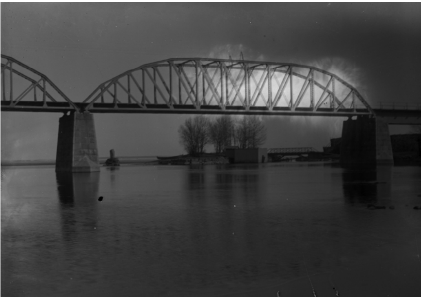
Kuva 11. Porin-radan rautatiesilta. Kuvausaika 1910-1920. Rautatiesillan vasemman pilarin juurella näkyy kauempana järvellä kivinen väylämerkki. Kuvaaja Kalle Lindgren.
