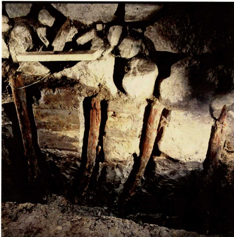
Kuva 55. Rakenteen R68 pystypaalut. (Kuva: Seilo Ristimäki, dia 6x6: 273.)
