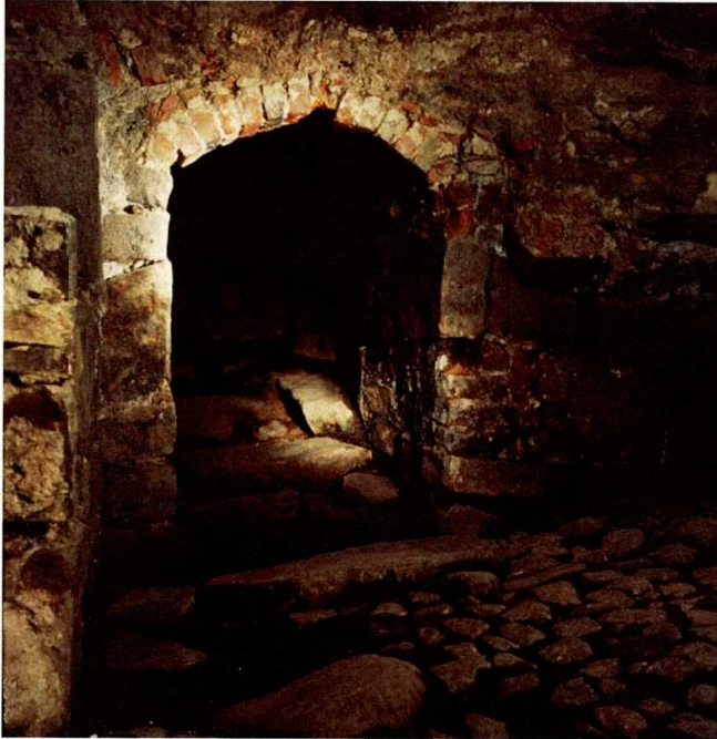
Kuva 23. Kellarin K94:10 koillisseinän oviaukko porrashuoneeseen K94:8. (Kuva: Seilo Ristimäki, dia 6x6: 460.)
