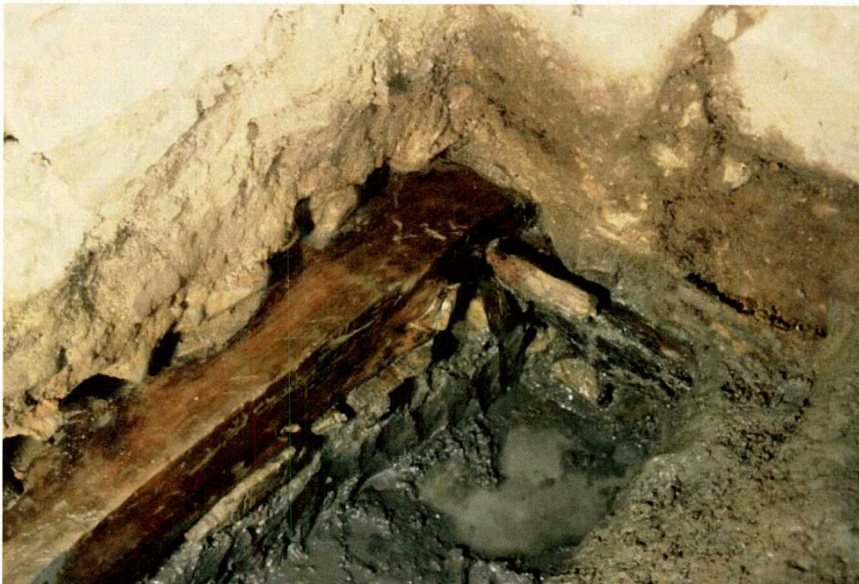
Kuva 13. Kellarin K92:3 itänurkan koekuopassa KU2 (itä) sijaitsevat puurakenteet. Koillisseinän alla arinahirsi R15 (itä) ja sen alla olevat poikittaiset laudat ja puut R16 (itä), R17 (itä), R18 (itä), R19 (itä), R20 (itä) ja R21
