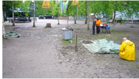
41. Koekuoppa 3 ennen kaivamisen aloittamista. W-E. OK.
