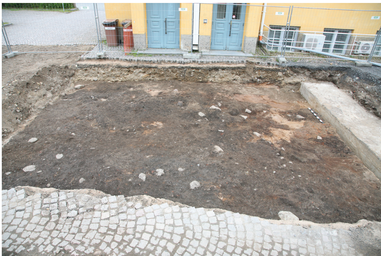
_8 Alue 3. Kaivinkonekuorinnan jälkeen pinta puhdistettuna. Esillä sekoittunut M102, itäkulmassa suoraan esiin tulleita kulttuurikerroksia (ryhmien 2 ja 3 päällä). Oikealla betoninen kaapelikanava (SW-NE, 28.7.2015, M. Helamaa).
