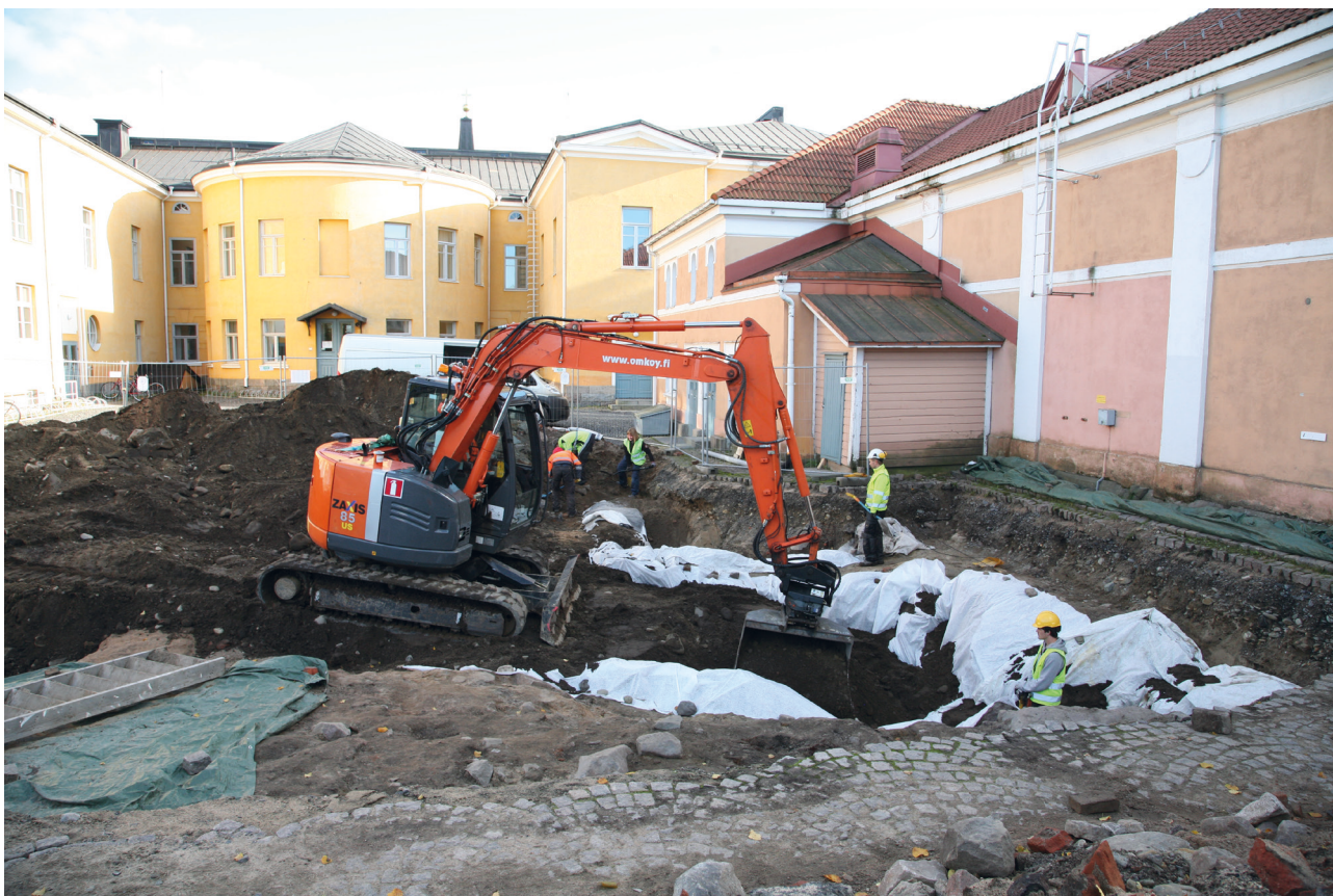
_51 Alue 5. Kellari B:tä täytetään ja taustalla kellari A:ta suojataan bentoniittimatolla. (26.9.2015, M. Helamaa).
