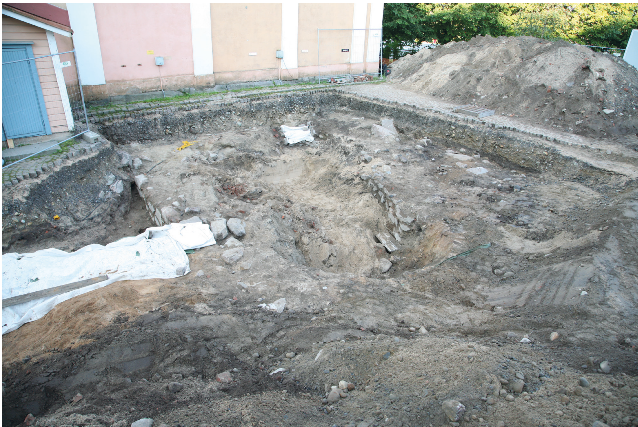
_29 Alue 5. Uuninperustuksen kivet ja osin sen alaista hiekkaa (371) kaivinkoneella poistettuna (E-W, 10.9.2015, M. Helamaa).
