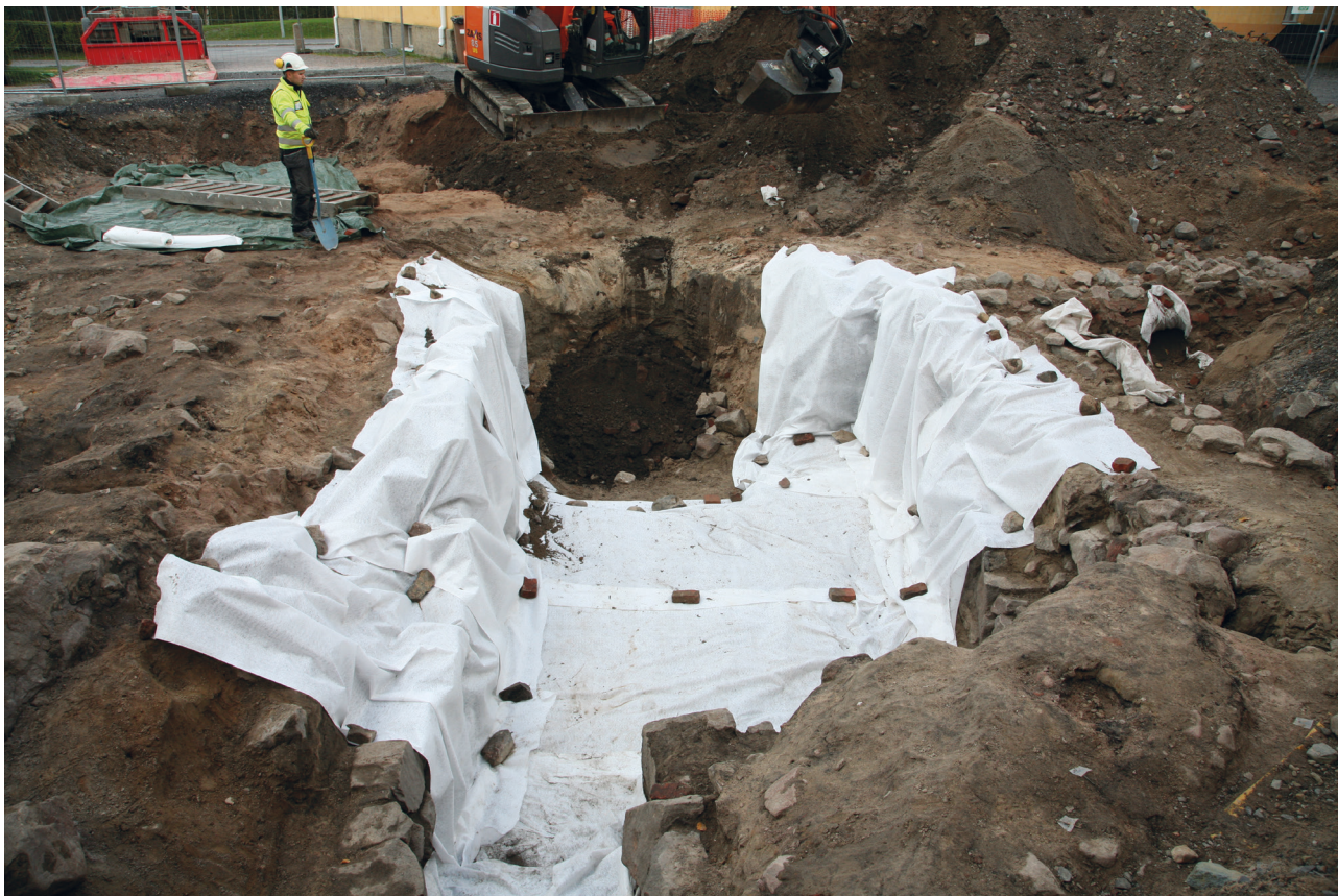
_50 Alue 5. Kellari B odottaa täyttöä suodatinkankaalla suojattuna (SW-NE, 26.9.2015, M. Helamaa).
