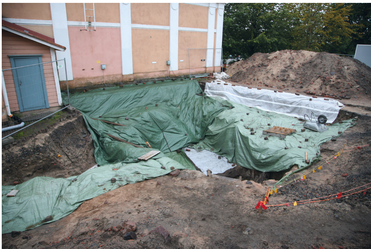
_35 Alue 5. Kellareiden ja kaivausalueen suojaus rankkasateilla (E-W, 22.9.2015, M. Helamaa).
