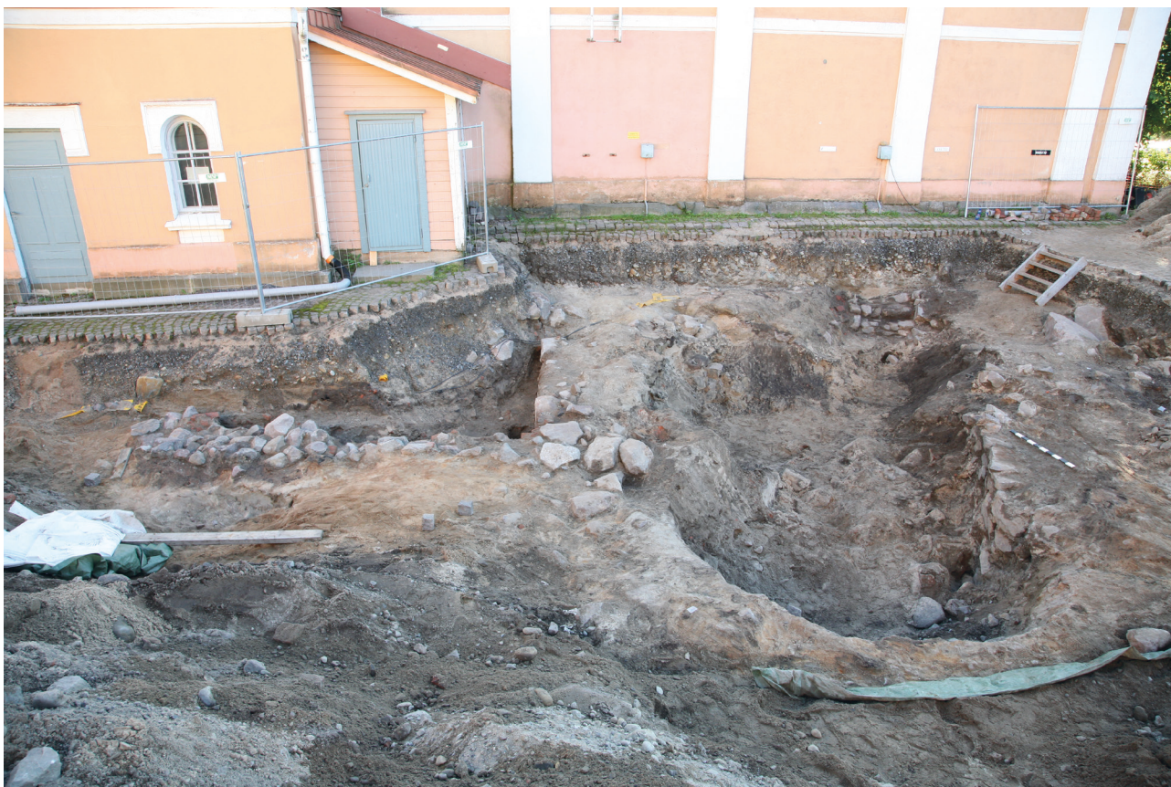
_30 Alue 5. Täyttöhiekkä M371 pois kaivettuna, kellarin B täyttömaat (ryhmä 13) näkyvissä (NE-SW, 10.9.2015, M. Helamaa).
