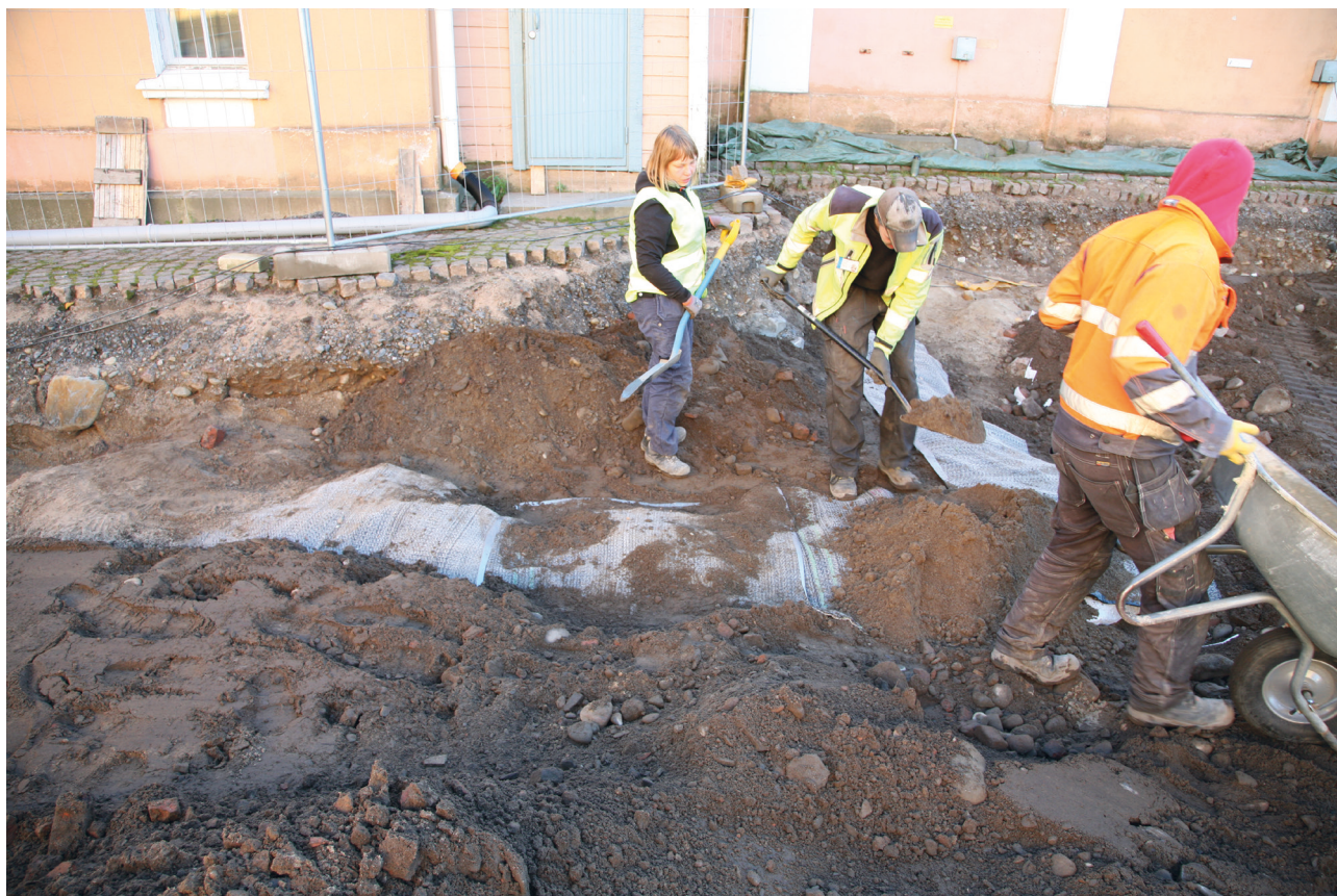
_52 Alue 4, kellari A:n seinälinjojen päälle asetettua bentoniittimattoa tasataan maalla, kuvassa Johanna Lehtola, Niko Salminen ja Jere Jokila. (26.9.2015, M. Helamaa).
