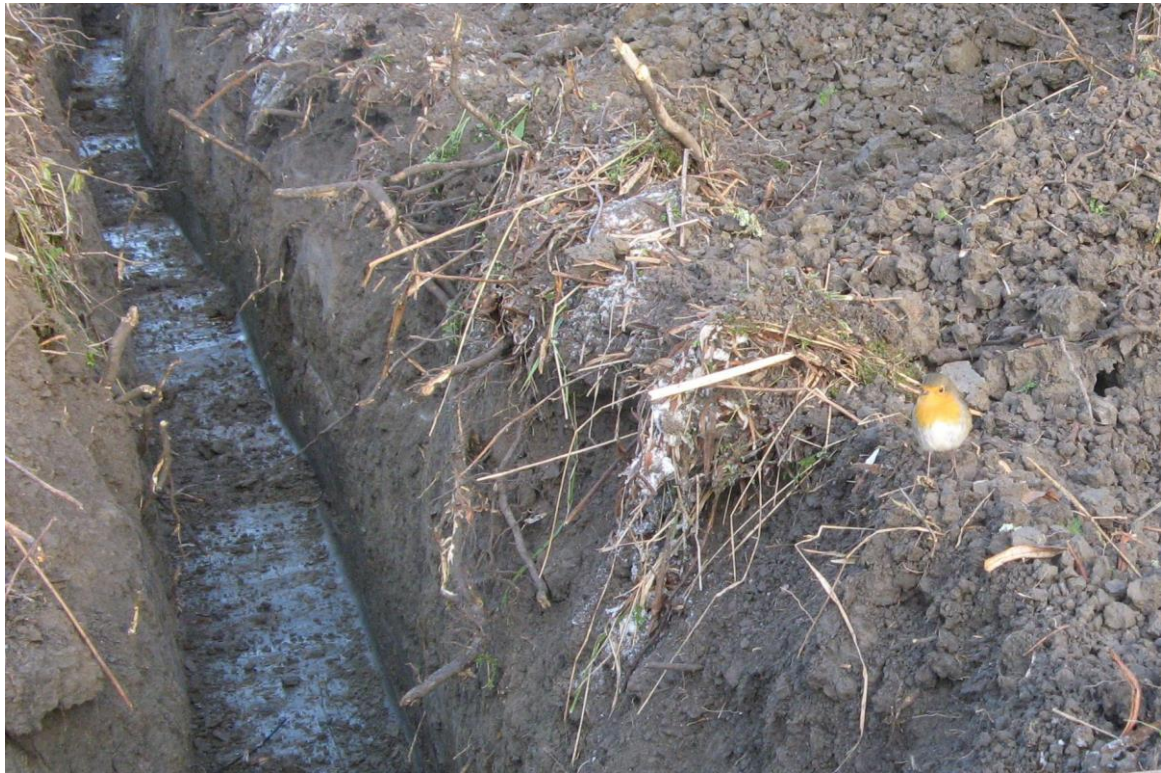
SKDG201612:14. Ojan lounaispäättä, oikealla kaivamista tiiviisti valvonut punarinta.
