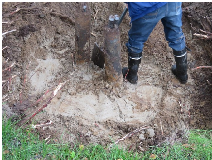
Kuva 2. Porakaivon putken kohta puhdistettiin lapiolla.
