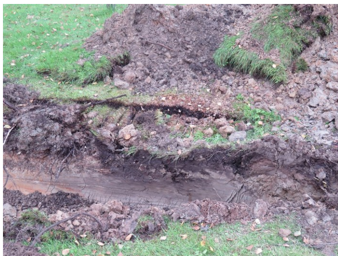
Kuva 3. Profiili kohdalla 4 – 7 m, kuvattu etelään.
