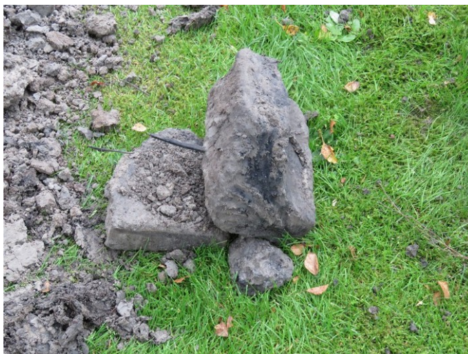
Kuva 11. Ukkosjohtimien ankkurit betonipaloissa.
