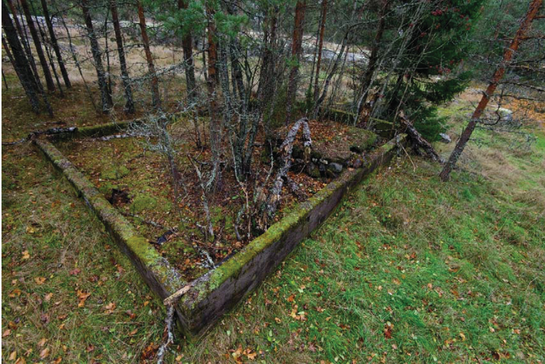
Störsvk Solbacka. Valettu rakennuksen sokkeli, laidassa uunikiveys. Kuva lounaasta. (AKDG4213:2)
