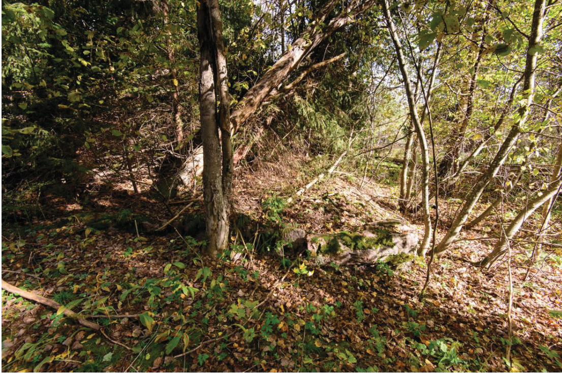
Solbacka. Rakennuksen kivijalka. Kuva lännestä. (AKDG3981:3)
