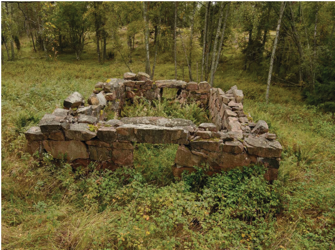
Mattholm. Rakennuksen massiiviset kiviseinät. Kuva pohjoisesta. (AKDG4220:1)
