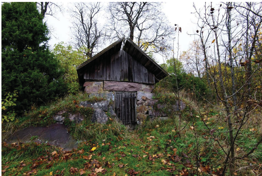
Bollstad 3. Mahdollinen keskiaikainen kylänpaikka. Kellari mäen rinteessä. Kuva idästä. (AKDG4121:1)
