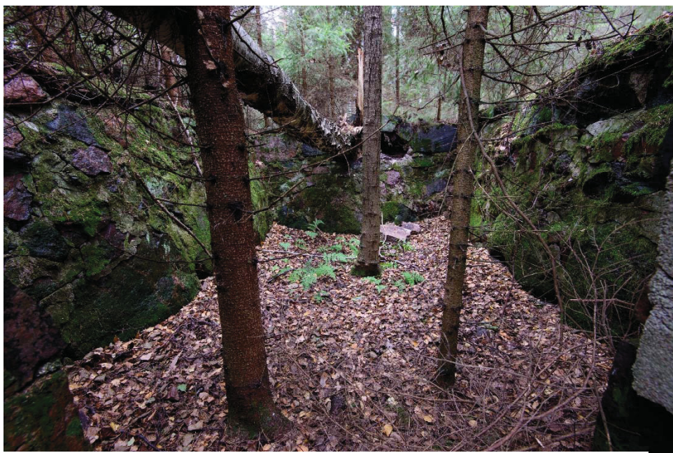
Massiiviset kellarin kiviseinät Snickarsissa. Rakennetta on erehdytty luulemaan bunkkeriksi tai suojahuoneeksi aiemmin. (AKDG4208:2)
