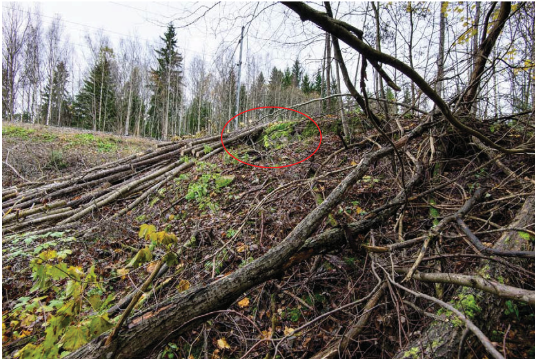
Kapellbacken 3. Betonibunkkeri aivan junaradan eteläpuolella on lähes näkymätön. Hieman bunkkerin betonikulkmaa on vin näkysissä. Kuva lounaasta. (AKDG4200:2)
