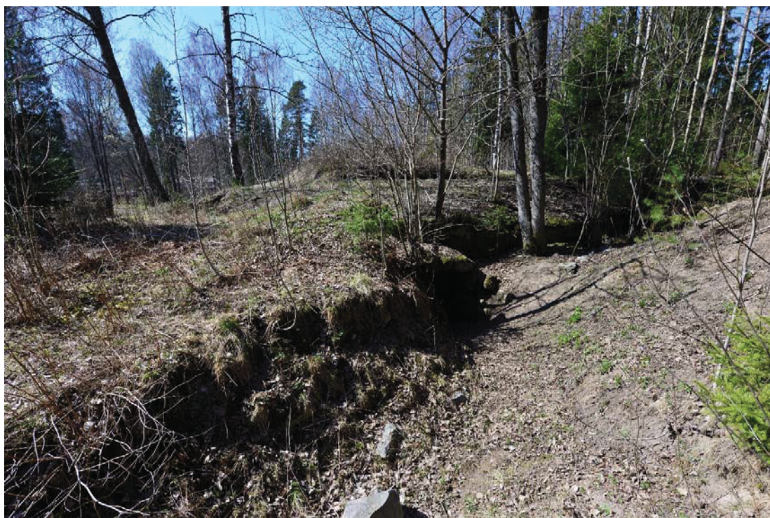
Bunkerbacken 2. Betonibunkkeri Sjundbyntien varressa. Kuva idästä. (AKDG4184:1)
