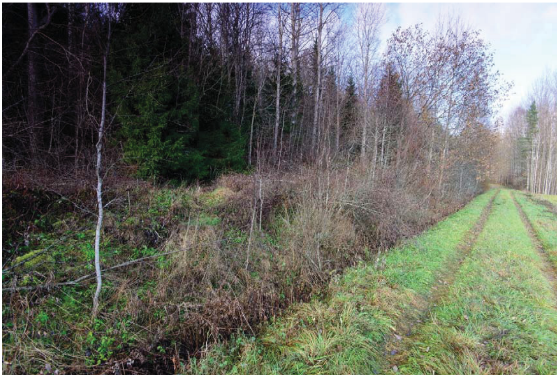
Kumlet. Bunkkeri on erittäin tiheässä vesakossa pellon laidalla. Kuva kaakosta. (AKDG4191:1)
