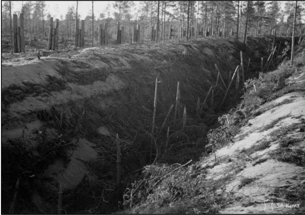
Kuva 18. Kaivantoeste. Suoraviivaisesti kaivetun esteen pohjalla on teroitettuja puupaaluja. Esteen takana on rivissä kiskoesteiden paaluja. SA-kuva 114599. Alarik Öhrnberg, 1942.
