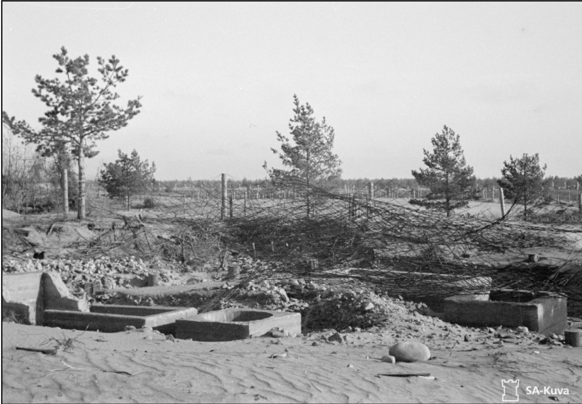
Kuva 11. Keskeneräiseksi jäänyt betonibunkkerin rakennustyömaa Lappohjassa lokakuussa 1942. Kuopan pohjalle on ehditty valaa betonisia kaivorakenteita ym. Kuopan reunalla on betonivalujen vahvistamiseen tarkoitettua pyöröteräsverkkoa. SA-kuva 114156a. Alarik Öhrnberg, 1942.
