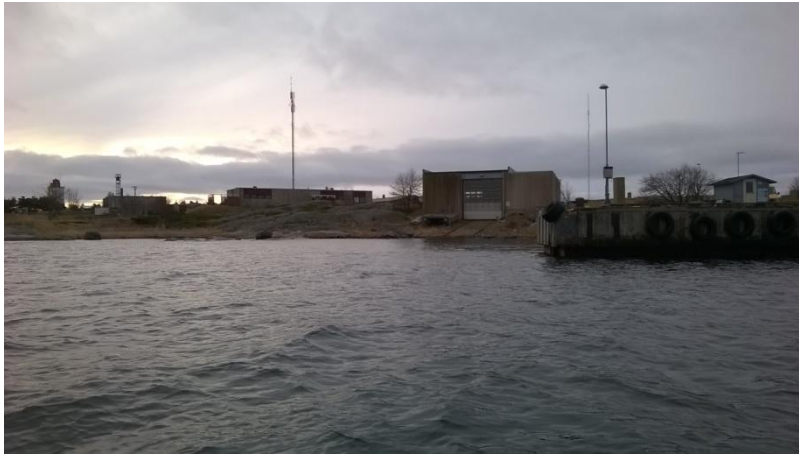
Kuva 1. Inventointialueen itäosaa. Kuvan keskellä telakkarakennuksesta veteen johtavat kiskot. Kuvaaja: Johanna Mäkinen
