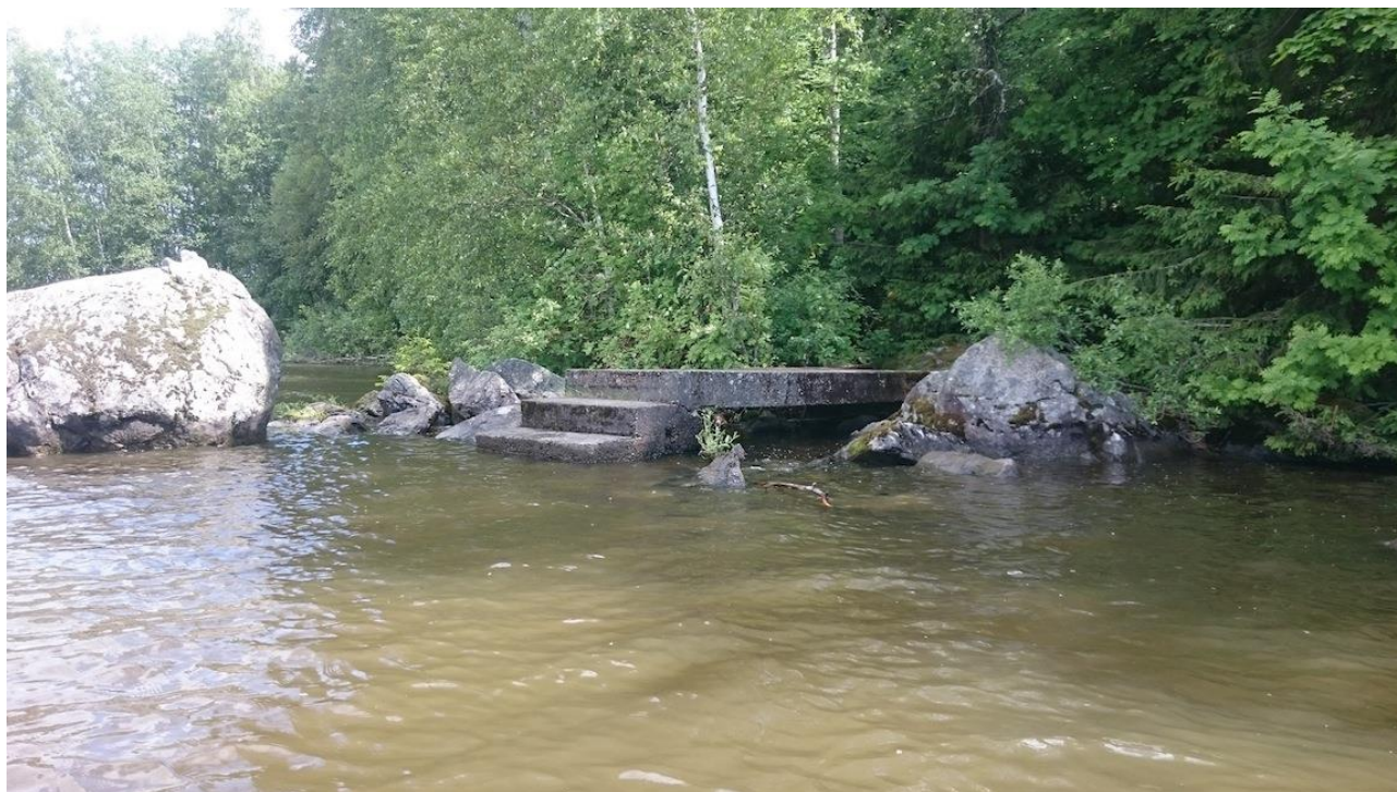
Kuva 6. Betonilaituri jonka edustalla on todennäköisesti sijainnut puulaituri kiviperustan päällä.
