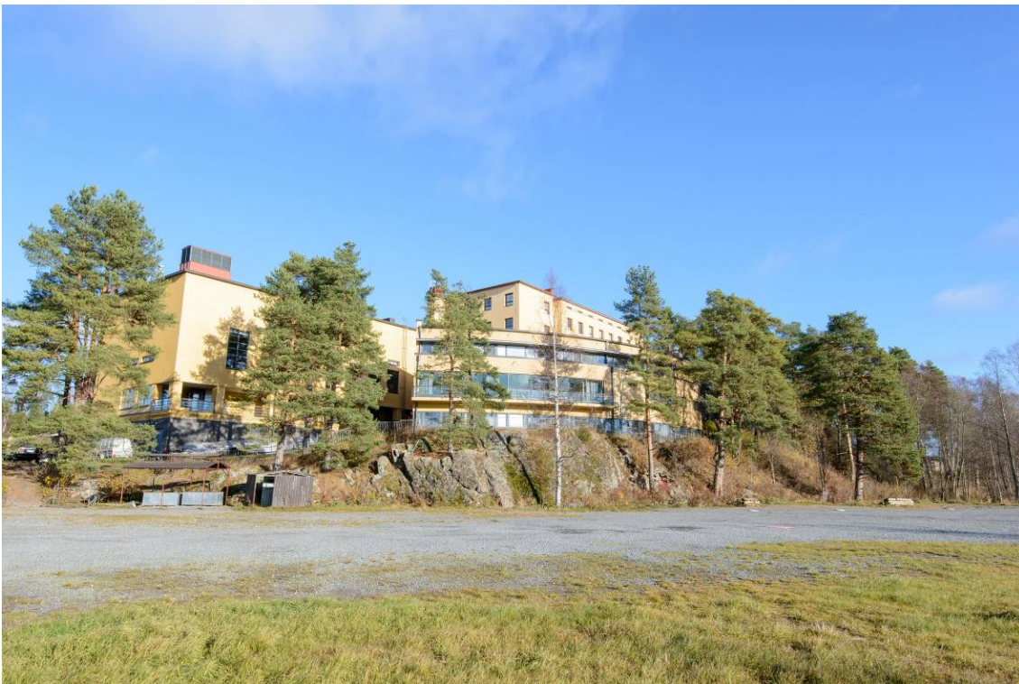
Pälämäen päälle rakennettu Kansanopisto, nykyisin Jämsän Kristillinen Kansanopisto. Kuva lounaasta. (AKDG4620:2)
