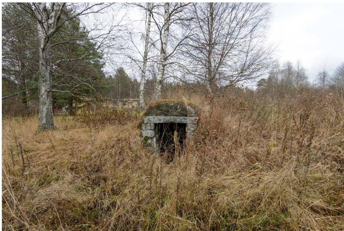
Patala. Kellarin oviaukko. Kuva lännestä. (AKDG4657:1)
