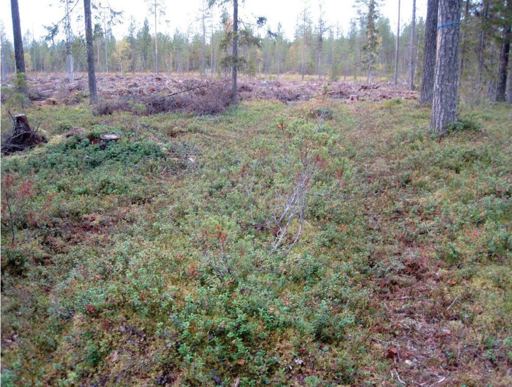
Kuva 11. Metsätyökoneen ajoreitti (nro. 1) Vuokin reitin ja sen suoja-alueen yli. Maaperä paikoin painunut. Kuvattu kaakosta.
