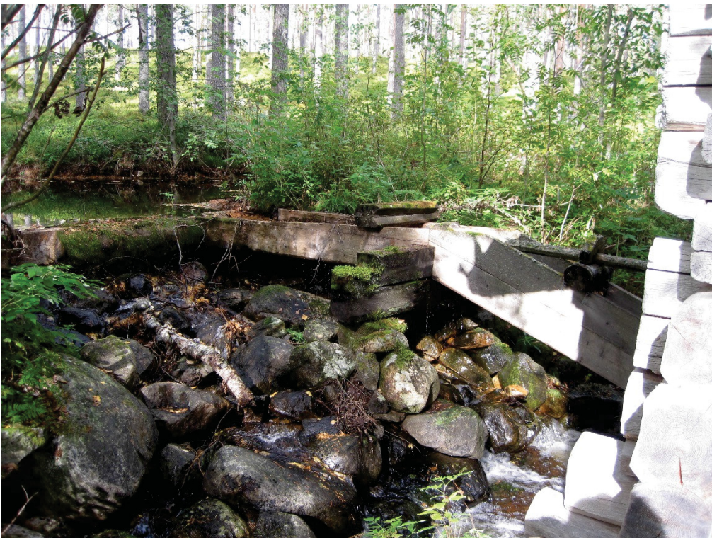
Kuva 2. Rautaisen myllyn kivipato ja puurakenteita. Kuvattu etelästä.
