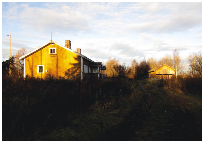
Entisiä asemarakennuksia. Kuva koilliseen.
