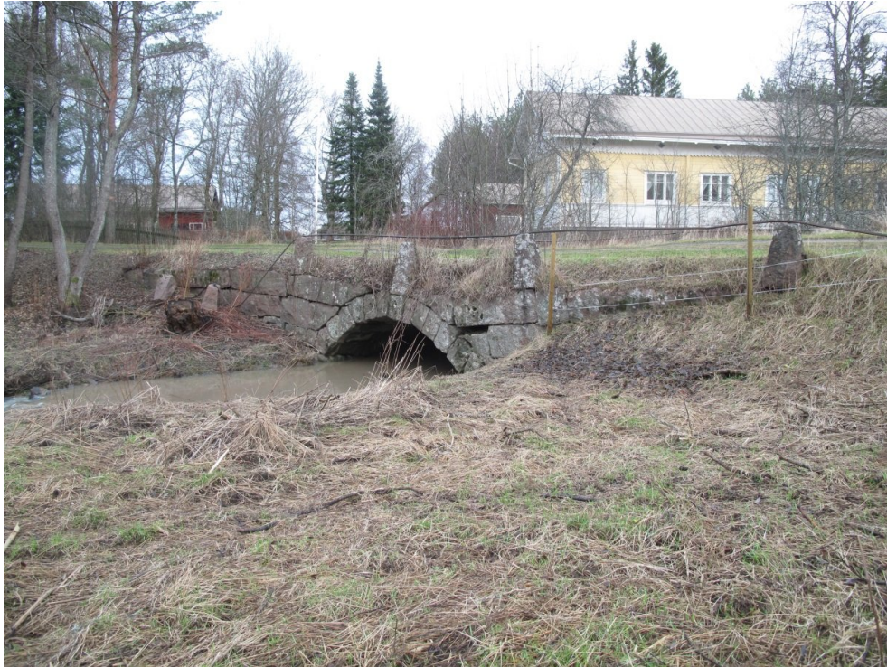
Kuva 32. Vähäjoen ylittävä kivinen kaarisilta Pyhän Henrikin tien/Nunnapolun varrella. Taustalla vanha Ruskon Pappila. Silta on rakennettu 1896 (ks. myös kuva 1). Koilliseen.
