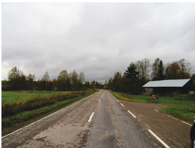
Kuva 18 VL. Linjaus 1 / 2 Ylikylän kohdalla, tie 7980.
