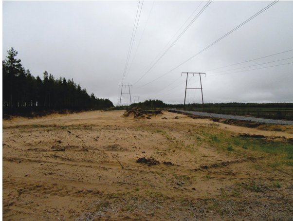
Kuva 32. Voimalinja Läntisenmutkan kohdalla kuvattu koilliseen.
