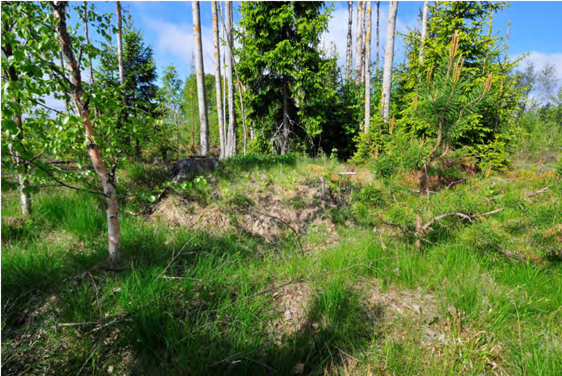
Rakennuksen kivijalka. Idästä. (DG2655:7, kuvaaja Mikael Nyholm)
