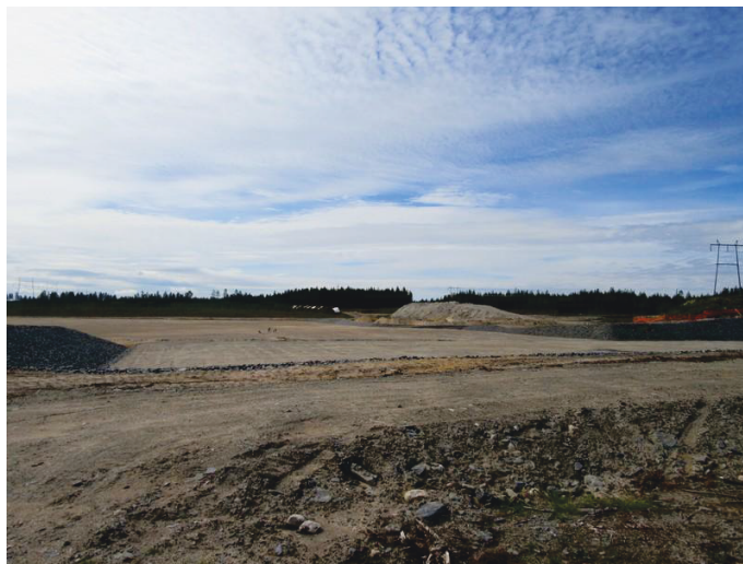
Kuva J. Isokankaan energiahuoltoalueen työmaa kuvattuna etelään.
