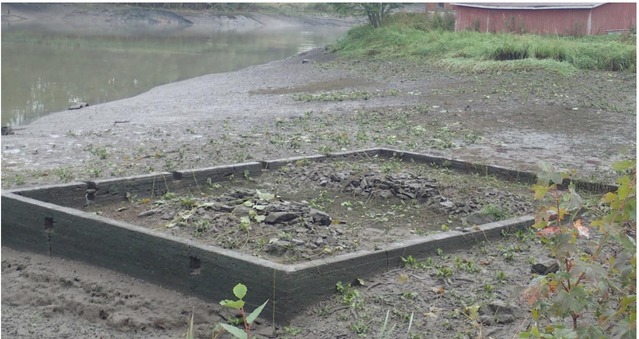
Kuva 22. Kuva talon perustuksesta syksyllä 2015 sattuneen joen vedenpinnan laskun aikana. Kuva: Koskienergia Oy/Timo Juvani.
