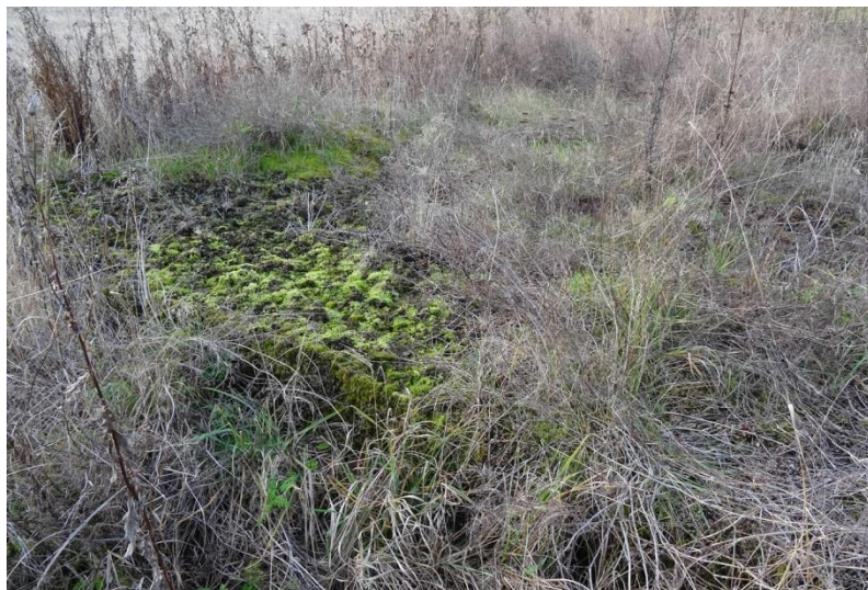
Kuva 33. Perustus 4. Betoniperustus niityllä. Rakennus näkyy vuoden 1966 peruskartassa.
