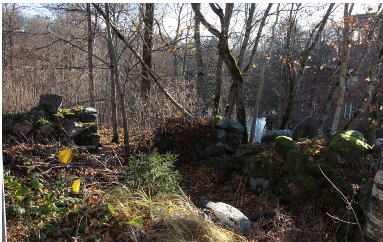
Kuva 37. Perustus 8. Rakennuksen perustus kallion päällä Mustionkosken itärannalla ruukkialuetta vastapäätä.
