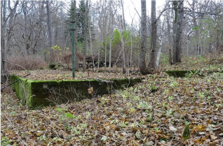
Kuva 35. Perustus 6. Rakennuksen betoniperustus mökin pihapiirissä ruukkia vastapäätä joen etelärannalla.
