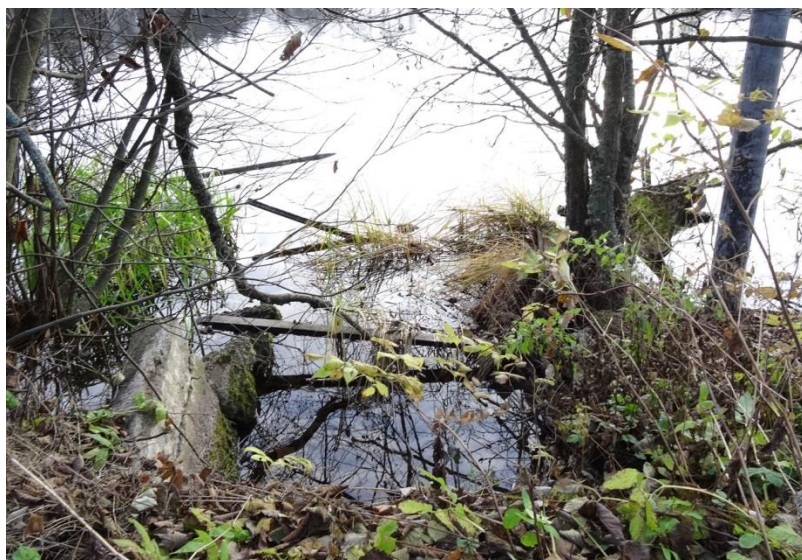
Kuva 30. Perustus 1. Mustion keskivoimalan perustukset jatkuvat veden alta rantapenkereeseen.
