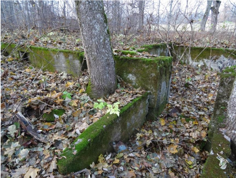
Kuva 31. Perustus 2. Mustion keskivoimalaitoksen kohdalla on rannalla suurehkon rakennuksen kivijalka.
