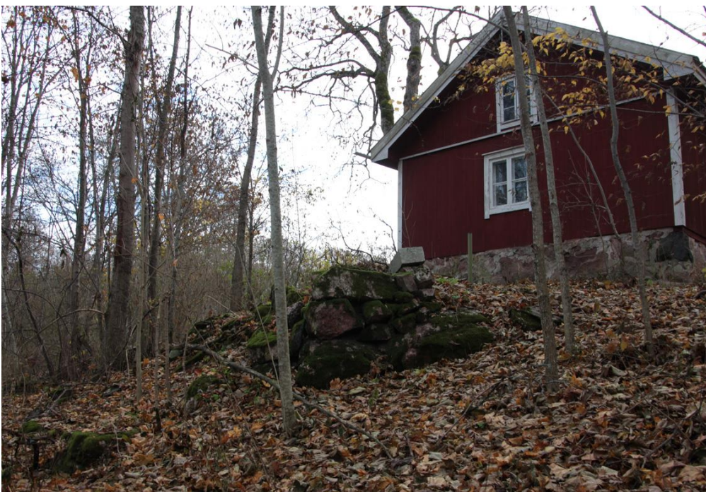
Kuva 36. Perustus 7. Rakennuksen perustus rinteessä nykyisin hotellihuoneiksi muutetun rakennuksen päädyssä.
