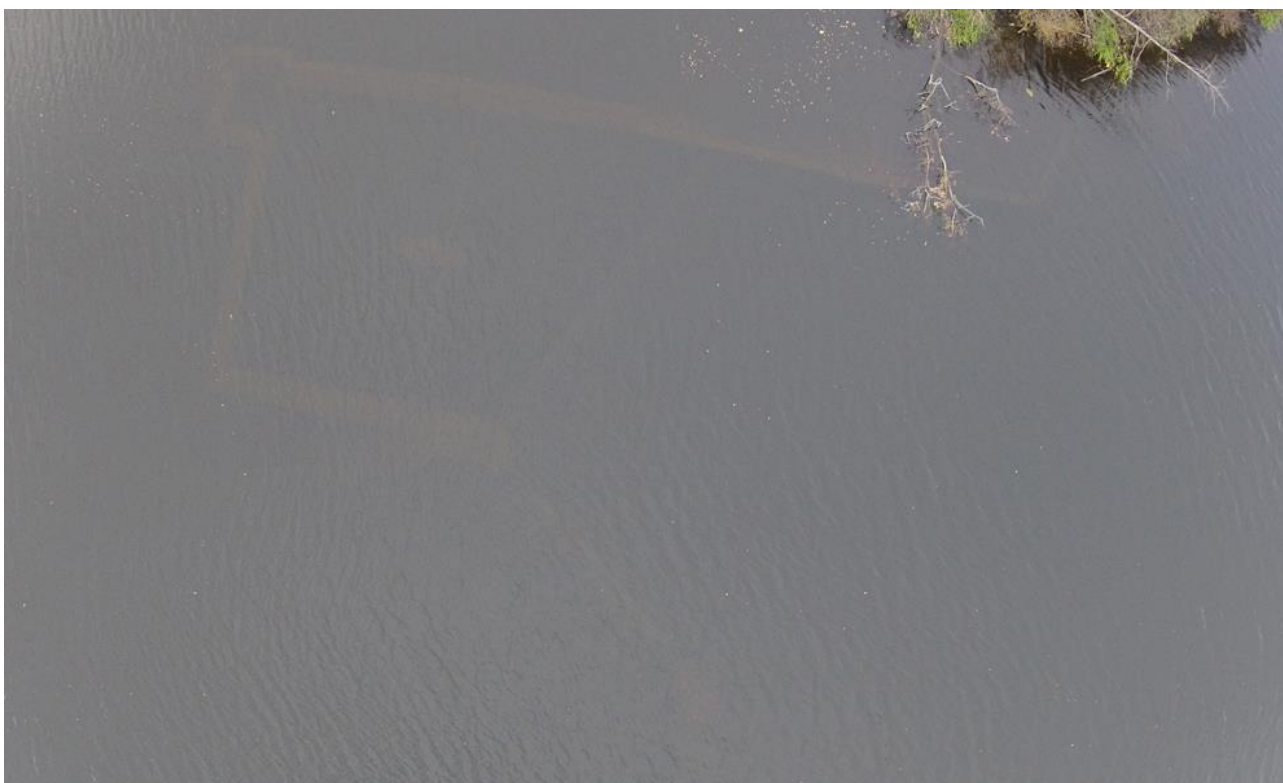
Kuva 17. Ilmakuva keskimmäisestä voimalaitoksesta. Vaaleat betonirakenteet erottuvat lähes kahden metrin syvyydestä tummasta vedestä. Kuva: Helsingin yliopisto/Wesa Perttola.
