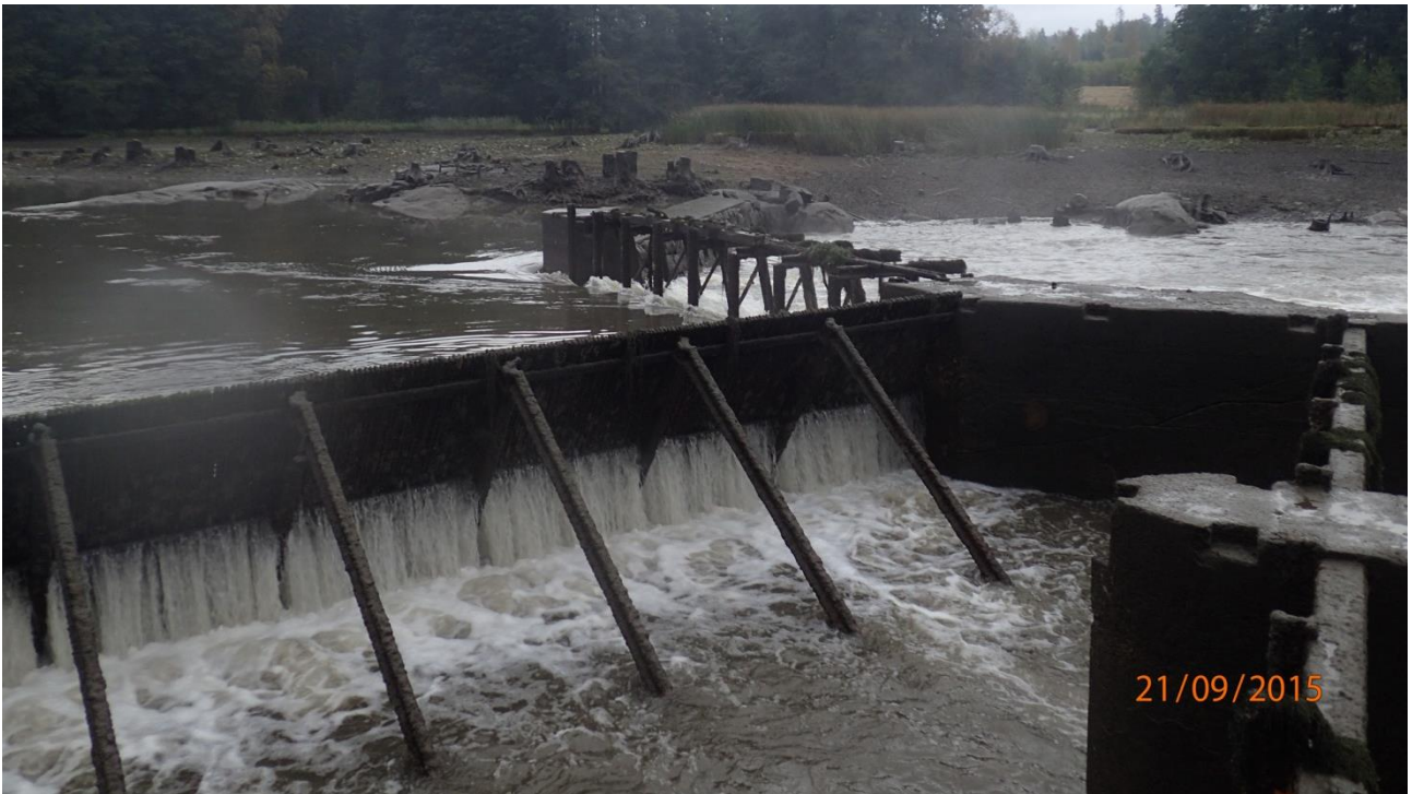
Kuva 18. Keskivoimalaitos syksyllä 2015 sattuneen joen pinnan laskun aikaan. Kuvaussuunta on itään. Vastarannalla näkyy vanhan uoman rannoilla kasvaneiden puiden kantoja. Kuva: Koskienergia Oy/Timo Juvani.
