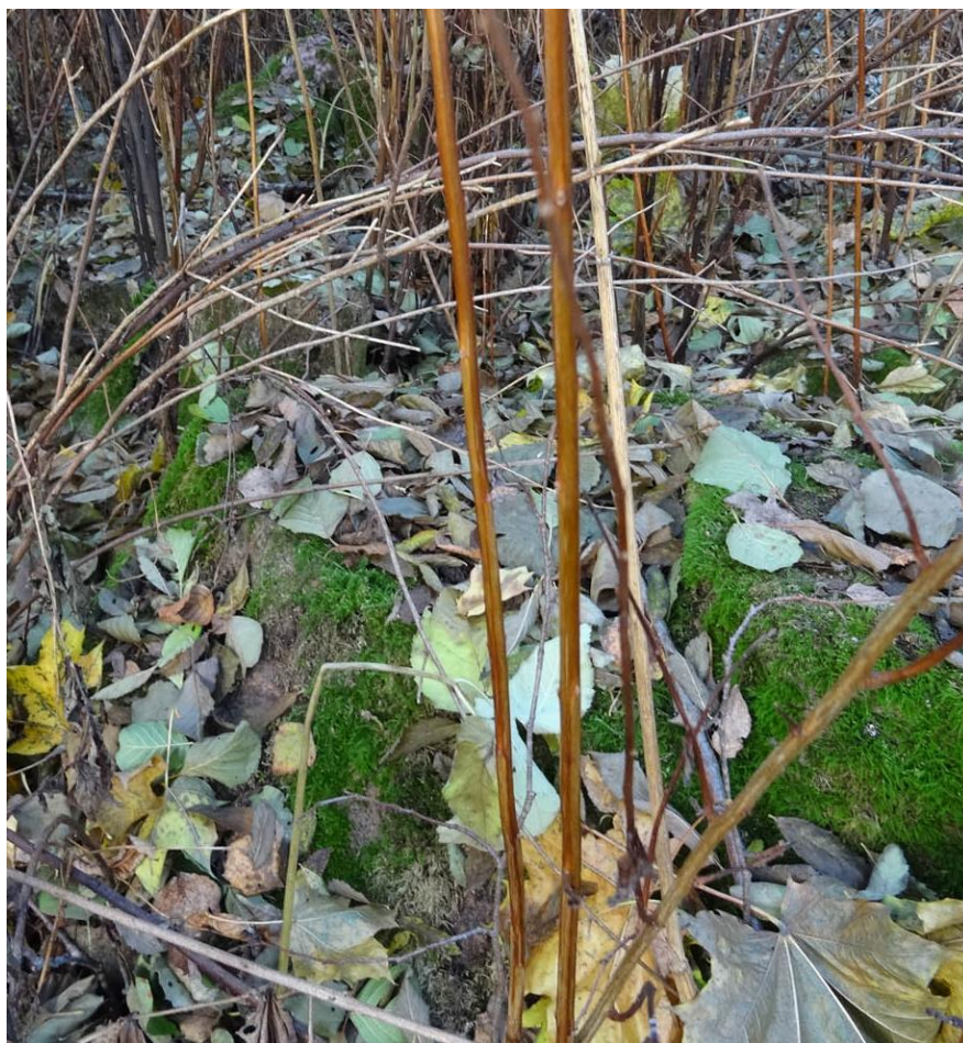
Kuva 32. Perustus 3. Maastosta huonosti erottuva luonnonkivistä rakennettu rakennuksen perustus.
