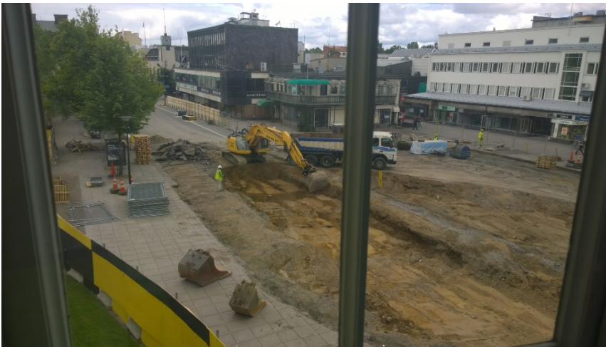
AKDG 4499:43. Yleiskuva työmaasta 14.7 aamupäivällä, otettu kirkon lehteriltä, länteen. Kuvaaja: P. Pesonen.
