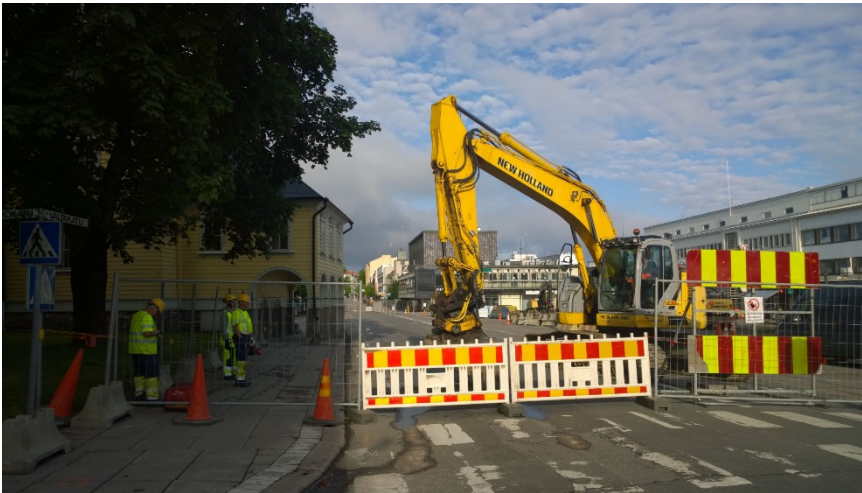
AKDG 4499:2. Kadun asfaltin kuorinta alkaa, länteen. Kuvaaja: P. Pesonen.
