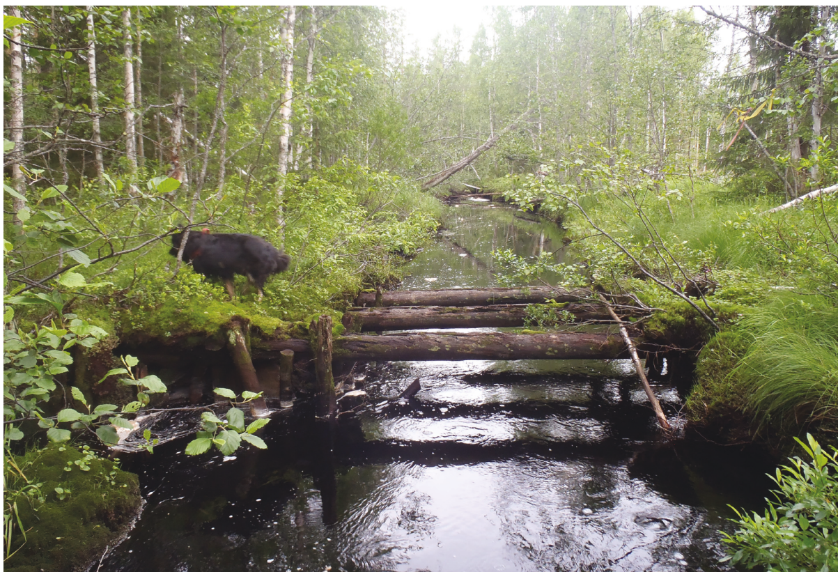
Alla: 179893.P1010011. Kolme tukevaa hirttä on vedetty joen yli. Joitakin poikittaislautoja on vielä jäljellä hirsien päällä joen länsireunalla.
