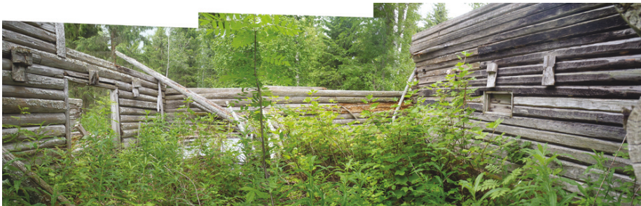
Alla: 180169.P1010028-30. Saprovaaran navetan isompi ja tiiviimmin rakennettu huone.
