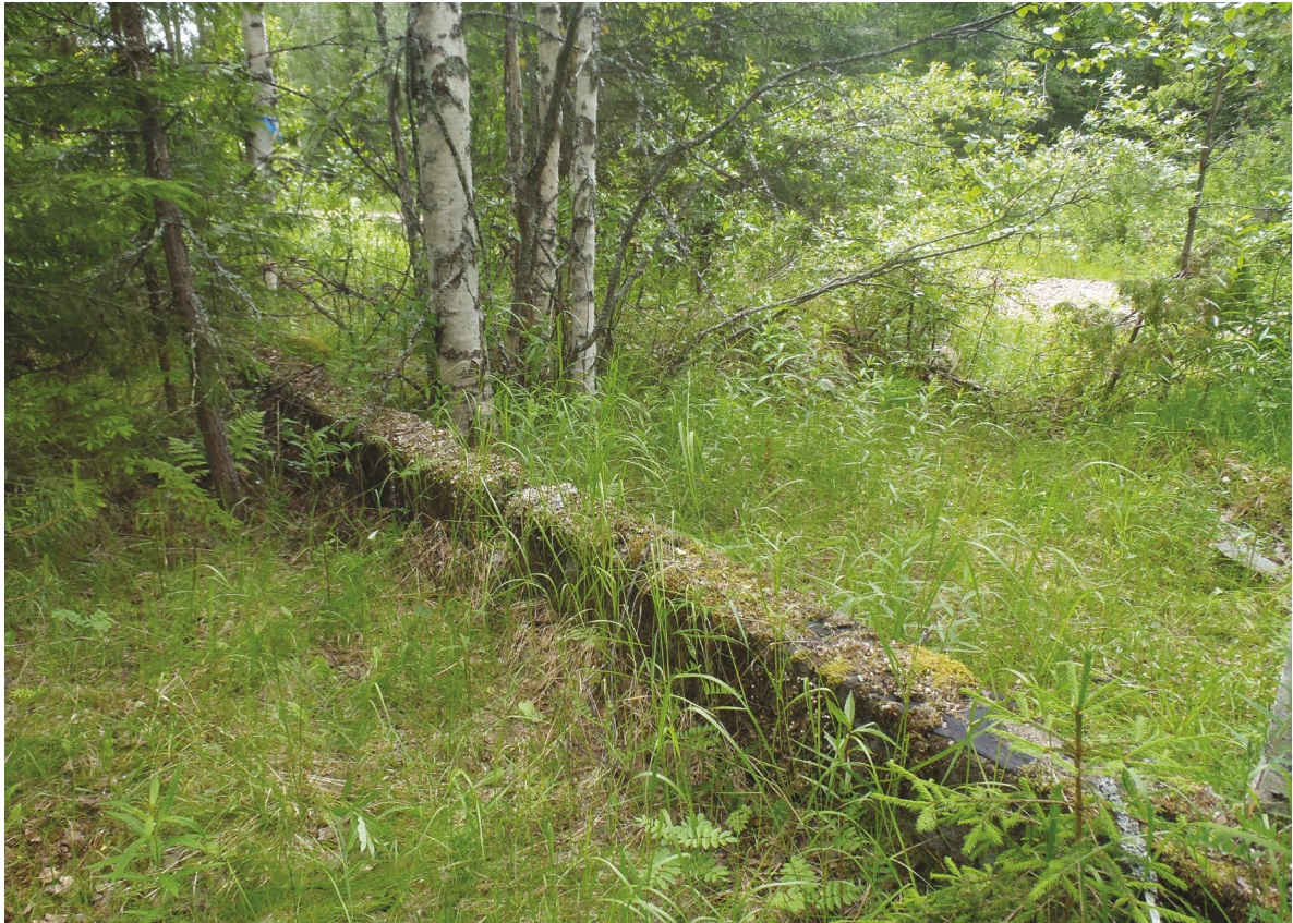
Yllä: 179823.P1010033. Vaikka kämppä on purettu, erottuu pohja selvästi, sillä rakennus on seissyt betonista valetulla kivijalalla.
