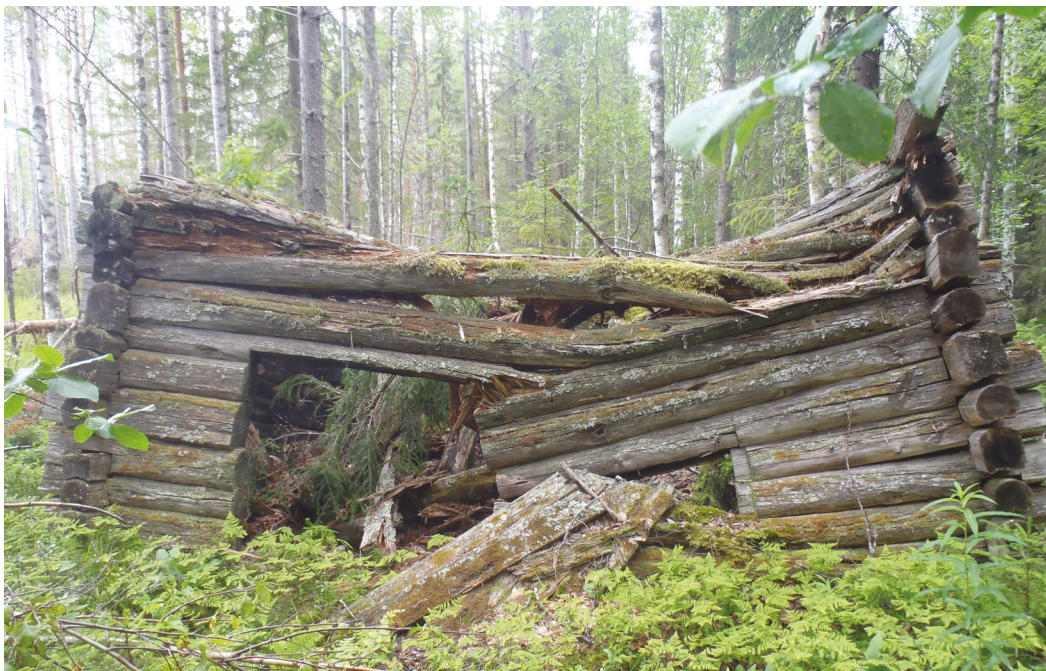
Alla: 180166.P1010013. Rakennuksen eteläpääty.
