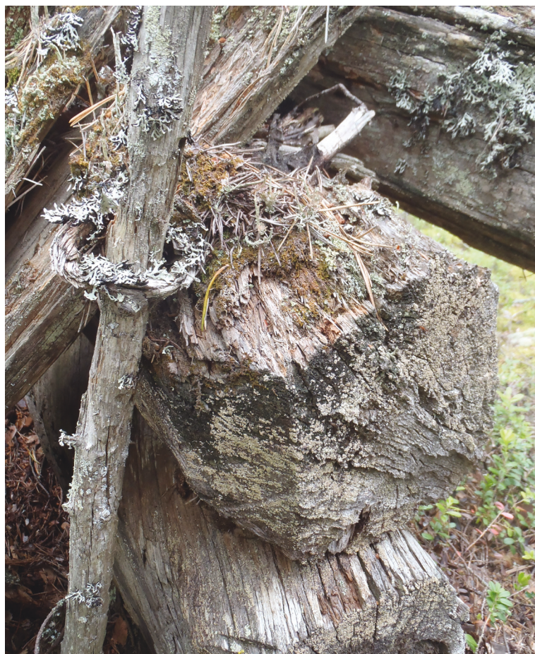
Yllä: 180098.P1010003. Syvänlammin sauna on tehty jyvistä hirsistä, hirret on sahattu säännölliseen mittaan. Kuvassa mukana inventointiapulainen Sonja.
