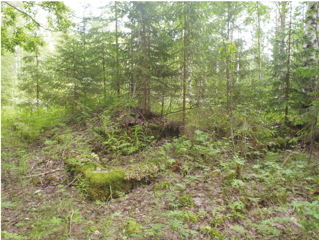
179823.P1010068. Loukkukorven betonivaluinen saunanpohja.
