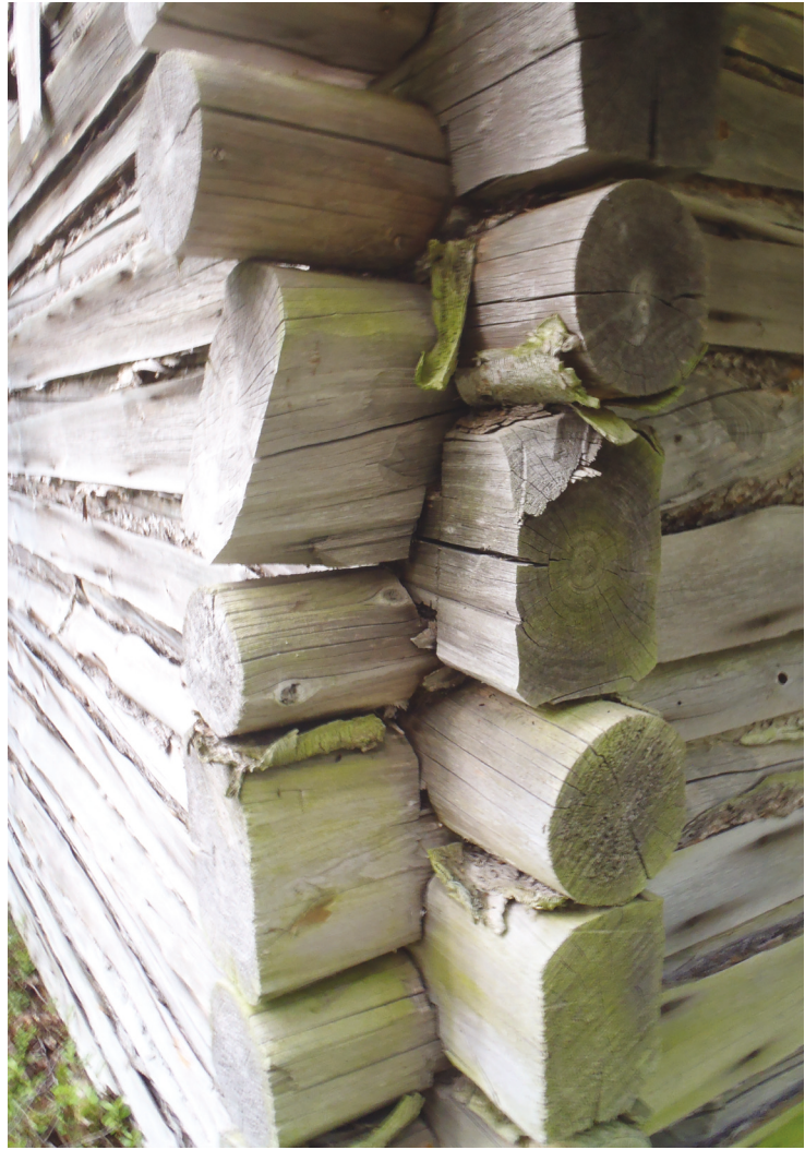
Oik.: 180159.P1010034. Kämpän hirsirakenteessa on käytetty tuohta eristeenä.
