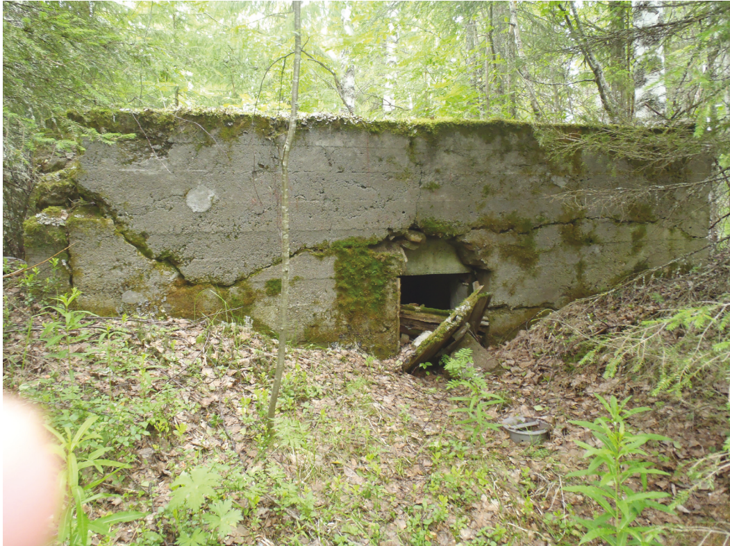
179823.P1010060. Loukkukorven kellari on ollut jyhkeämmän sorttinen rakennus.
