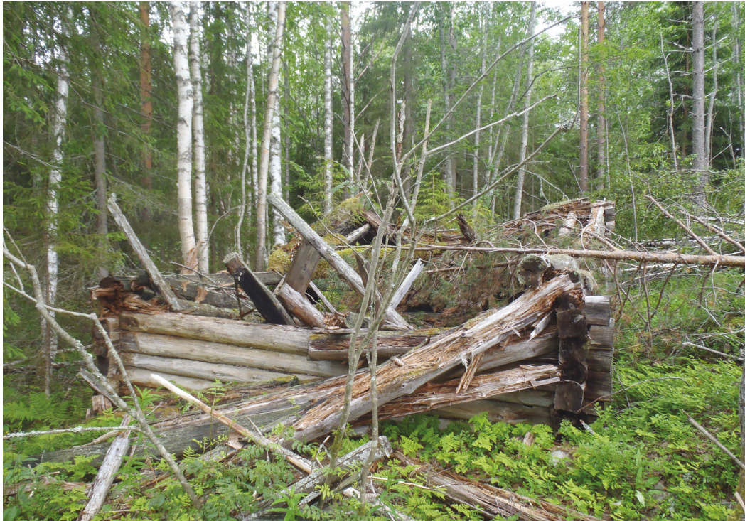
Yllä: 180166.P1010009. Klemetinpuron rakennus on paikalleen lahoava, huolellisesti hirsistä tehty savupirtti.
