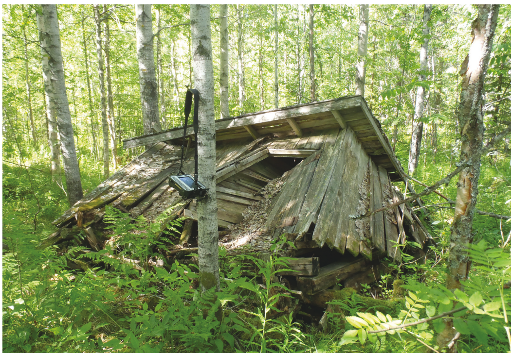
Yllä: 179829.P1010002. Vessa on jätetty purkamatta, mutta se on romahtanut. Se on hirsien päälle tehty pystylaudoitettu rakennus, jossa on punainen huopakatto. Pömpeleitä vessassa on ollut kaksi.
