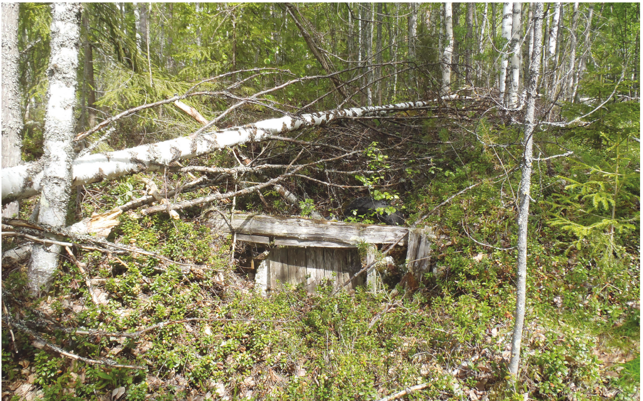
Alla: 179710.P1010030. Rakennuksen erikoisuuksiin kuuluu talon alle rakennettu kellari.
