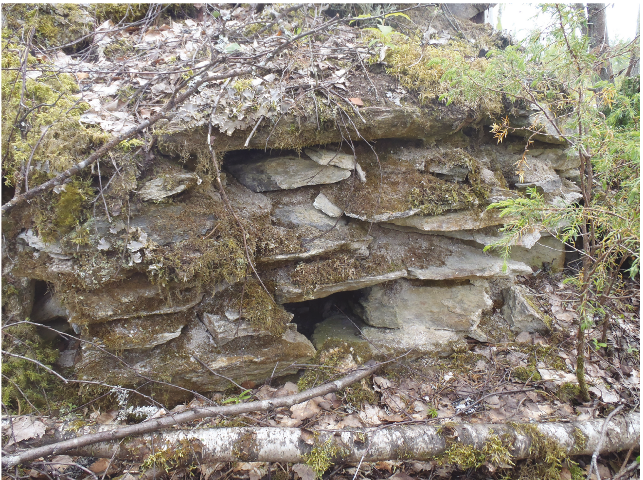
180094.P1010031. Kämppeärakennuksen isompi ja hyvin säilynyt uuni on lähes rakennuksen keskellä. Se on tehty pääasiassa luonnonkivistä, mutta jonkun verran punatiiltä on myös käytetty. Pesä erottuu edelleen selvästi.
