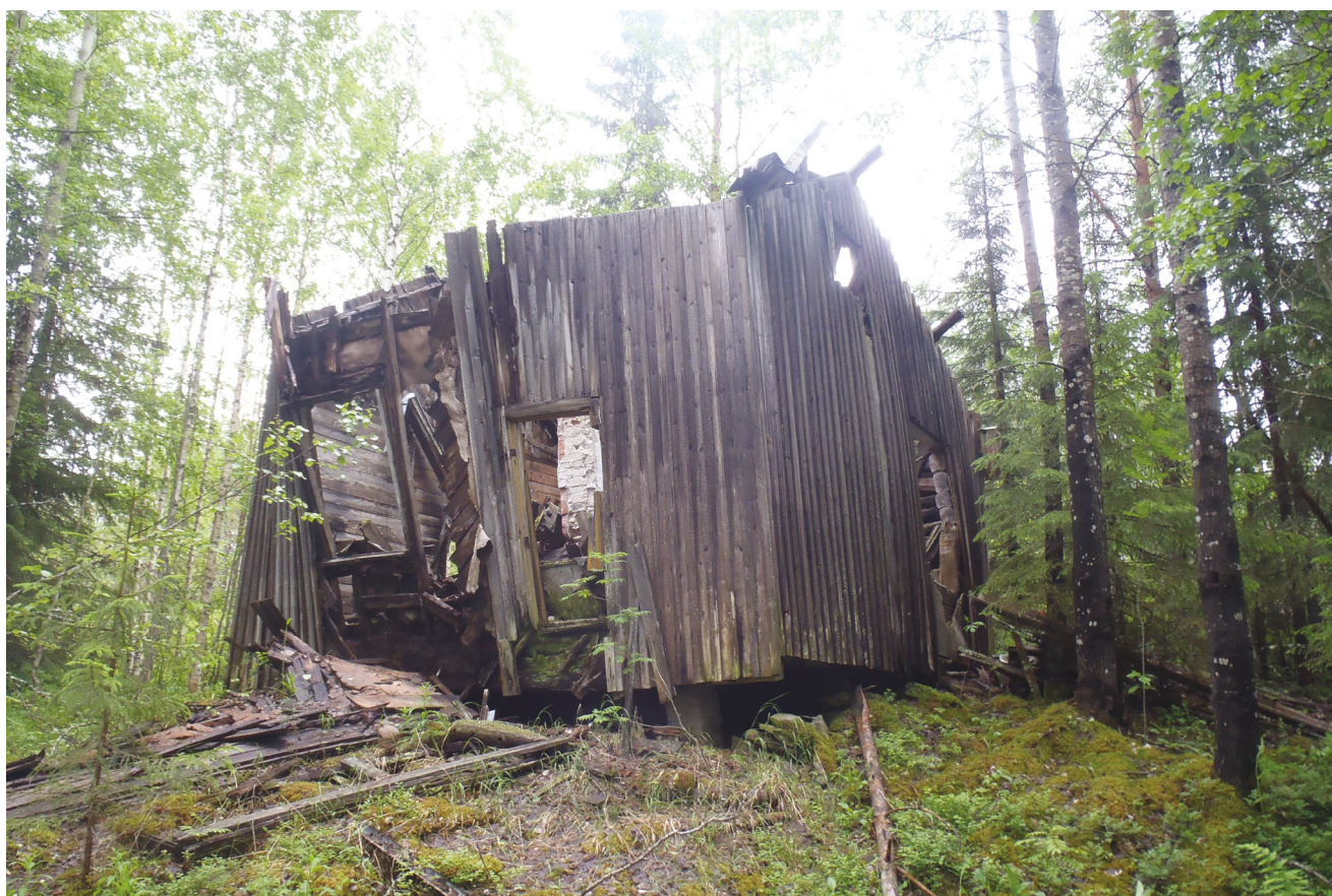
179894.P1010013. Kämppeä on noin 7x7 m laajuinen hirsiperustainen rakennus. Se lepää luonnonkivillä, joita on alarinteen puolella päällekkäin yli puolenmetrin kekona.
