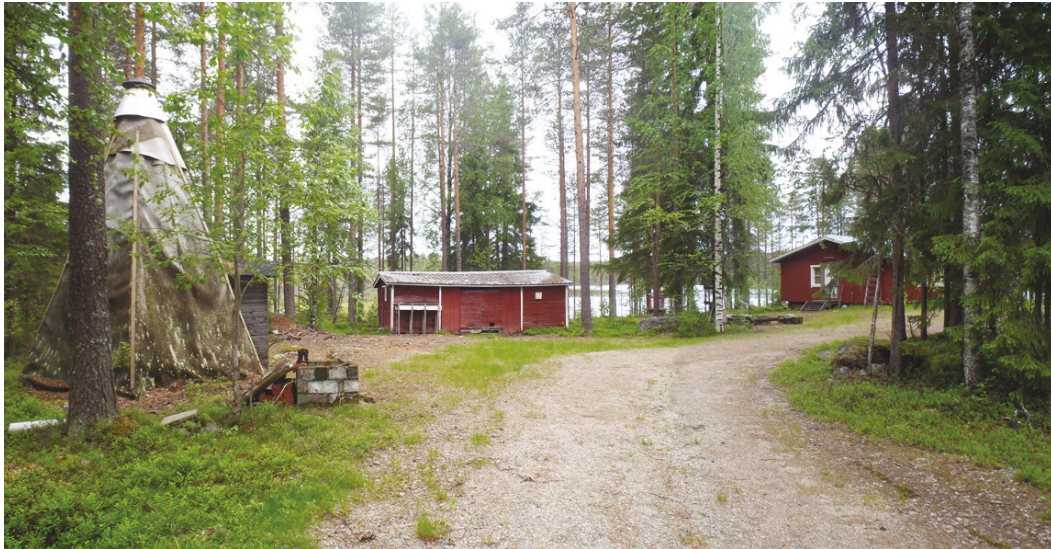
Kuva: 180336.P1010009-10. Kangaslammin kämpälle johtavan tien vasemmassa reunassa vuokralaisen pystyttämä kota, sen takana vaja, etualalla toinen vaja ja taustalla kämpän päärakennus. Takana häämöttää Kangaslampi.
