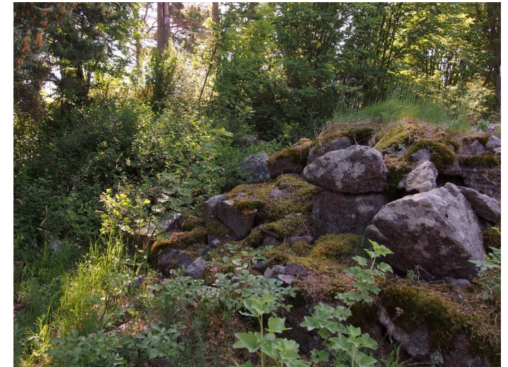
Muurirakenne muuttuu valliksi.
