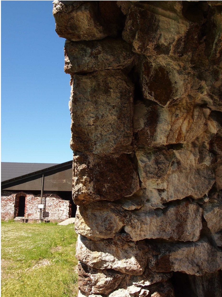
Vasemmalla holvikaaren jonkin verran rapautunutta sisäpintaa, oikealla itäisimmän kasematin hovia, jossa on vanhoja vesivuodon jälkiä tippukivineen. Holvin muuraus on huuhtoutunut osin laastittomaksi ja joidenkin kivien kiinnittyminen on tarkastettava.
