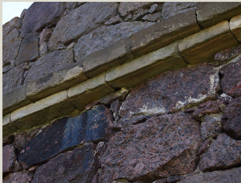
Kaksinkertainen kalkkikivinen muurilista (ns. ”hieno cordon”) bastioni Röökin ulkosivulla. Molempien listojen alanurkkaan on hakattu vesiura.
