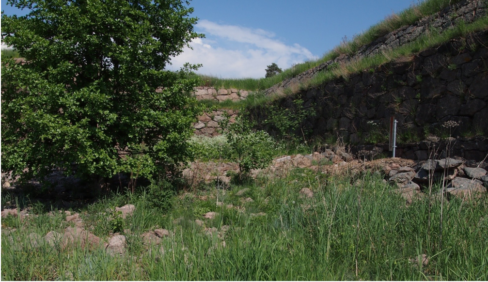
Pohjois-eteläsuuntainen pitkä muuri— varsinkin alavarvien kivissä on liikkumista.
