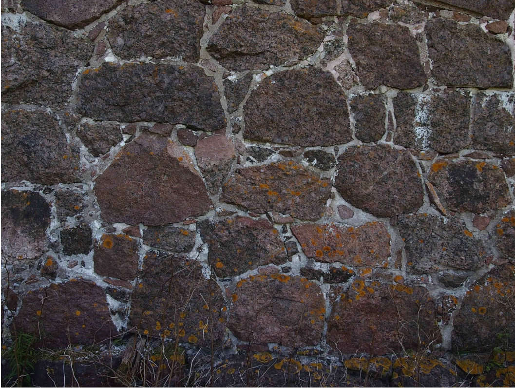
Pohjoiskurttiin monessa vaiheessa korjattua muuria
