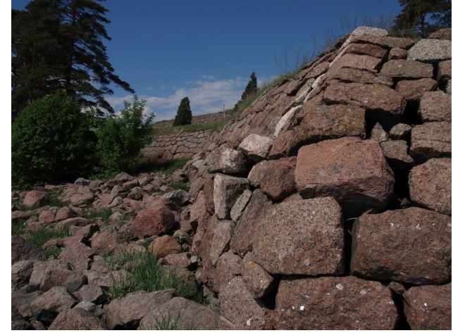
Jakson itäosassa on ensimmäistä sortunutta aluetta lukuun ottamatta kohtuullisen hyväkuntoista muuria, jossa paikallisia sortumia.
