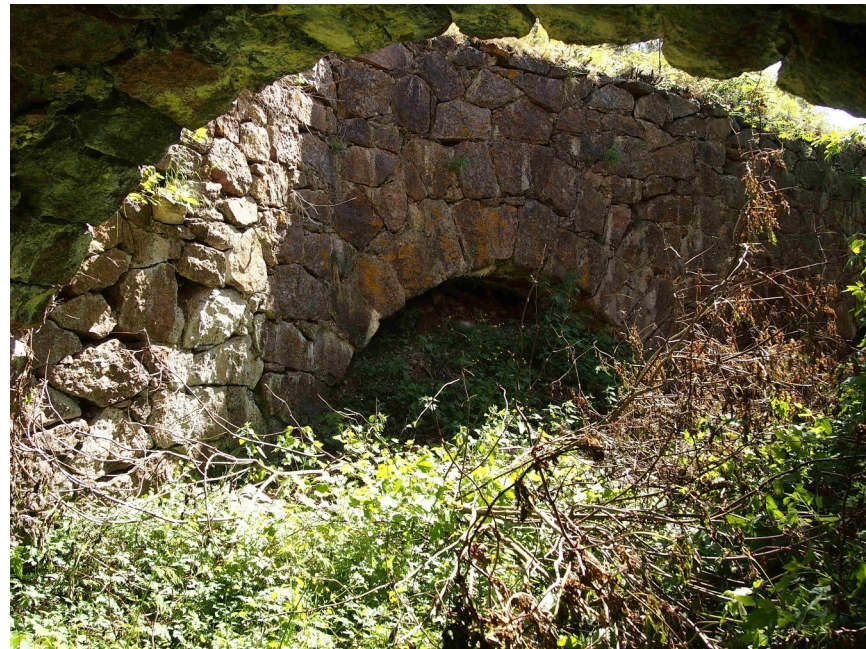
Bastionipihan muureissa on vakavia muodonmuutoksia
