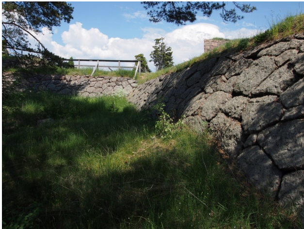
Läntisimmässä jaksoon kuuluvassa muurissa on vähän pullistumaa, mutta muuten kunto on kohtuullisen hyvä.
