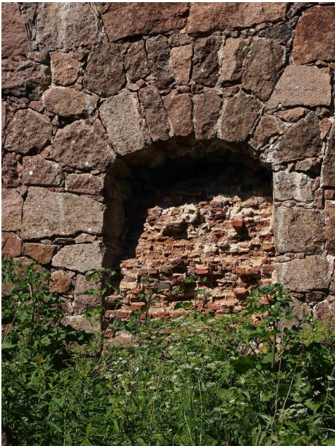
Linnoituksen aikana suljettu aukko siivessä
