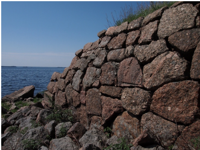
Jakson itäisimmät muurit. Muurin rakenne muuttuu vaaralliseksi kärkeä lähestyttäessä. Oikeanpuoleisessa kuvassa näkyy vähitellen pullistuva muoto
