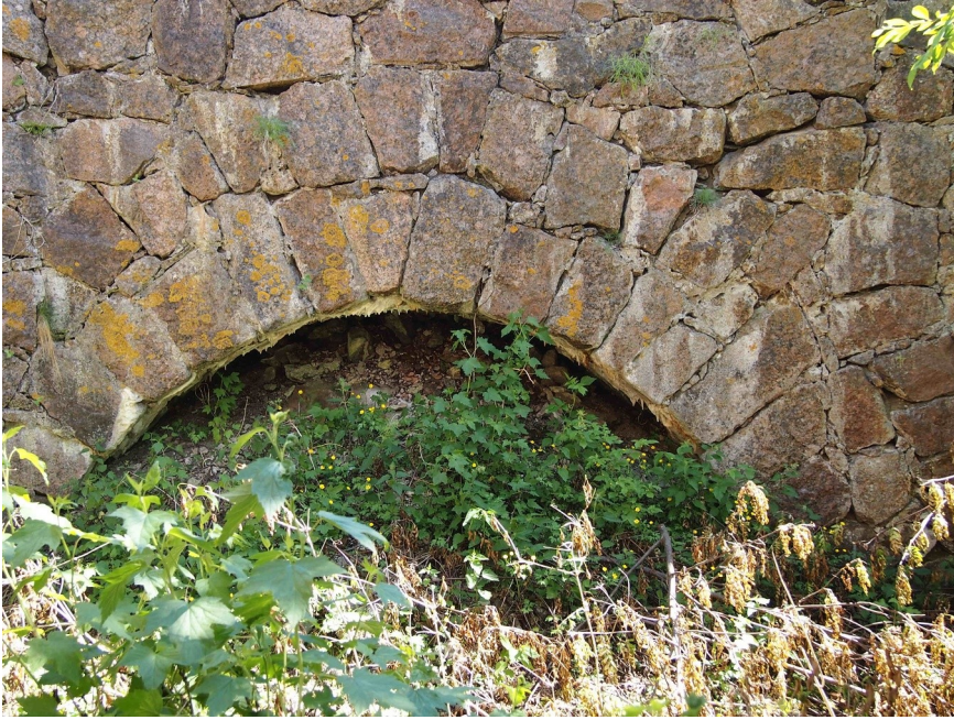
Bastionipihan muureissa on vakavia muodonmuutoksia
