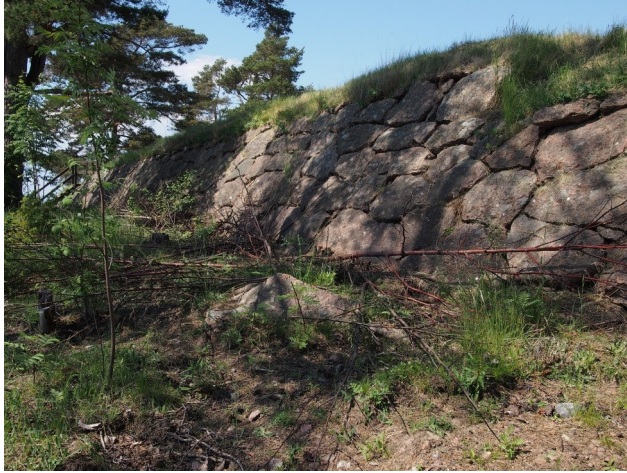
Jakson itäosassa on ensimmäistä sortunutta aluetta lukuun ottamatta kohtuullisen hyväkuntoista muuria, jossa paikallisia sortumia.
