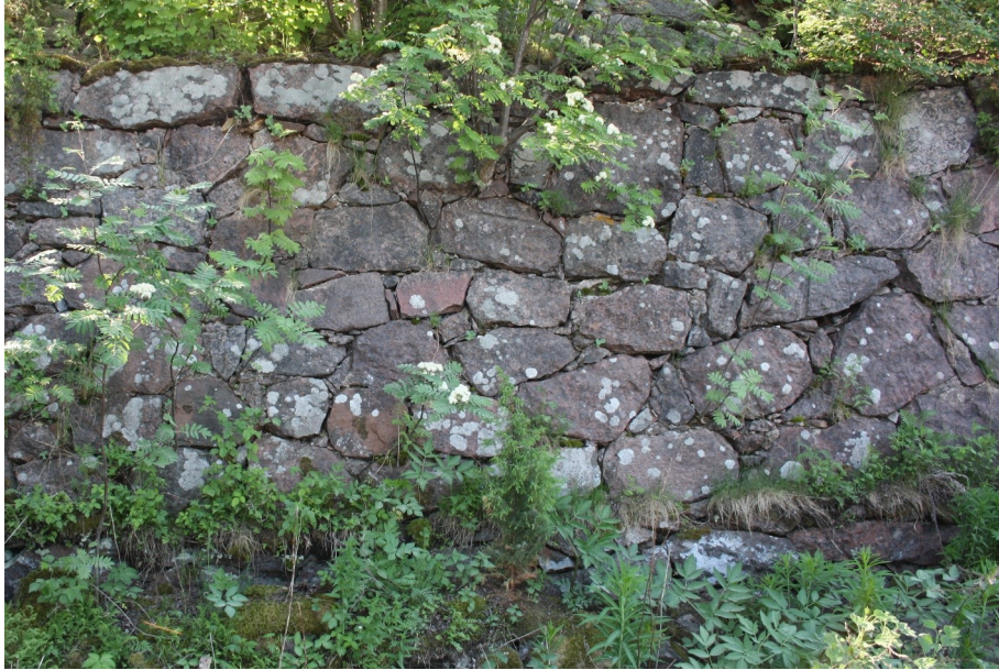
Jakson länsiosassa on huolellista limitystä. Kuvassa oikealla sortunut nurkka ja muurin pystyhalkeama, jonka syy on epävarma.
