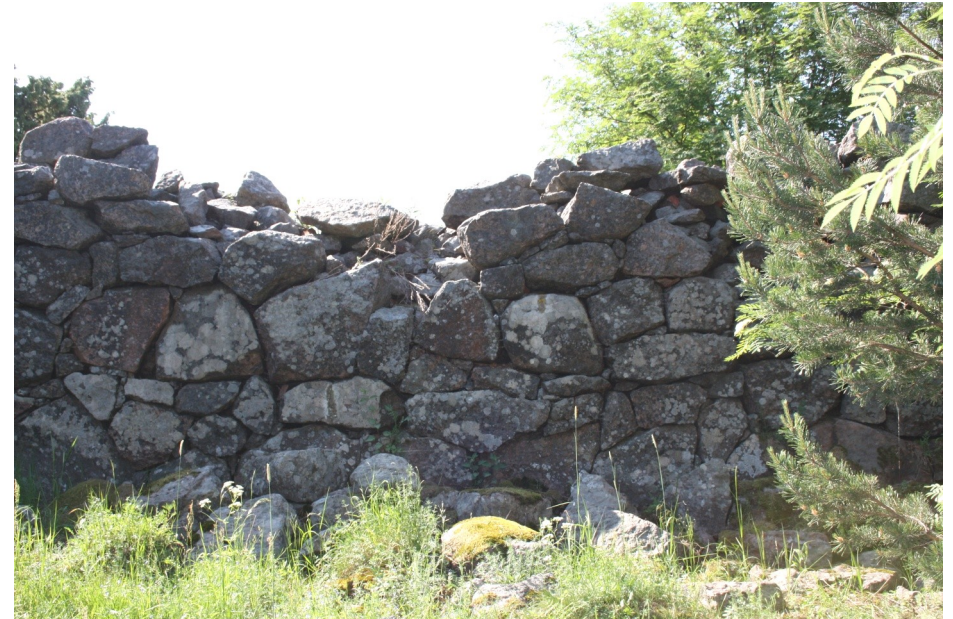
Suoran jakson keskivaiheilla oleva paikallinen sortuma sekä sen itäpuolelta alkava pullistumajakso. Kasvillisuus on runsasta muurin edustalla.
