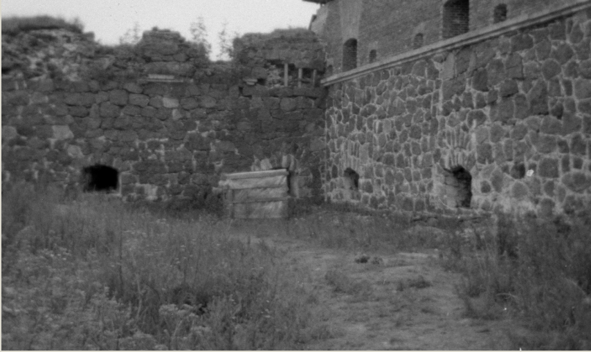
Bastioni Qveckfeldtin länsikylki 1970 - luvulla (vasemmalla) ja vuonna 2013. Linnoituksen rauniovaiheen aikana vaurioita kärsivät erityisesti ampumatasanteiden rintamuurit, joita tässäkin tapauksessa on jouduttu täydentämään restauroinnin yhteydessä. Kalkkikivisiä muurilistoja oli ennen korjausta jäljellä vain lyhyt jakso länsikyljen keskellä.
