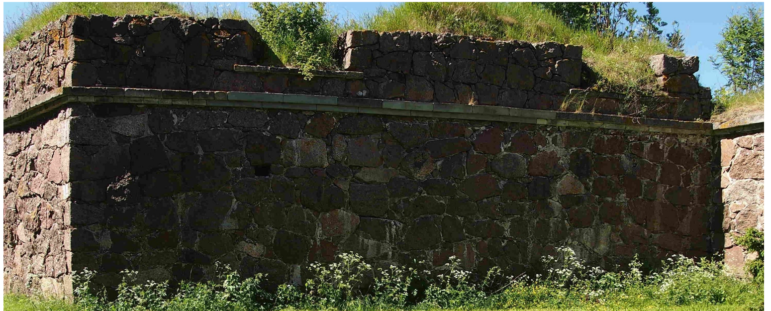
Schantzin itäkyljessä on uutta ja vanhaa muurilistaa
