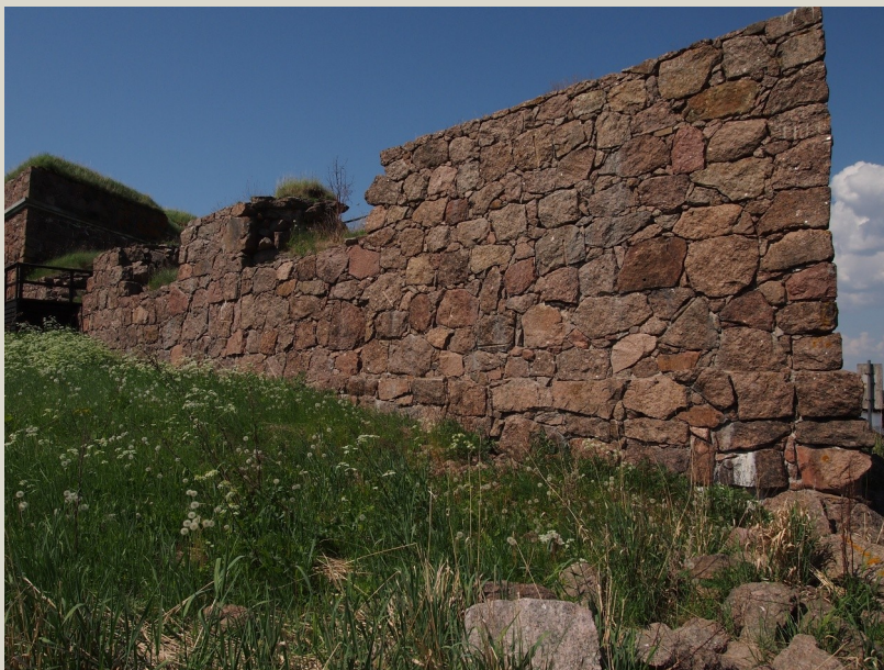
Pohjoisen esivarustuksen itäpuoli. Muurikivet ovat tasakokoisia ja värisiä sekä säännöllisesti ladottuja.
