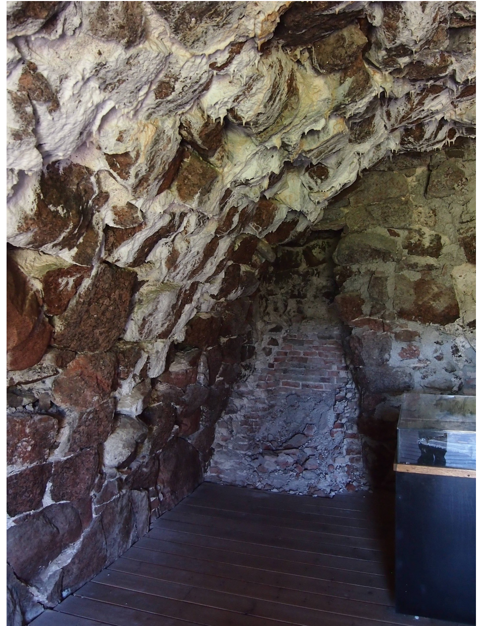
Vasemmalla holvikaaren jonkin verran rapautunutta sisäpintaa, oikealla itäisimmän kasematin hovia, jossa on vanhoja vesivuodon jälkiä tippukivineen. Holvin muuraus on huuhtoutunut osin laastittomaksi ja joidenkin kivien kiinnittyminen on tarkastettava.
