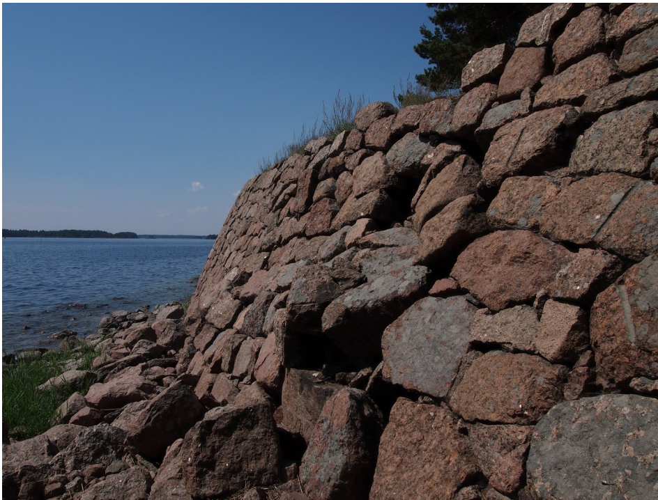
Jakson itäisimmässä muurissa on vaarallisia paikallisempia sortumia.
