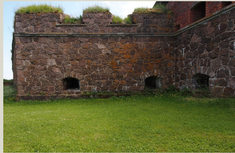
Bastioni Qveckfeldtin länsikylki 1970 - luvulla (vasemmalla) ja vuonna 2013. Linnoituksen rauniovaiheen aikana vaurioita kärsivät erityisesti ampumatasanteiden rintamuurit, joita tässäkin tapauksessa on jouduttu täydentämään restauroinnin yhteydessä. Kalkkikivisiä muurilistoja oli ennen korjausta jäljellä vain lyhyt jakso länsikyljen keskellä.
