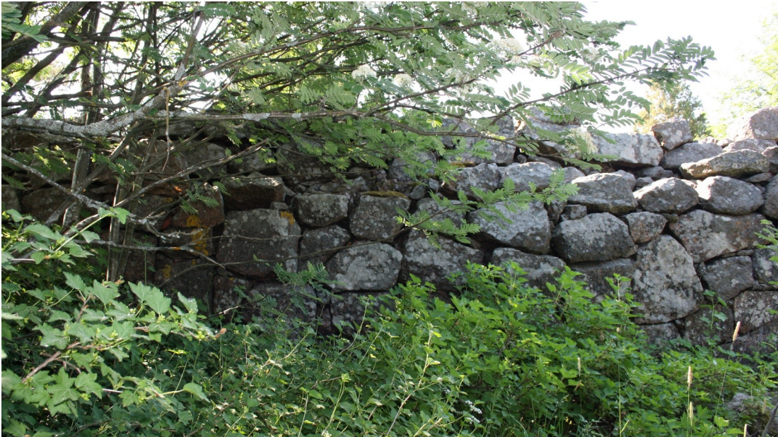
Suoran jakson keskivaiheilla oleva paikallinen sortuma sekä sen itäpuolelta alkava pullistumajakso. Kasvillisuus on runsasta muurin edustalla.
