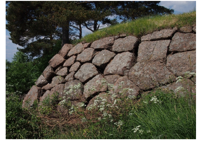
Läntisempi kärki kuuluu muodonmuutoksista huolimatta luokkaan III.
