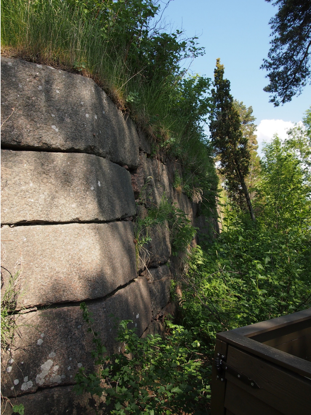
Vasemmalla: pitkän pohjoisen rantamuurin itänurkka. Poikkeuksellisen suuret, tasapintaiset ja nurkassa muotoon hakatut muurikivet.
