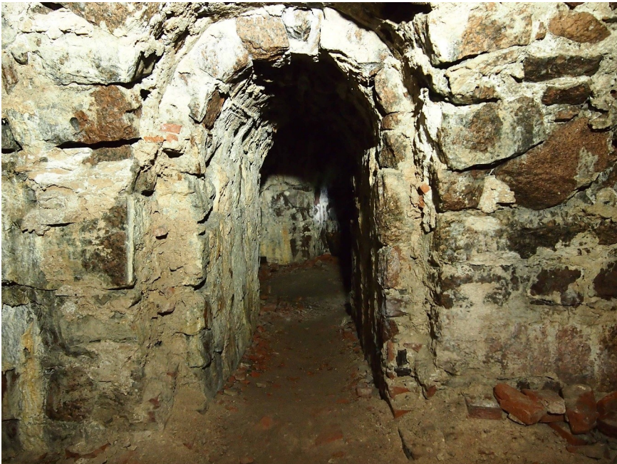
Kasematteja yhdistävät holvatut käytävät ovat kohtuullisen hyvässä kunnossa
