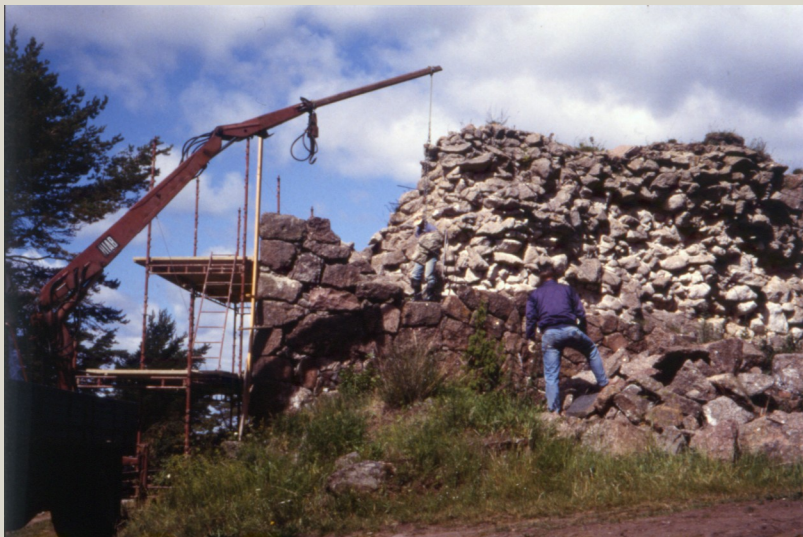
Bastioni Schantzin kaakkoiskärjen muurin sortunutta pintakiveystä muurataan uudelleen 1990-luvun puolivälissä. Valumuurin runsaskivinen ydinosa on vielä näkyvissä usean metrin korkeudelta. Suurin osa korjaustyössä tähän saakka käytetyistä muurikivistä on saatu saarella olevista sortumakasoista, ja uutta kivimateriaalia on tuotu ainoastaan muurilistoihin. MV.
