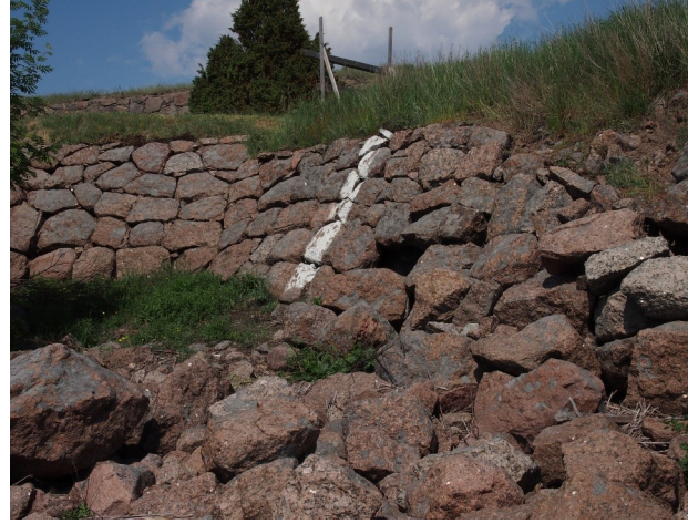
Jakson itäosassa on ensimmäistä sortunutta aluetta lukuun ottamatta kohtuullisen hyväkuntoista muuria, jossa paikallisia sortumia.
