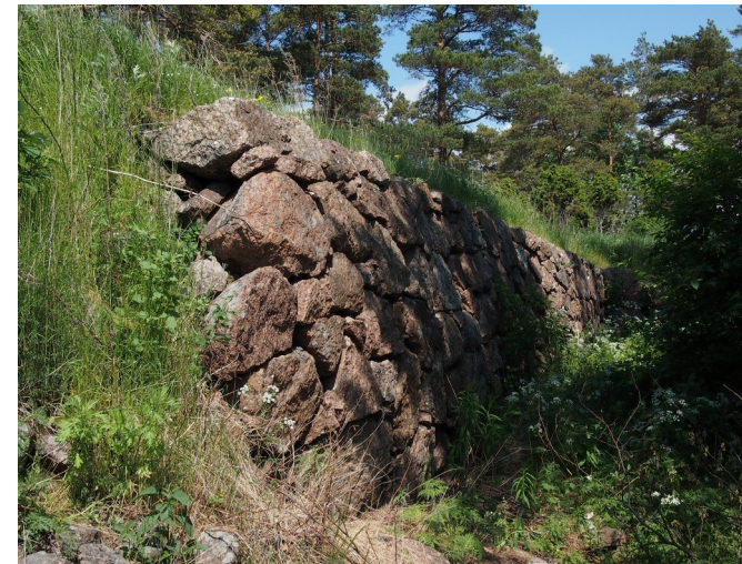
Jakson itäisimmät muurit. Muurin rakenne muuttuu vaaralliseksi kärkeä lähestyttäessä. Oikeanpuoleisessa kuvassa näkyy vähitellen pullistuva muoto
