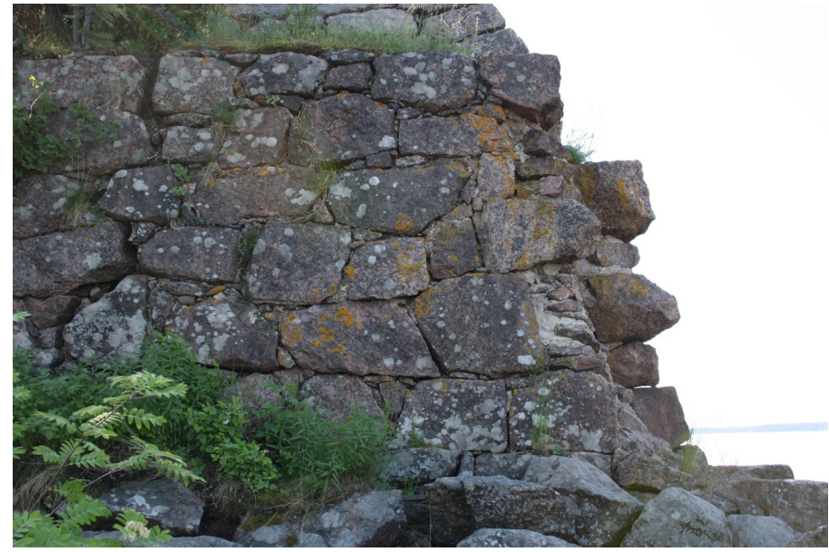
Jakson länsiosassa on huolellista limitystä. Kuvassa oikealla sortunut nurkka ja muurin pystyhalkeama, jonka syy on epävarma.
