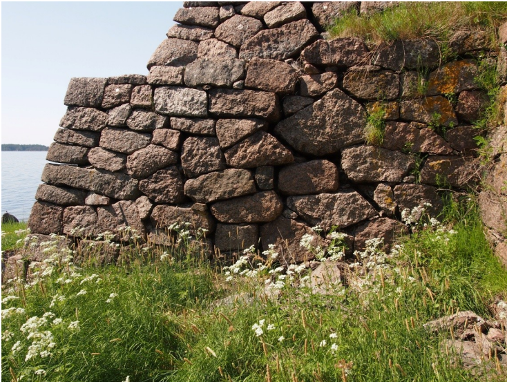
Kärjen laasti on rapautunut, ja alueella on suuria muodonmuutoksia.
