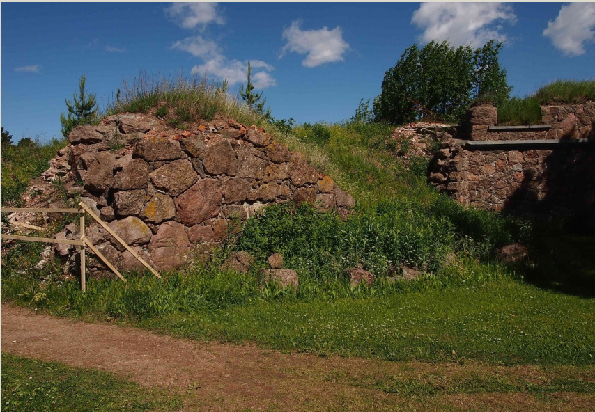
1990 - luvulla otettiin laastikorjausten ohella käyttöön restaurointimenetelmiä, joilla pyrittiin vähentämään puuttumista alkuperäisiin rakenteisiin. Päälinnoituksen itäisen kasarmirakennuksen raunion tiilirakenteet peitettiin linnoituksen sisäpihalta kaivetulla purkumassalla (vasemmalla). Läntisen leipomo- ja varastorakennuksen tiilimuurit suojattiin laajalla puu- ja teräsrakenteisella suojakatoksella.
