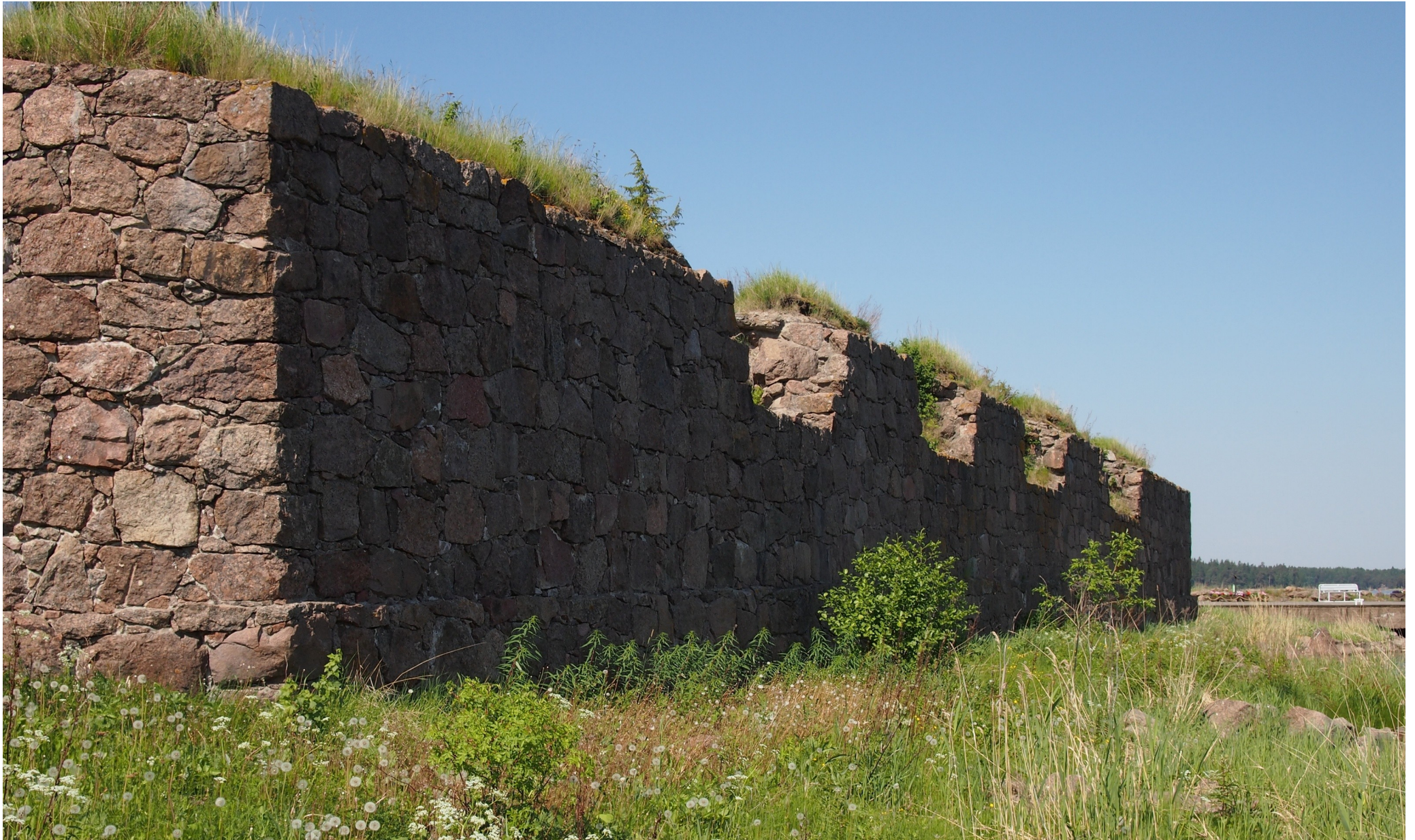
Kreneloitu reilun 53 metrin pituinen siipimuuri kuvattuna idästä
