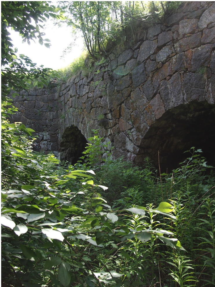
Bastioni Röökin bastionipihan muurit tulevat luultavasti sortumaan
