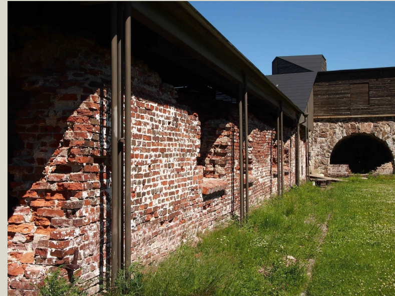
1990 - luvulla otettiin laastikorjausten ohella käyttöön restaurointimenetelmiä, joilla pyrittiin vähentämään puuttumista alkuperäisiin rakenteisiin. Päälinnoituksen itäisen kasarmirakennuksen raunion tiilirakenteet peitettiin linnoituksen sisäpihalta kaivetulla purkumassalla (vasemmalla). Läntisen leipomo- ja varastorakennuksen tiilimuurit suojattiin laajalla puu- ja teräsrakenteisella suojakatoksella.
