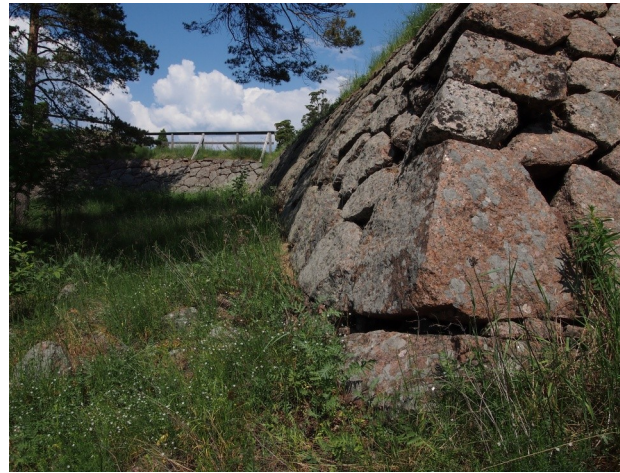
Läntisempi kärki kuuluu muodonmuutoksista huolimatta luokkaan III.
