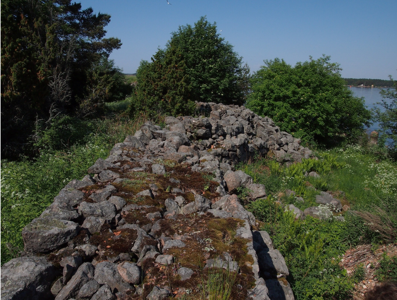
Muuri kuvattuna idästä sortuneeseen tenaljiin päin.
