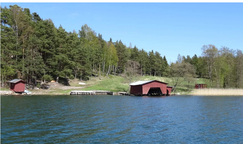
Kuva 6. Biskopsön rannan paalutettu laituri ja venevaja. ©Pintafilmi Oy/Eve Salo
