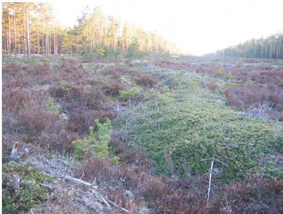
Kuva 21. Kaapelikaivantoa linjan pohjoispuolella. Kuvattu koilliseen.
