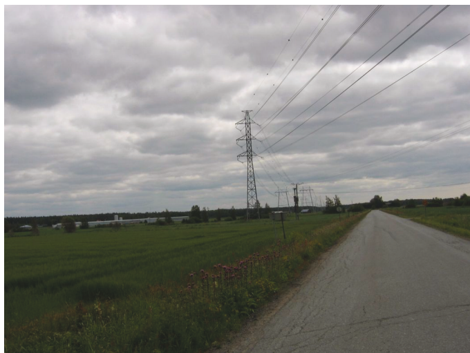
Kuva 3. Voimajohtolinjaus Kristiinankaupunki-Närpiö. Peltoaukeaa Pjelaxin eteläpuolella. Kuvattu etelään.
