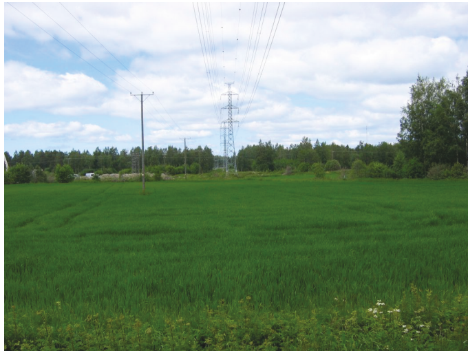
Kuva 8. Voimajohtolinjaus Kristiinankaupunki-Närpiö. Peltoaukeaa Kalaxin eteläpuolella. Kuvattu etelään.
