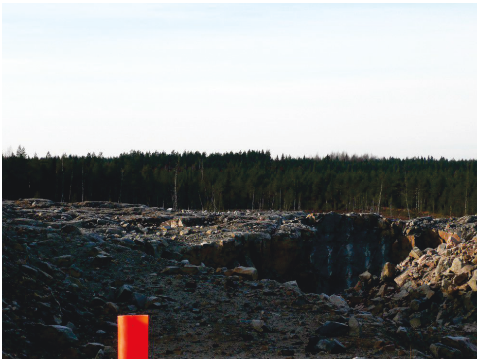
Kuva 3. Kalliolouhos Tuppukankaan pohjoisosassa, kuvattu länteen.
