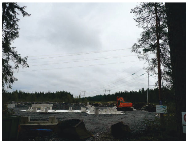
Kuva 18. Merijärven uuden sähköaseman rakennustyömaa liittymiskohdan lounaispuolella.
