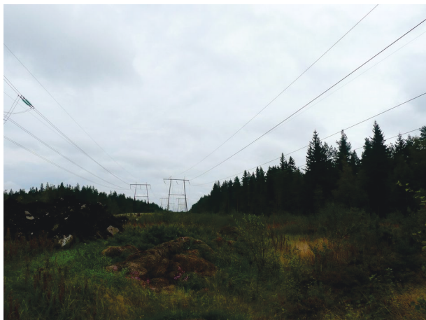
Kuva 17. Liittymiskohta Merijärven sähköaseman pohjoispuolella kuvattu pohjoiseen.
