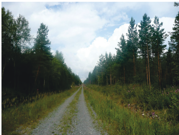
Kuva 5, parannettava metsätie kuvattu luoteeseen.
