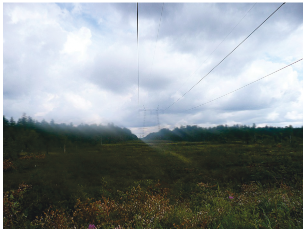
Kuva 2, nykyinen voimalinja Hankilannevan kohdalla kuvattu luoteeseen.
