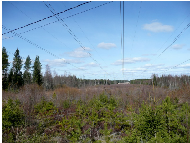
Kuva 15 Rajaperän kohdalla koilliseen.
