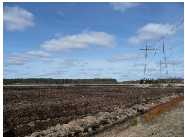
Kuva 14 Patakorven kohdalla koilliseen.
