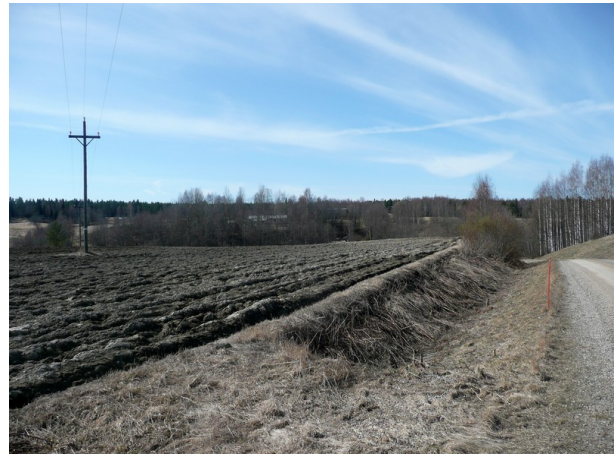
Kuva 6. Maakaapelin linja Lestijoen itäpuolella (VE1).
