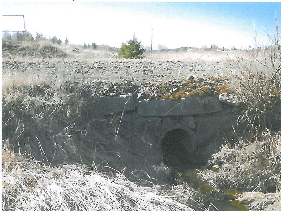
Kuva 18. Siltarumpu, jonka päällä kulkee historiallinen tielinja. Kuvattu kaakosta. (Kuva: Vesilahti Kaakila-Kaltsila 2014: 7)
