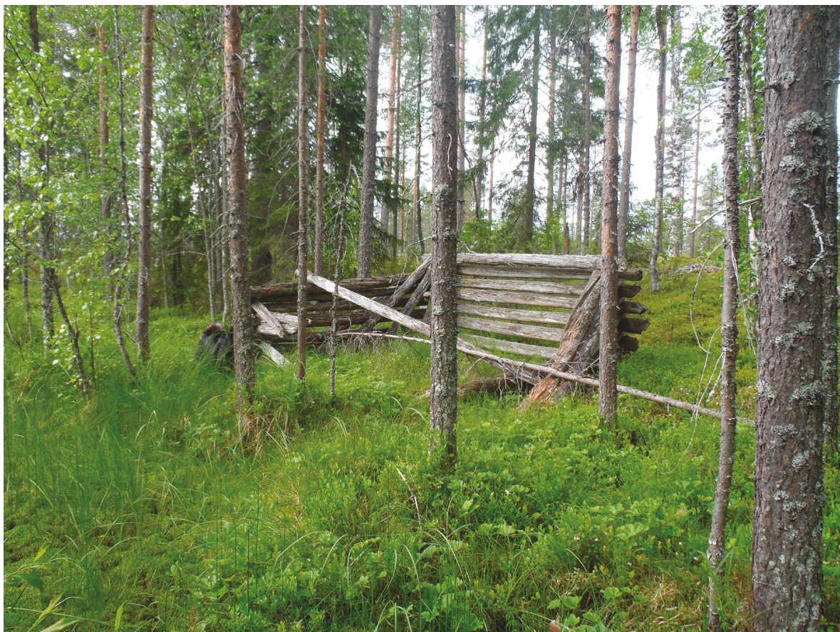
172779.3.096: Niittyladosta on jäljellä kehikkoa, jossa on parhaimmillaan kahdeksan hirsikertaa. Kolme kattolautaa nojaa edelleen seinähirsiä vasten.
