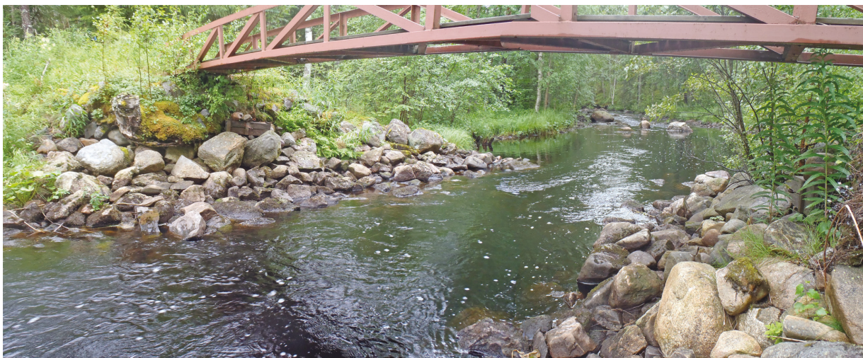
Yllä: 172890.6.1010152-153. Tuomaankoski uittopadon jäänteitten kohdalla.
