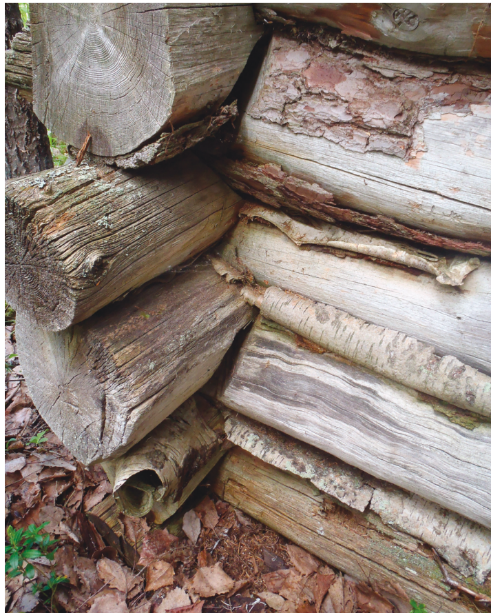
172435.3.066: Rakennuksen nurkkasalvoksessa on edelleen nähtävillä hirsien väliin laitettua tuohtia.
