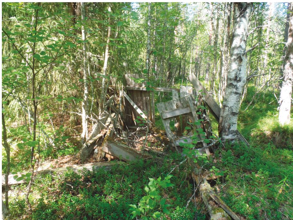
Alla: 172414.7.1010095. Rakennelma on hyvin säilynyt. Vessa on lautarakenteinen, tukiosat on tehty parruista. Rakennus on jossain vaiheessa romahtanut.
