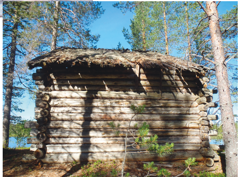
172192.5.260: Rakennuksessa on kaksi huomattavan suurta ikkuna-aukkoa. Järven puolinen ikkuna sivuseinällä on 0.5 x 0.5 m, peräseinän ikkuna puolestaan 0.9 x 0.6 m. Tämän aukon yläreunassa on hiiltynyt lovi, joka lienee peräisin alkuperäisestä savuräppänän paikasta.
