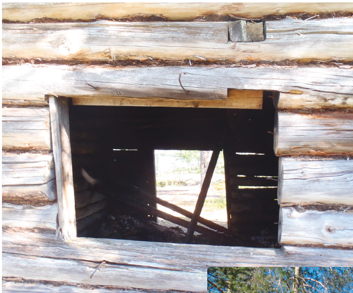
172192.5.254-256: Panoraamakuva saunan sisätiloista oviaukolta katsottuna. Molemmissa ovi-nurkissa on ollut kiukaat. Välikatosta on sisään romahtanut pari hirttä. Suurempi ikkuna-aukko on peräseinällä. Toinen, pienempi ikkuna, on ollut ovelta katsottuna oikealla. Vasemman peränurkan äärellä on poron luita.
