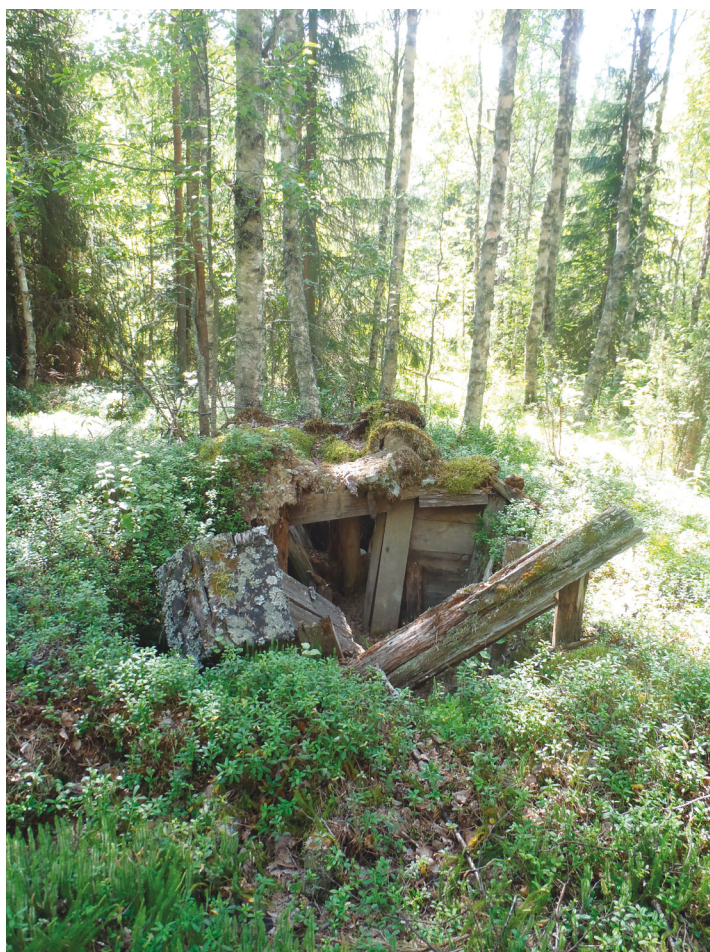
Yllä: 172411.7.1010087. Viitisentoista metriä kämpältä alarinteeseen on hyvin säilyneet kellarin jäännökset. Kellari on ollut hirsistä ja laudoista tehty, ja siinä on ollut katteena turve.
