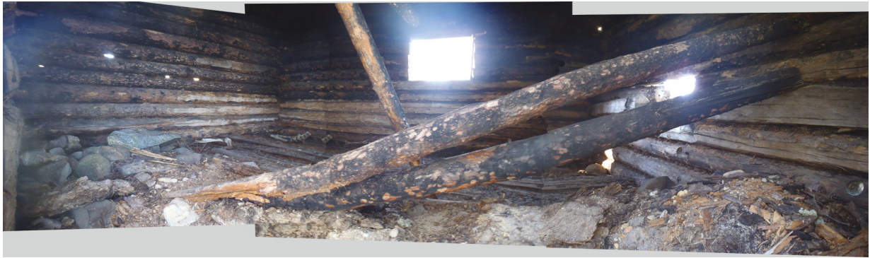
172192.5.254-256: Panoraamakuva saunan sisätiloista oviaukolta katsottuna. Molemmissa ovi-nurkissa on ollut kiukaat. Välikatosta on sisään romahtanut pari hirttä. Suurempi ikkuna-aukko on peräseinällä. Toinen, pienempi ikkuna, on ollut ovelta katsottuna oikealla. Vasemman peränurkan äärellä on poron luita.
