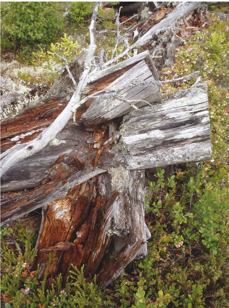
Kuva yllä: 138900.3.016. Tervasauna on ollut hirsinen rakennus, 3,5 x 3 m. Siitä on edelleen jäljellä useita hirsikertoja.
