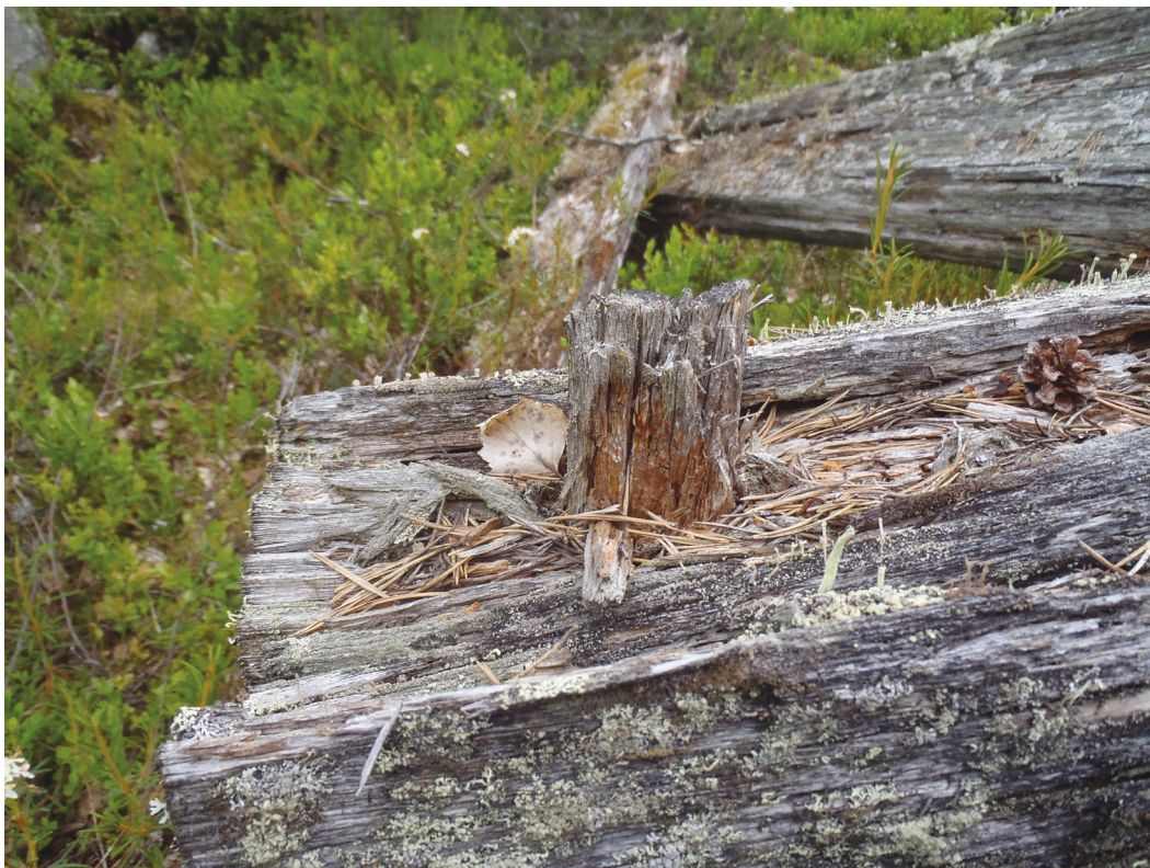
Kuva alla: 172199.P1010015. Akonkankaan tervasaunan ovensuun hirret oli puuta-peilla yhdistetty toisiinsa.
