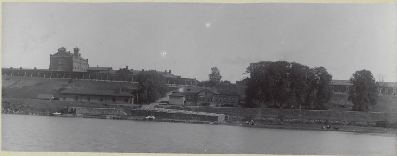
L:rauman ent. linnoituksessa sijaitseva työväntila, sen virkamiesten asunnat sekä aivan samalla vallilla.
