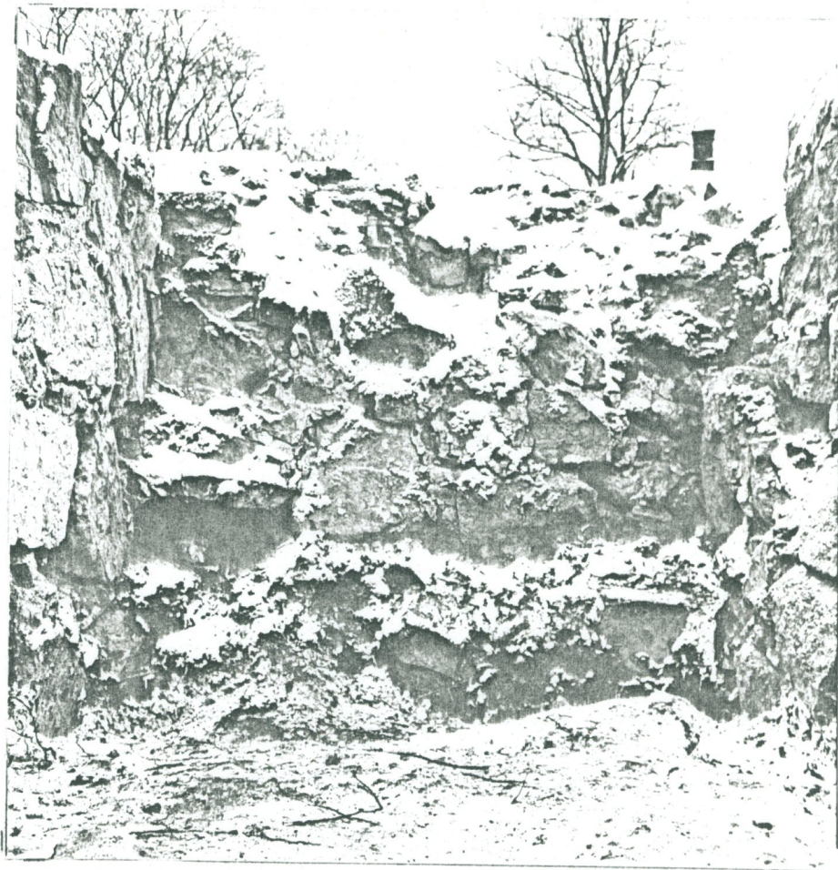
B 9. Kellarin länsiseinä
