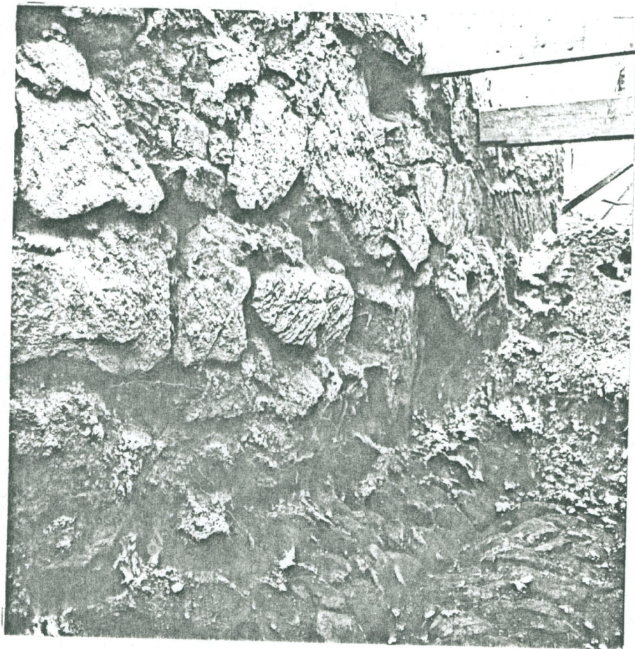
B 16. Kellarin pohjoisseinän itäosaa
