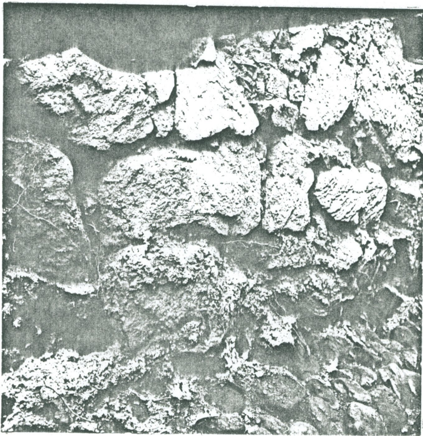
B 14. Kellarin pohjoisseinän itäosaa
