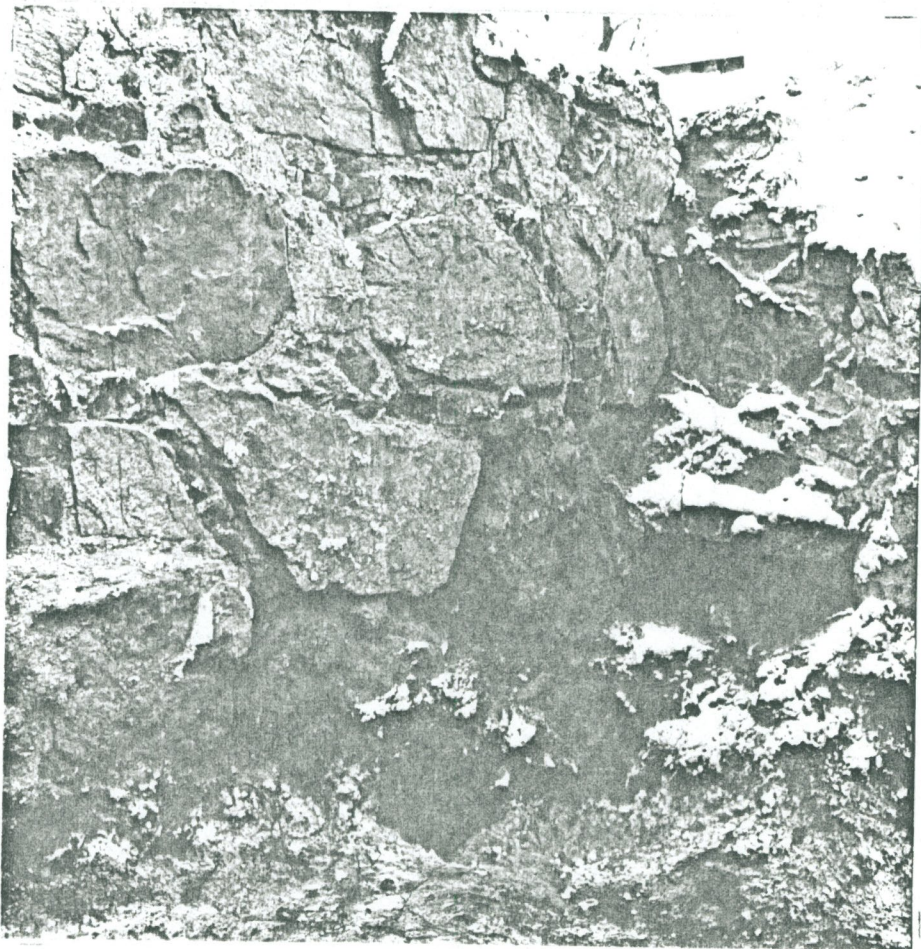
B 8. Kellarin eteläseinän harmaakivimuurausta ja länsiseinän viemäriaukko
