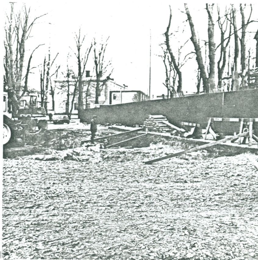
B 1. Yleiskuva Tuomiokirkon kehämuuriin liittyvän rakennuksen alueesta lännestä kuvattuna
