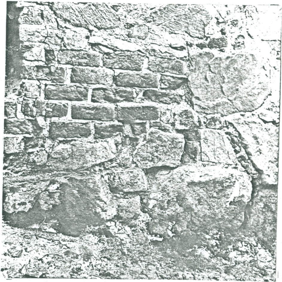
B 7. Kellarin eteläseinää lähikuvassa
