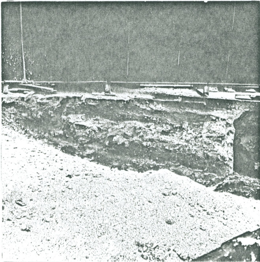
24. Rakennuksen pohjoismuuria ja siinä oleva portaikko
