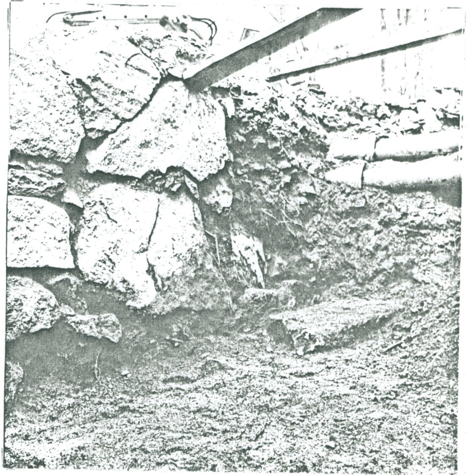
B 13. Kellarin pohjoisseinää
