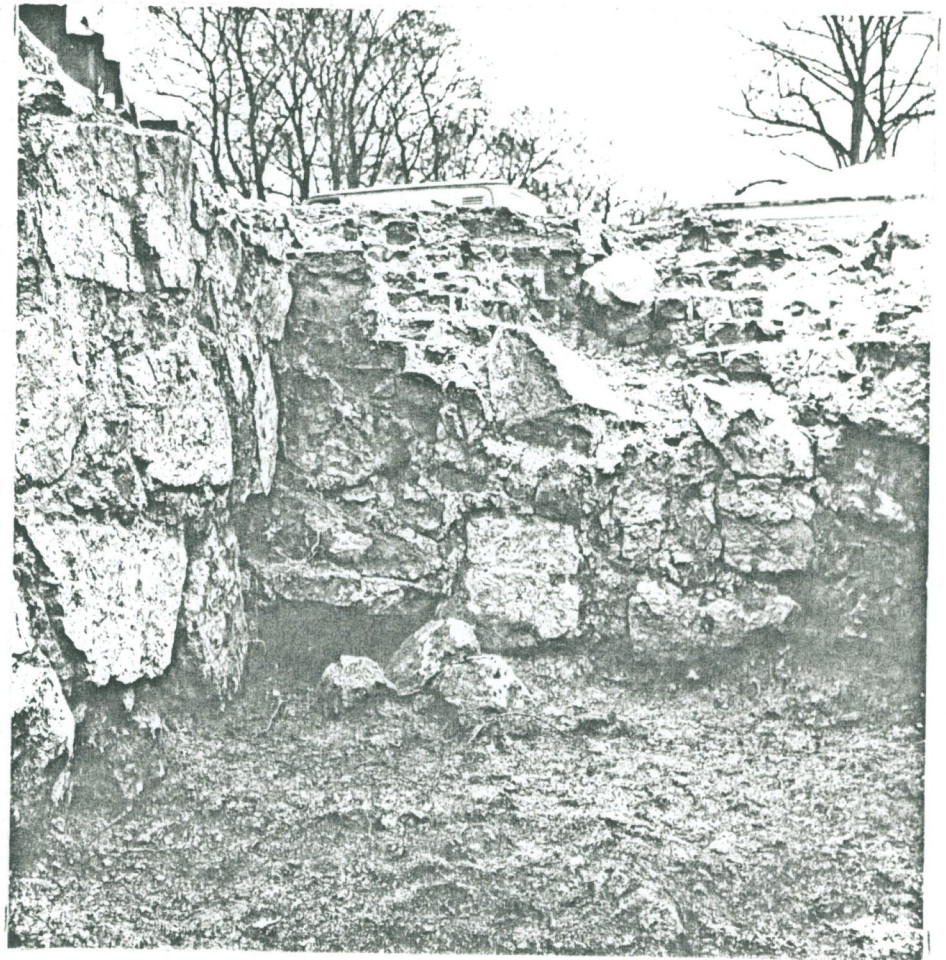
6. Kellarin länsiseinä, viemäriaukon suu vasemmalla
