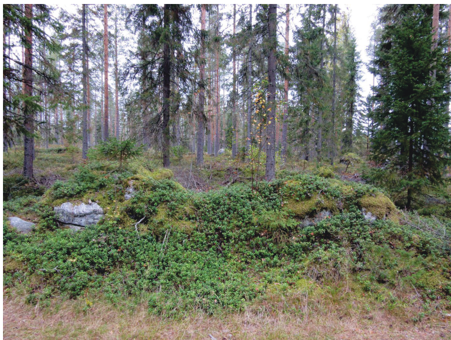
Rakennuksen perustus kuvattu etelästä.
