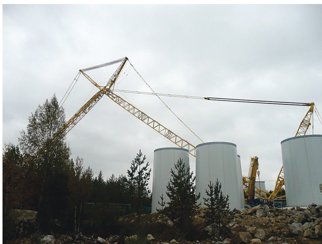
Kuva 12. Tuulivoimalan rakennustyömaa Salon hankealueen pohjoisosassa.
