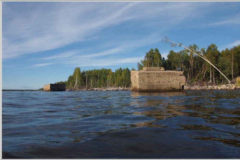
Kuva 11. Kuusiluodon sahan lastauslaiturin vanhoja betoniperustuksia saaren länsipuolella. Sijainti ETRS89-WGS-84: 65°44.888' P 24°14.229' I (± 5 metriä). Kuva Rami Kokko.
