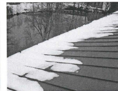
Alalappeen palapeltikate, jonka ylätaiteessa lumiesteet, joihin lumi ja jää patoutuvat. Räystäsalueen jalkarännit ovat taipuneet, osin murtuneet, eivätkä ne ohjaa valumavesiä hallitusti oikeaan suuntaan.
