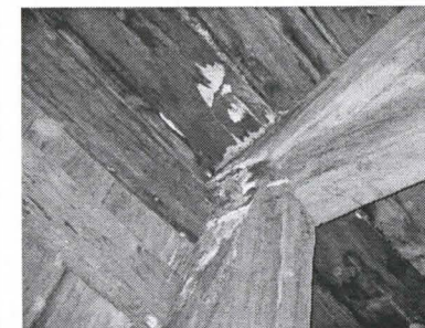
Vanhoja vesikatteen uralautoja ullakolla. Vesivuodoista aiheutuneita lahovaurioita ja lahottajasiemeniä kantavissa rakenteissa.
