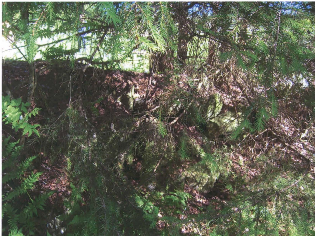
Kuva 6. Kuvan 5. rakennuksen perustukset kuvattuna kuopanteen keskeltä.
