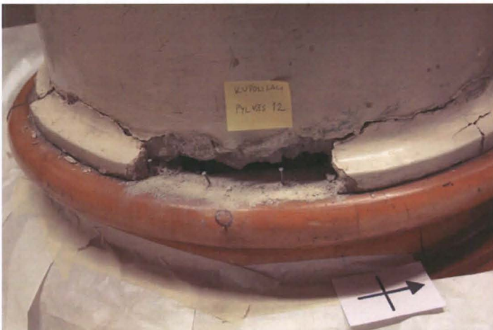
Kupolialin pylväs 12, jossa kalkkilaastikorjaus ja nauloja.
