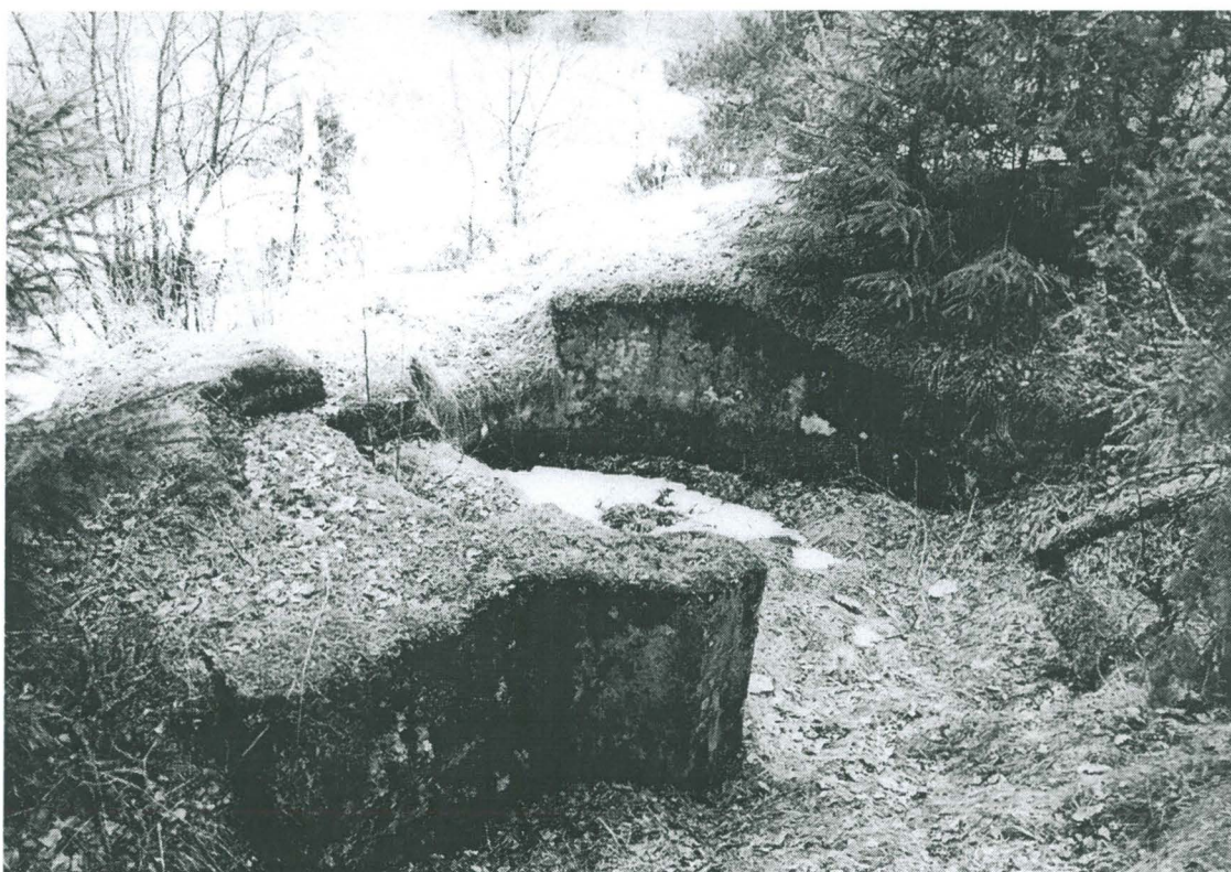
Urjalankylä. Betonirakenteinen tulipesäke ns. Roopetinmäellä. Kuva: V. Adel/Tampereen museot
