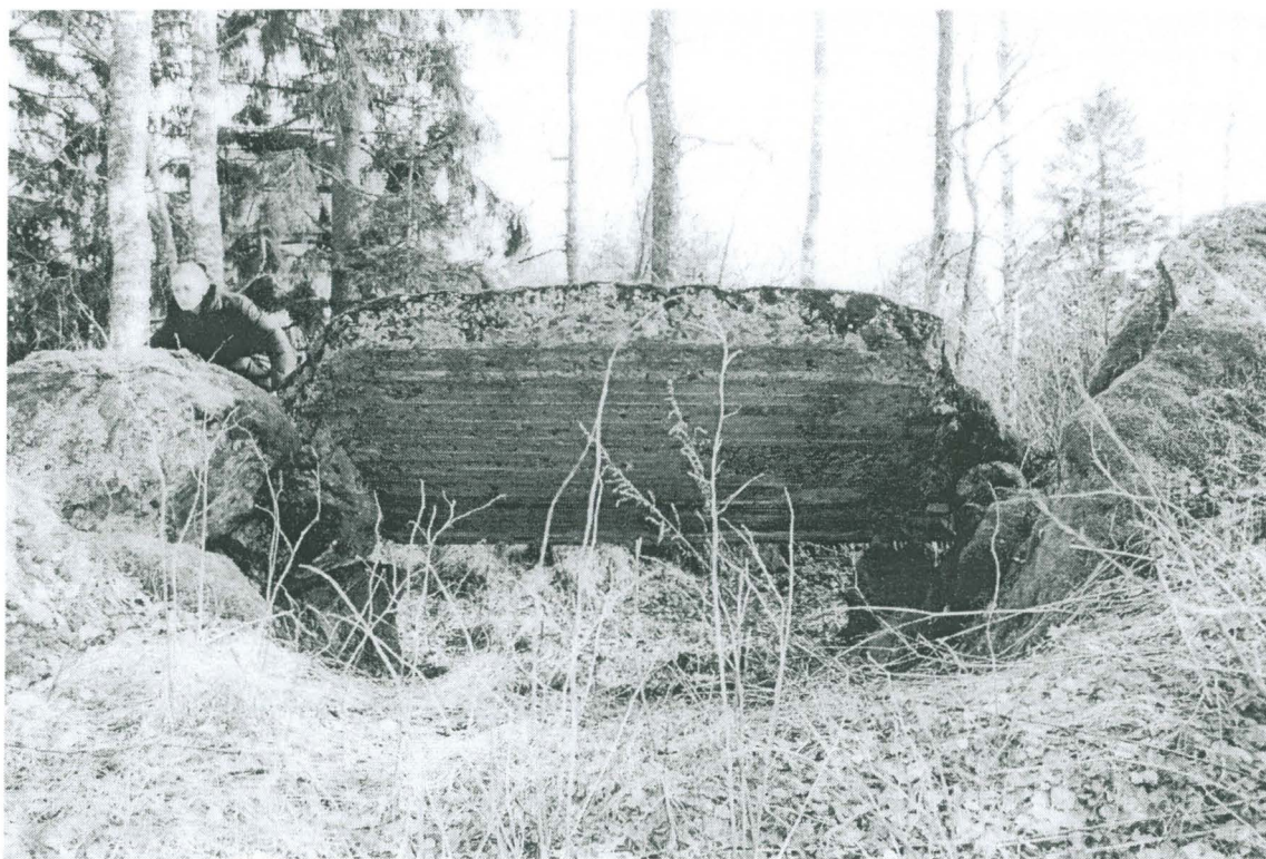
Kuva 125157: 14. Betonikattoinen tuliasema koulun NW-puolella. NW
