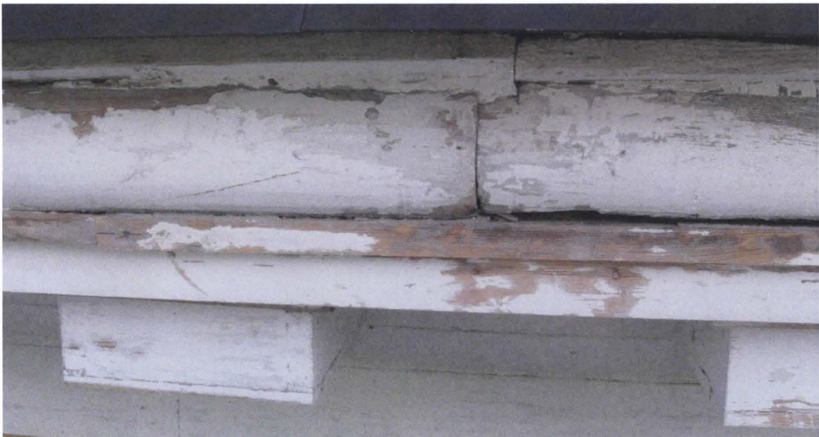
Näytteidenottoalue pohjoisen puoleisella julkisivulla.
