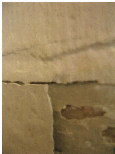
Kuvat 16 ja 17. Lateksimaali irti seinästä ja hilseilee.
