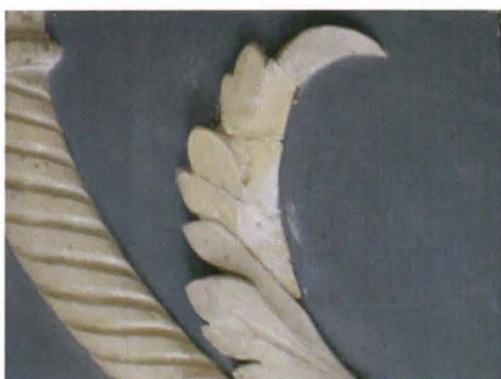
Kuva 49. Liitu-liisteri paikkauksia.
