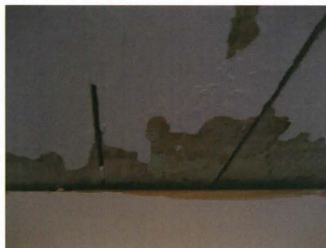
Kuva 23. Laatta irrotettu katosta.
