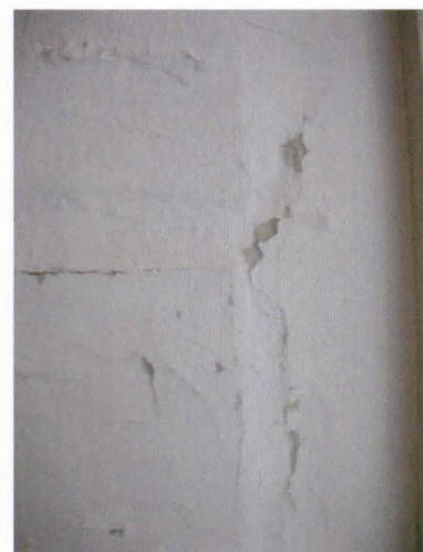
Kuvat 16 ja 17. Lateksimaali irti seinästä ja hilseilee.
