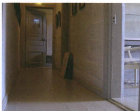
Kuva 21. Oikeanpuoleisen käytävän seinän retusointimaalaus valm
