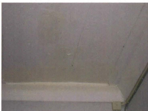
Kuva 24 ja 25. Suuri alue paperoituna, paikattuna ja maalattuna
